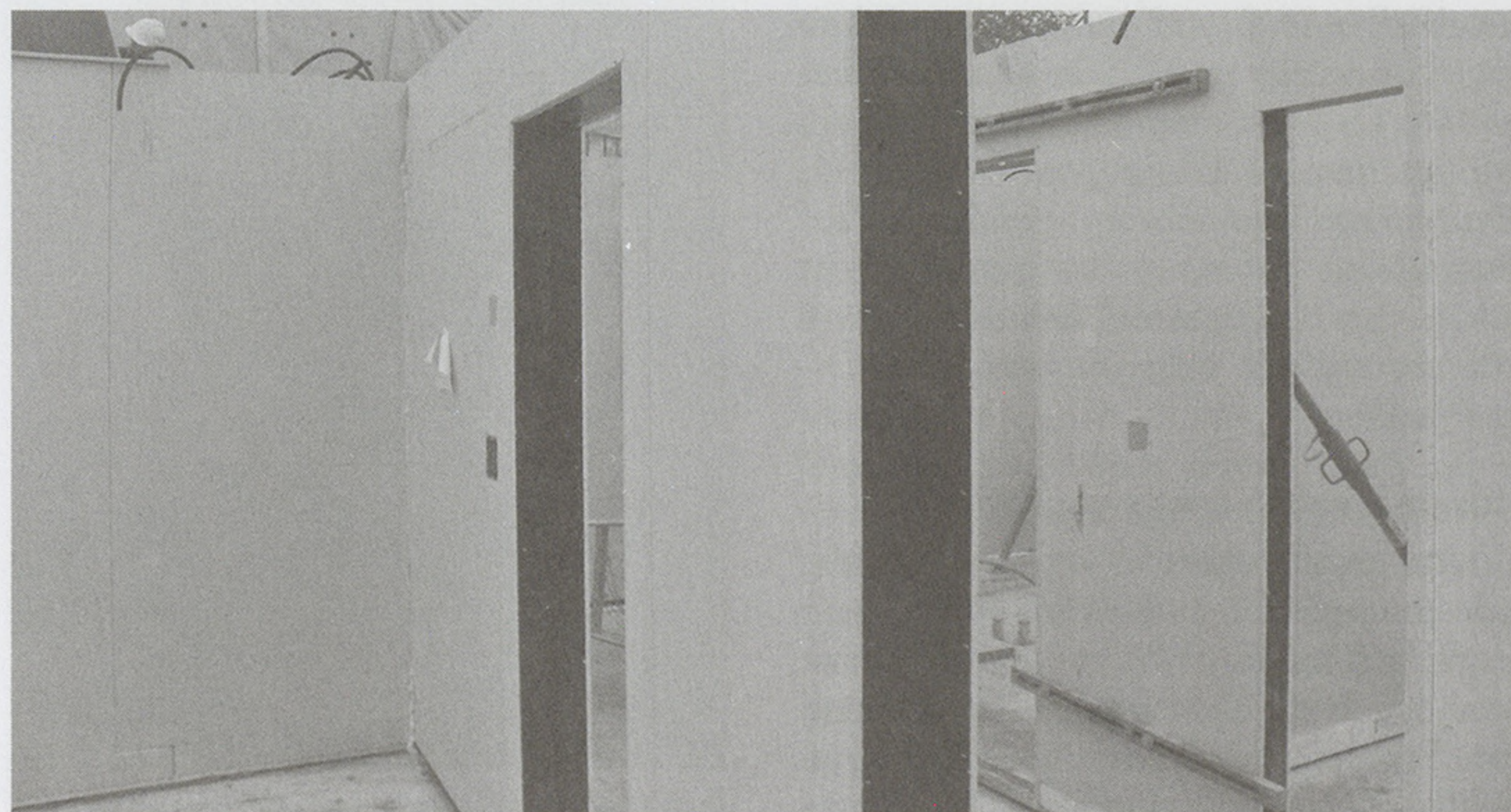
Die vorgefertigten Wandelemente sind fixiert.
