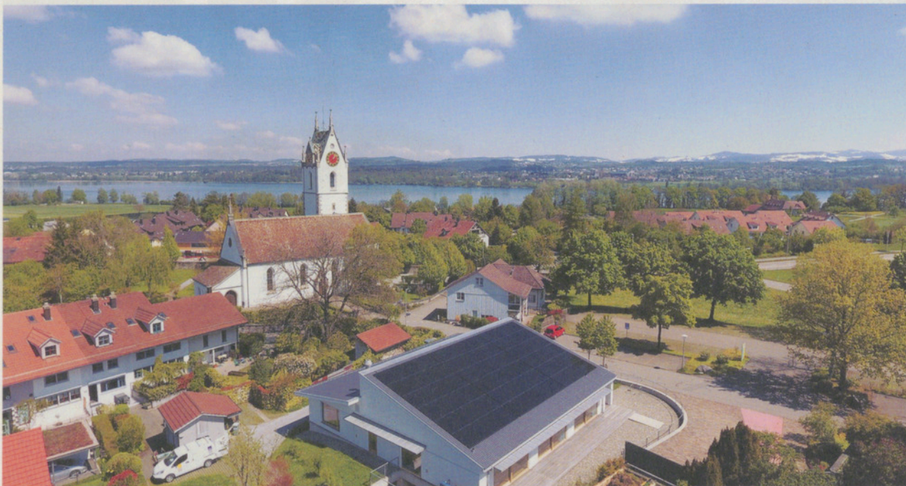
Blick auf das Kirchgemeindehaus Kreuzbühl in Maur: Das neu erstellte Solardach sammelt die Sonnenenergie.
