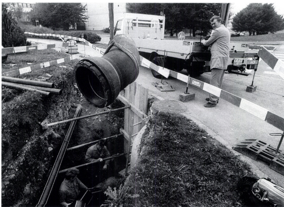
Bau einer neuen Wasserleitung: Betriebsleiter Josef Mair senkt sorgfältig ein Rohrstück in die Baugrube im Schörl. Wenn immer möglich führt die Wasserversorgung die Leitungsbauarbeiten mit eigenem Personal aus.
