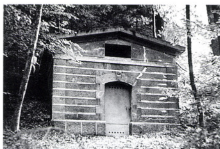
Das erste Reservoir der Genossenschaft Wasserversorgung 1894.
