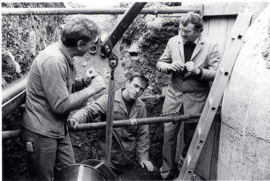
Teamarbeit beim Wasserleitungsbau: Brunnenmeister Werner Badstuber (links) mit Hansjörg Hafner und Josef Mair.
