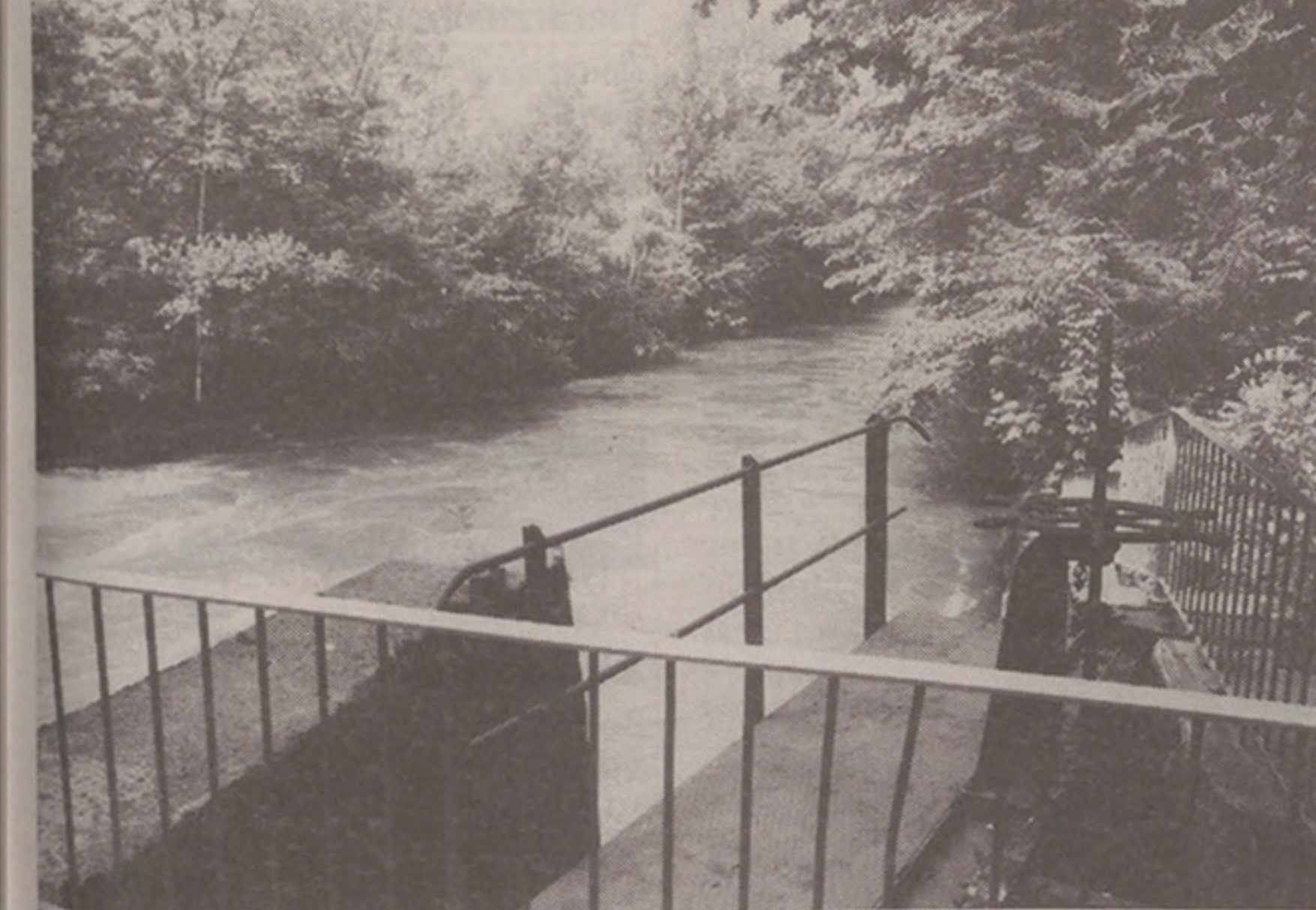
Die Restwassermenge ist ungefähr dreimal höher als vom Gesetzgeber vorgeschrieben. Dank einer Fischtreppe existiert ein artenreicher Fischbestand.
