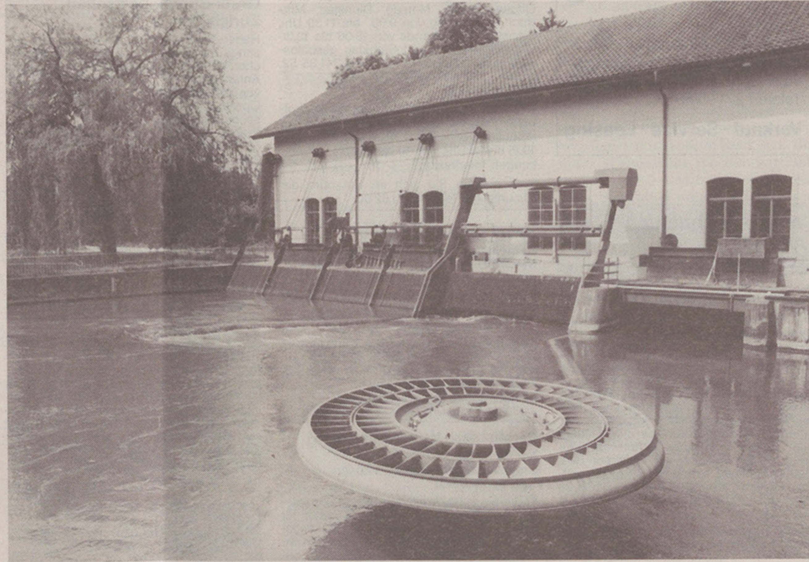
Das Wasserkraftwerk «Am Giessen» liefert Strom mit dem Gütesiegel naturemade star. Dazu sind strengste Umweltauflagen zu erfüllen. Das Hönegger Flusslaufwerk – im Vordergrund das Rad der stillgelegten Francis turbine – hat als eines der ersten die Kriterien erfüllt. (Fotos Louis Egli)
