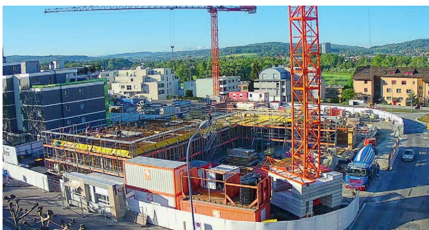
Die Baustelle Baufeld Ost im Zeitraffer ...
