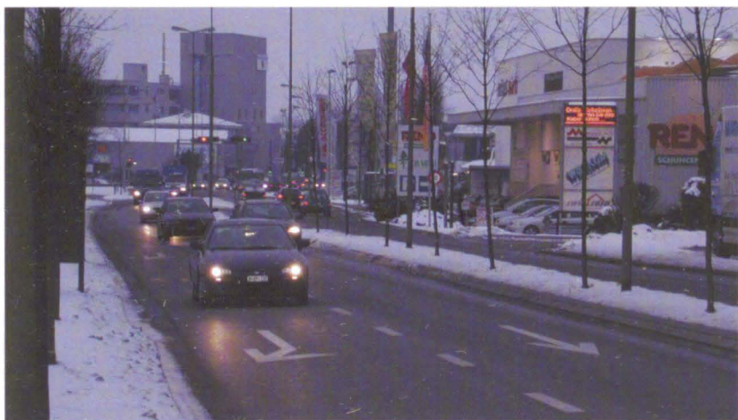
In Stosszeiten ist die Industriestrasse hoffnungslos überlastet. Die Umfahrung Greifenseestrasse verspricht Entlastung. (Bild: Judith Sacchi)
