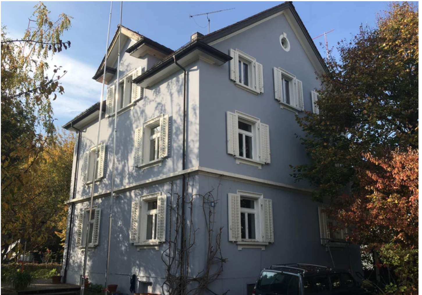
Ein schönes Haus soll weichen? Simmlersteig 16. Foto SB (29.10.2021).
