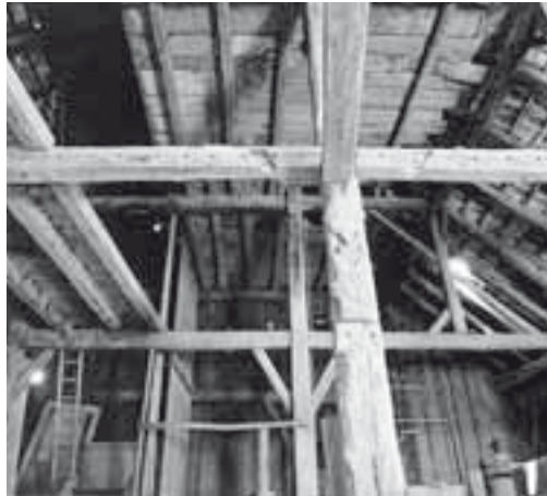
Heuraum. Links: Detail der Verstreben der Innenständerreihe. Rechts: Ständerkonstruktion mit teilweise entfernten Blatt-sassen. Zustand Juli 2000. KDP Fotoarchiv.
