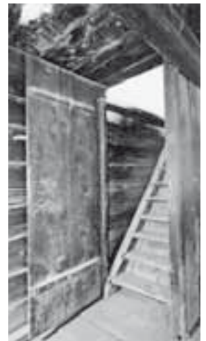
Gang 2.0.1 mit Aufgang ins 2. Dachgeschoss. Zustand vor dem Umbau, September 2006. KDP Fotoarchiv.
