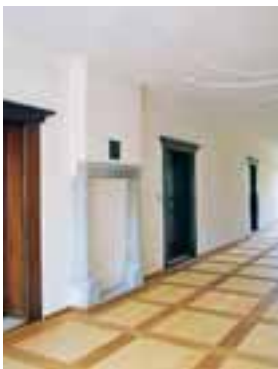
Gang 1.1 mit neuem Parkettboden und Wandverputz sowie restaurierter Stuckdecke. Zustand Mai 2007. KDP Fotoarchiv.
