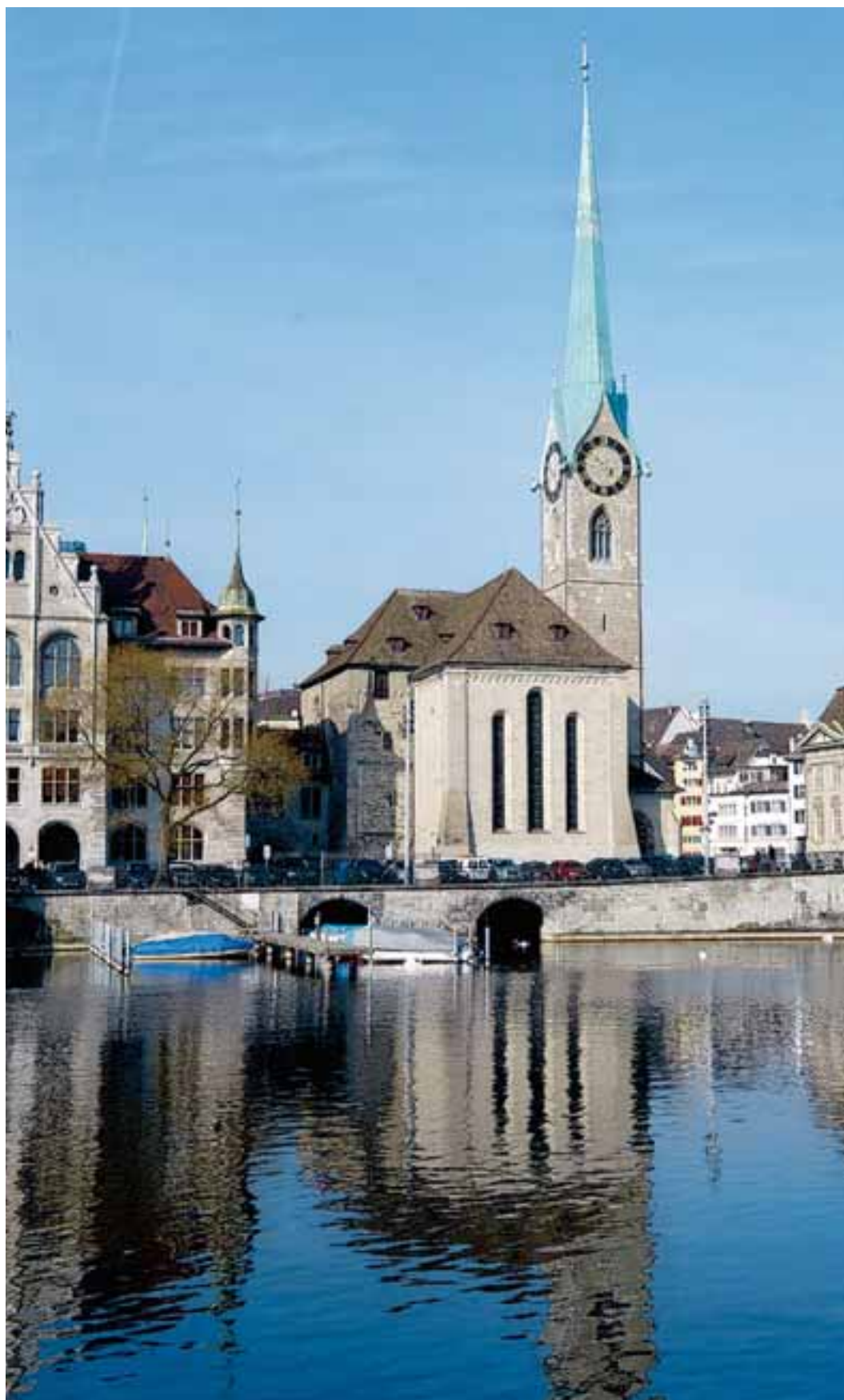
Gesamtansicht von Osten. Zustand nach der Restau- rierung, Februar 2012. KDP Fotoarchiv.
