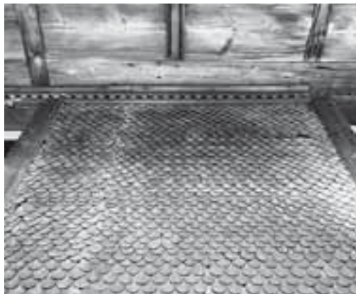
Links: Verschindelung an der Nordwestfassade des Wohnteils. Blick hinauf zur Dachuntersicht. Zustand vor der Erneuerung, April 2007. Rechts: Gang 1.0.1 mit intensiver Rauchschwärzung an den Bohlenwänden. Zustand vor dem Umbau, Oktober 2006. KDP Fotoarchiv.
