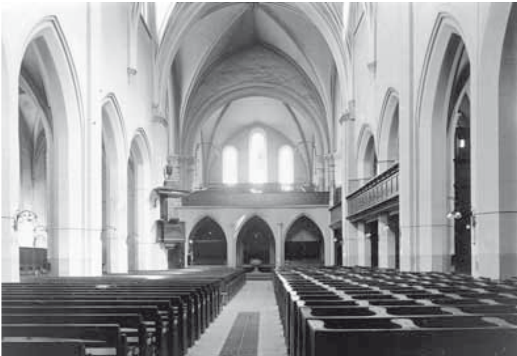
Inneres gegen den Chor. Zustand vor dem Umbau, April 1911. BAZ.
