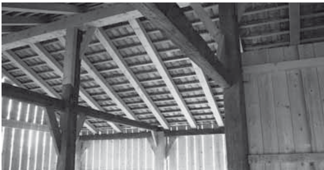
Teilansicht der reparierten bzw. ersetzten Ständer- und Dachkonstruktion. Zustand während der Restaurierung, Mai 2008. KDP Fotoarchiv.
