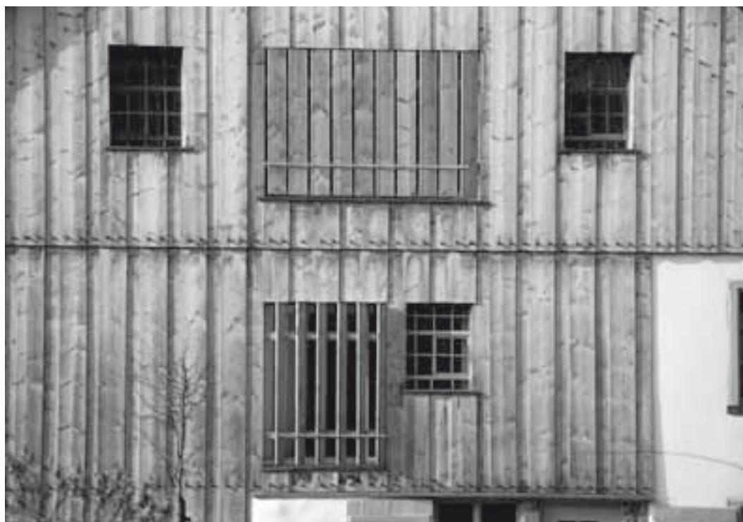
Ausschnitt der nordöstlichen Giebelfassade mit neuer Holzverschalung sowie alten und neuen Fensteröffnungen mit beweglichen Holzlamellen. Zustand März 2011. KDP Fotoarchiv.
