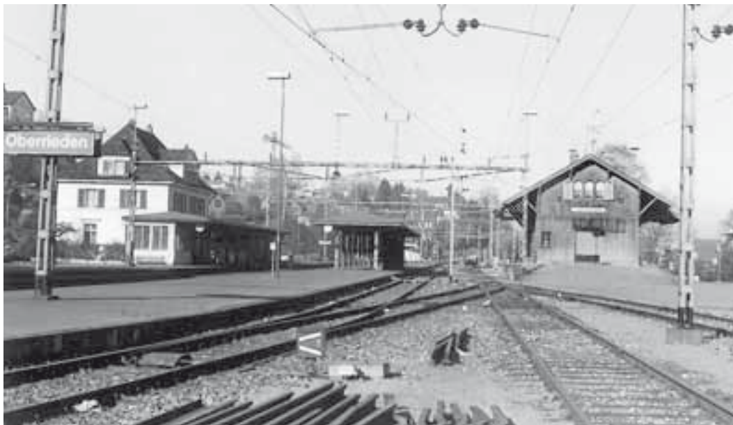
Bahnhofanlage Oberrieden-See von Südosten mit dem Aufnahmegebäude samt überdeckter Perronanlage von 1922–1923 und der Schuppenstation von 1874–1875. Zustand 2002. Privataufnahme, Repro KDP Fotoarchiv.
