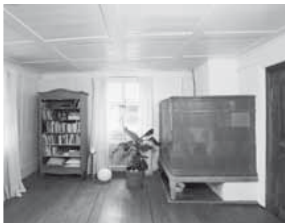
Stube 1.06. Links: Zustand vor der Restaurierung, November 2002. Rechts: Zustand nach der Restaurierung, Januar 2011. KDP Fotoarchiv.
