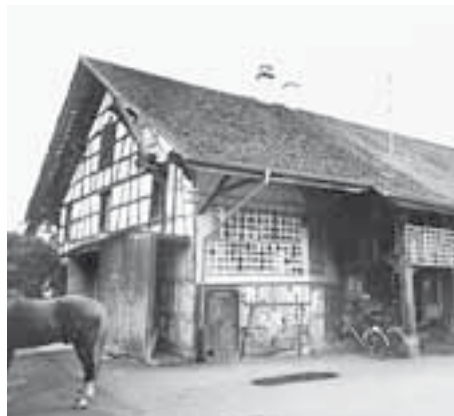
Links: Gesamtansicht von Südwesten. Zustand Mai 1963. Aufnahme Privatbesitz. Rechts: Gesamtansicht von Osten mit den beiden Brügi-Anbauten. Zustand August 1989. KDP Fotoarchiv.
