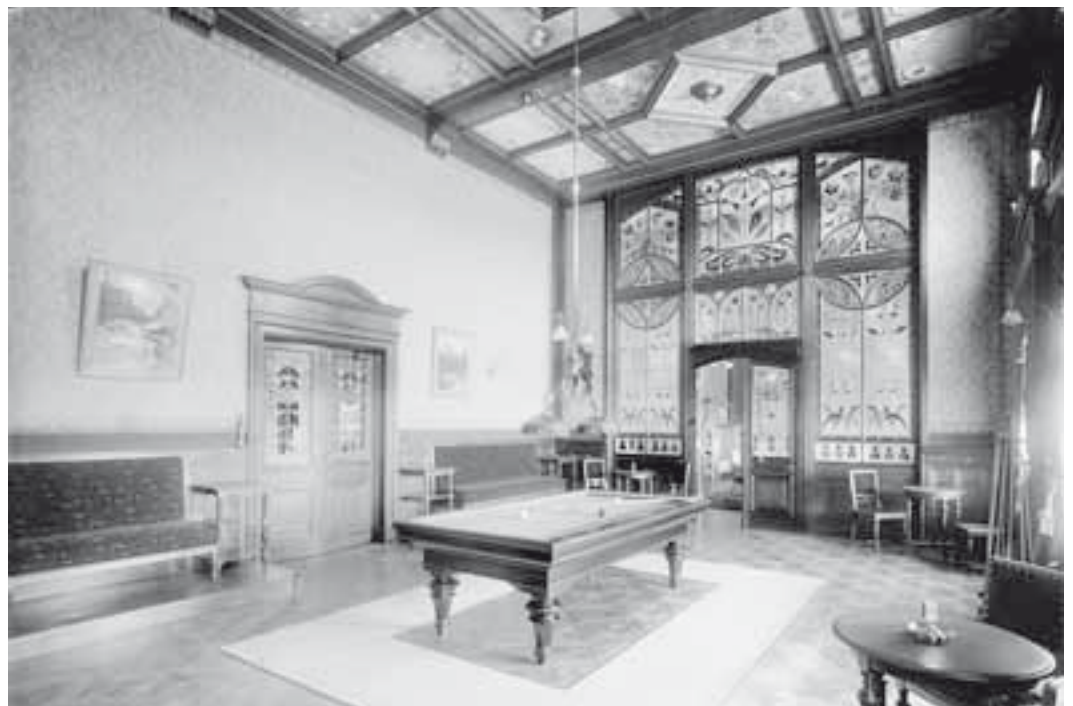
«Salon de Billard» im Westflügel mit der originalen Ausstattung aus der Bauzeit. Hinter der reichen Glasfront liegt der «Salon de Lecture». Zustand 1907. Aufnahme von Adolf Moser. BAZ.
