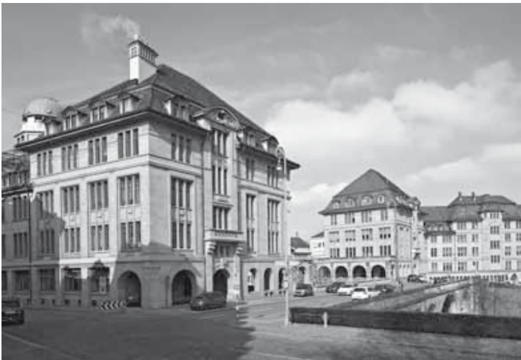
Amtshäuser IV und III von Südosten mit verbindender Lindenhofbrücke. Zustand Februar 2012. KDP Fotoarchiv.
