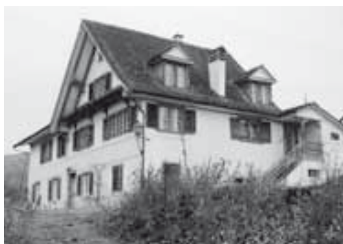
Links: Winterthur, Villa Schoellhorn Vers. Nr. 1358, Inneres Lind, Lindstrasse 27. Vor dem Abbruch, Aufnahme 2000.
