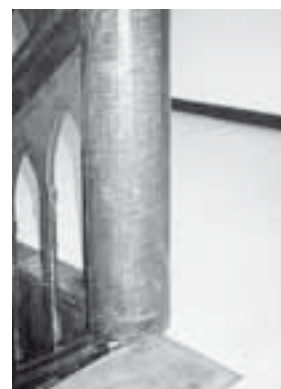
Treppenaufgang und Korridorboden im 1. Obergeschoss. Zustand nach der Renovation 1998–1999. Dok. 9.
