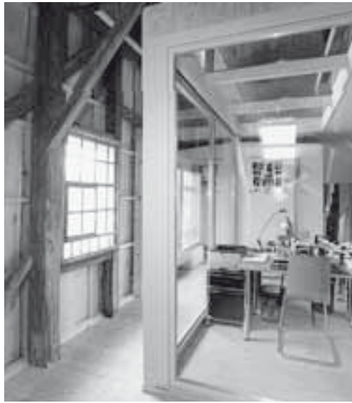
Innenansichten nach der Renovation. Links: Durchgehender Korridor im Erdgeschoss. Rechts: Verglaste «Haus-in-Haus-Konstruktion» zur Gewinnung von Wohn- und Arbeitsraum im Dachgeschoss. Zustand März 2010. KDP Fotoarchiv.
