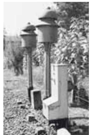
Lütwerk der Bahnhofanlage. Zustand September 2006. KDP Fotoarchiv.
