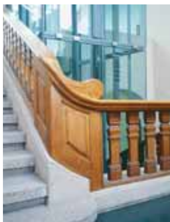
Amtshaus IV. Links: 3. Obergeschoss, Treppenhaus West mit Lifteinbau, Ausschnitt der Brüstung. Rechts: 1. Obergeschoss, Treppenhaus West. Zu-stand nach der Renova-tion, April 2004. KDP Fotoarchiv.
