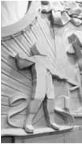
Gebäudeteil Nr. 69. Süd- fassade. Ausschnitt des Modells aus Ytong für die wiedergebrachte «Trülle» am Blendgiebel. Zustand, Februar 2007. KDP Fotoarchiv.
