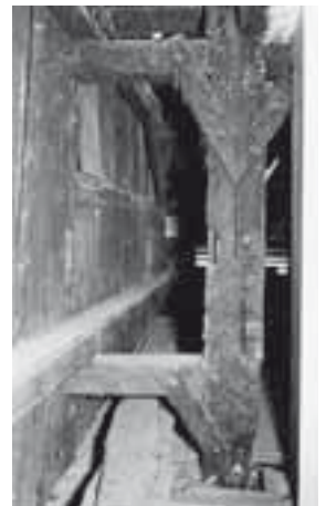
Ständer im Dachraum des Wohnteils Vers. Nr. 74 mit angeblatteten Verstrebungen. Zustand Oktober 2001. KDP Fotoarchiv.
