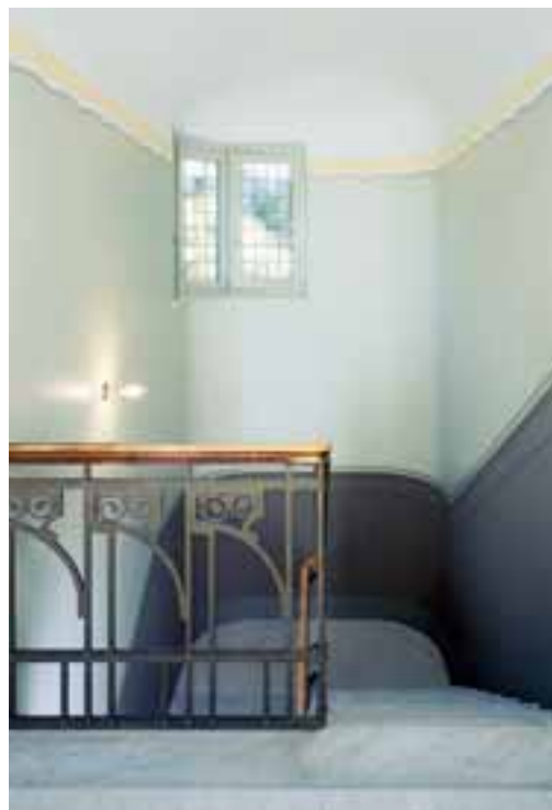
Links: Badezimmer 1.11 mit originaler Einrichtung. Rechts: Treppenhausabschluss 2.12. Zustand nach der Restaurierung, April 2007. KDP Fotoarchiv.
