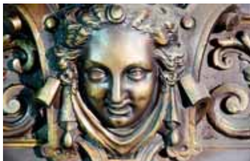
Links: Ausschnitt der Supraporte der ostseitigen Verbindungstüre mit Putti vor goldfarbenem Hintergrund. Zustand nach der Restaurierung, Dezember 2008. Rechts: Bronzierter Kopf über dem rechten Spiegel an der Nordwand. Zustand während der Restaurierung, September 2008. Dok. 5, S. 33, 37.
