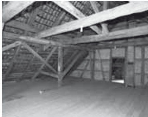
Links: Obergeschoss der ehem. Mühle. Zustand nach dem Ausbau, Januar 2011. Rechts: Dachgeschoss des Wohnhauses. Zustand nach der Restaurierung, Januar 2011. KDP Fotoarchiv.
