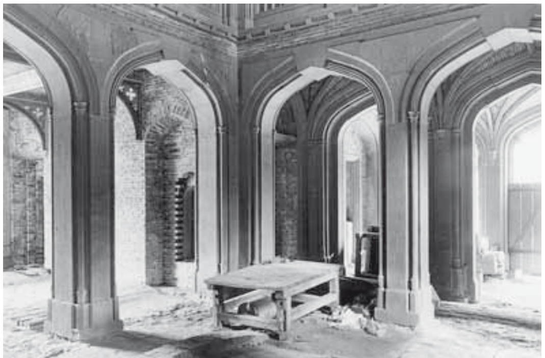
Teilansicht der über 120 Jahre unvollendet gebliebenen zentralen Halle, die über zwei Ge- schosse reicht. Zustand Juli 1970. KDP Fotoarchiv.
