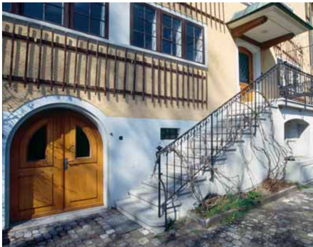
Teilansicht der Südfassade mit Kellerportal und Treppenaufgang. Zustand vor der Renovation, März 2008. KDP Fotoarchiv.
