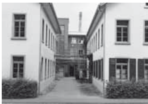
Bubikon, Ehem. mechanische Papierhülsen- und Spulenfabrik Vers. Nr. 1131, Sennweid, Sennweidstrasse 1. Links und rechts: Nach der Aussenrenovation, Aufnahmen 2010.
