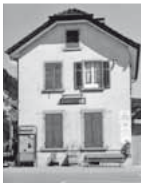
Südwestfassade. Zustand vor der Restaurierung, September 2006. KDP Fotoarchiv.
