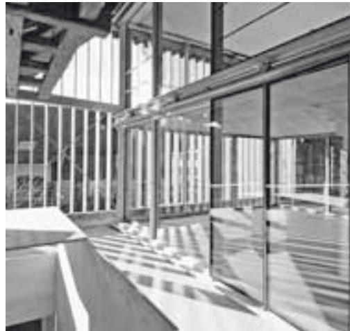
Inneres des zu Wohnzwecken umgenutzten Ökonomieteils mit weitgehend verglaster «Haus-in-Haus-Konstruktion». Die südseitige Glasfront mit beweglichen Holzlamellen ermöglicht den Blick nach draussen. Zustand Dezember 2005. KDP Fotoarchiv.
