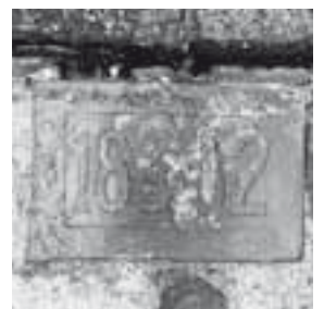
Sandsteinplatte am Treppensockel mit Baujahr «1802» und Initiale «ST». Zustand November 1988. KDP Fotoarchiv.
