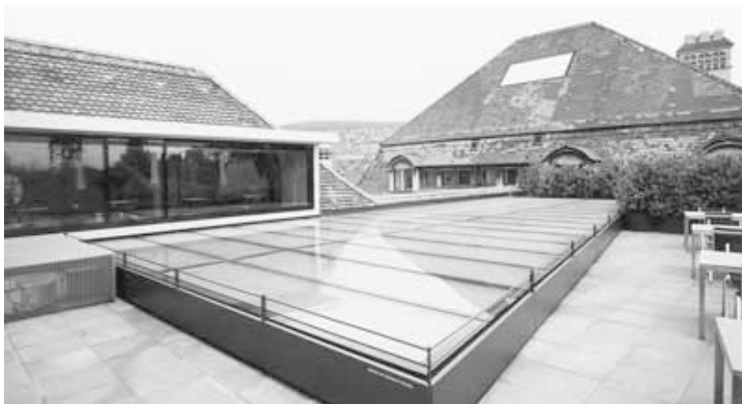
Amtshaus IV. Terrasse mit Glasoblicht; links die Glasfront der neu erstellten Cafeteria; im Hintergrund das neue Dachflächenfenster zur Belichtung des Medienraumes im Dachgeschoss. Zustand nach der Renovation, April 2004. KDP Fotoarchiv.
