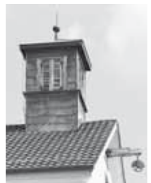
Glockentürmchen von 1916 über dem Querflügel des Spinnereihauptbaus. Zustand September 2011. Aufnahme Kulturdetektive, KDP Fotoarchiv.
