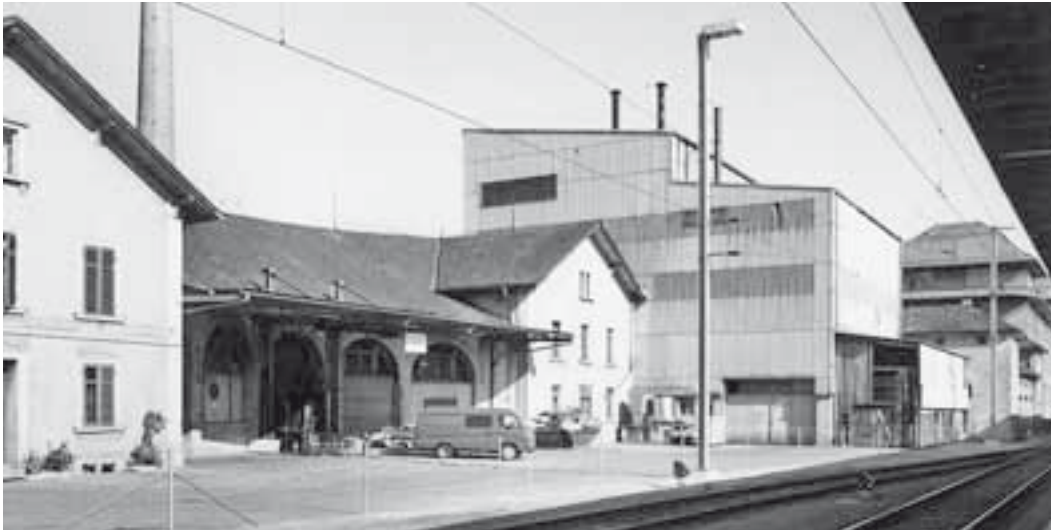
Das Ensemble mit dem Provisorium der Milchpulverfabrik, das sich als dominanter Fremdkörper zwischen die beiden Remisen drängt. Zustand 1980er Jahre. KDP Fotoarchiv.
