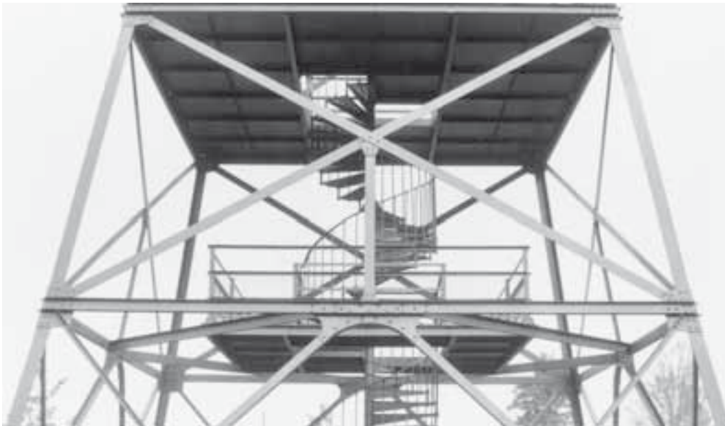
Aussichtsturm auf der Pfannenstil Hochwacht. Ausschnitt der Stahlfachwerkkonstruktion mit der Wendeltreppe. Zustand Mai 1996. KDP Fotoarchiv.
