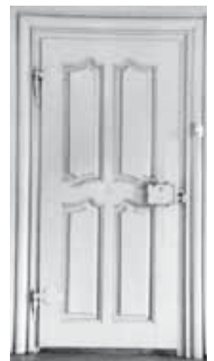
Spätbarocke Türe in der Stube 0.7. Zustand vor Ausführung der Brandschutzmassnahmen, Juni 2005. KDP Fotoarchiv.
