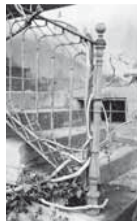
Treppenaufgang in Sandstein mit schmiedeeisernem Brüstungsgeländer an der Südwestfassade. Zustand vor der Renovation, April 1992. KDP Fotoarchiv.
