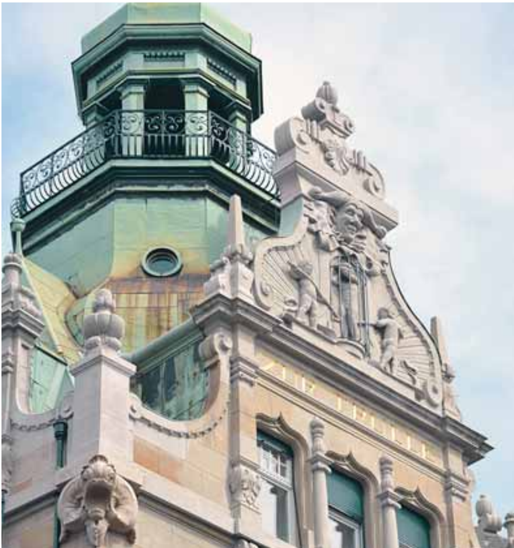
Gebäudeteil Nr. 69. Ausschnitt der Südfassade mit dem in Kunststoff rekonstruierten Giebel- relief und dem kupferblech- verkleideten Turmaufsatz. Zustand nach der Fassaden- restaurierung, April 2009. KDP Fotoarchiv.
