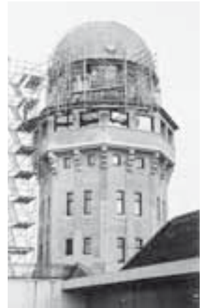
Turmaufbau während der Gerüstarbeiten für die Reparaturarbeiten an der Kupferblechverkleidung. Zustand August 2006. KDP Fotoarchiv.
