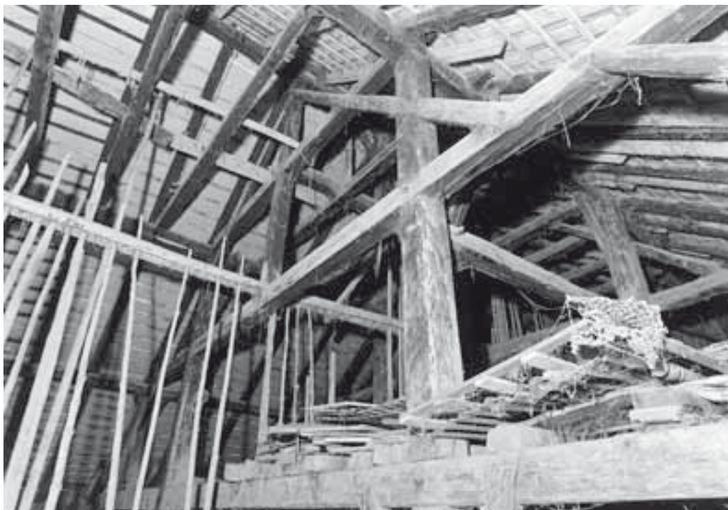
Ökonomieteil (Garben- und Heuraum) mit rauchgeschwärzter Dachkonstruktion. Zustand Oktober 2001. KDP Fotoarchiv.
