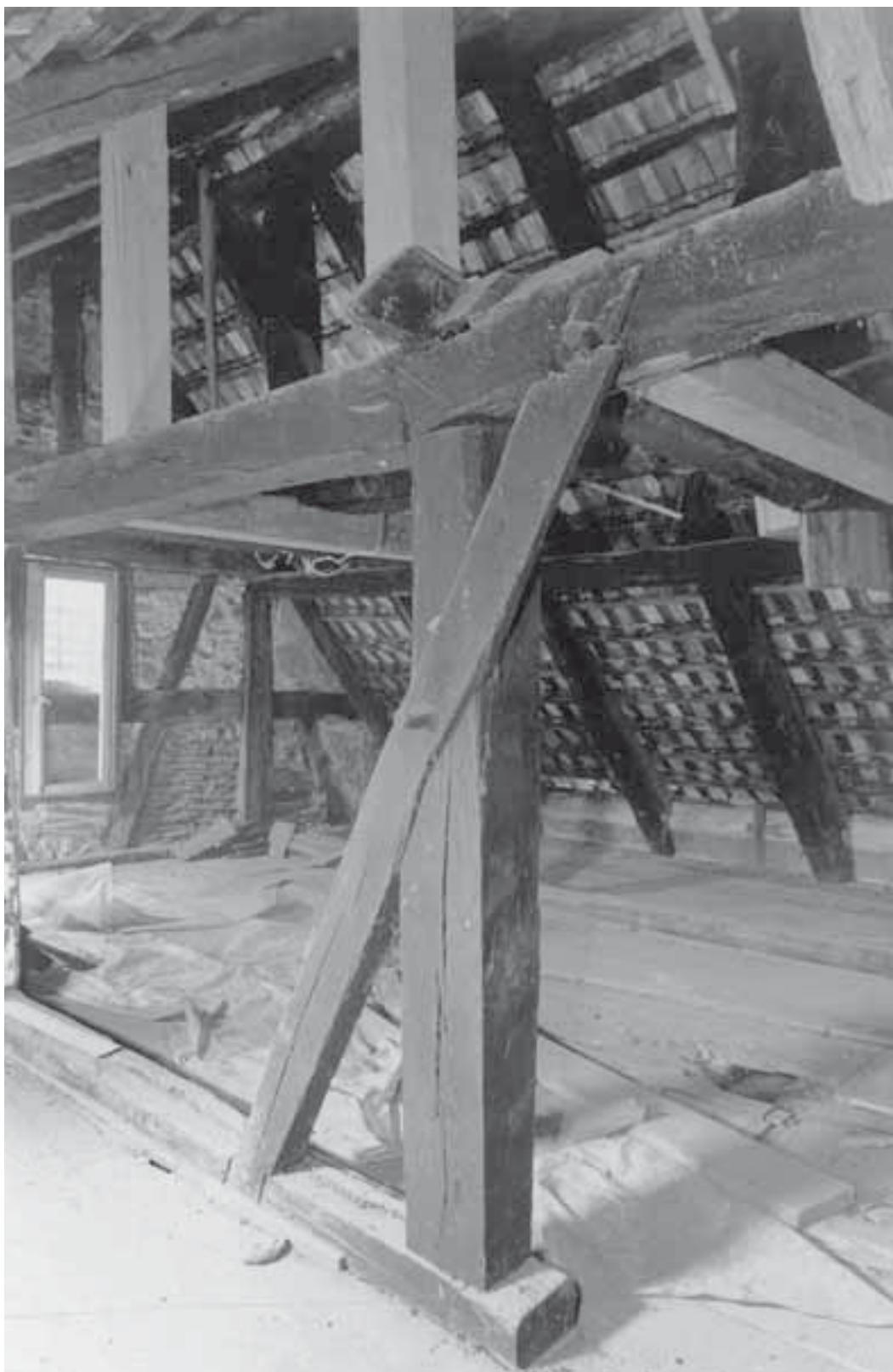
Marthalen, ehem. Bauernhaus Vers. Nr. 32, Oberdorf 17. Stuhlsäule der Dachkonstruktion im Dachraum 2.1, 1463d. Zustand vor der Restaurierung, August 2004. Aufnahme von Karl Fölscher, Unterstammheim. KDP Fotoarchiv.
