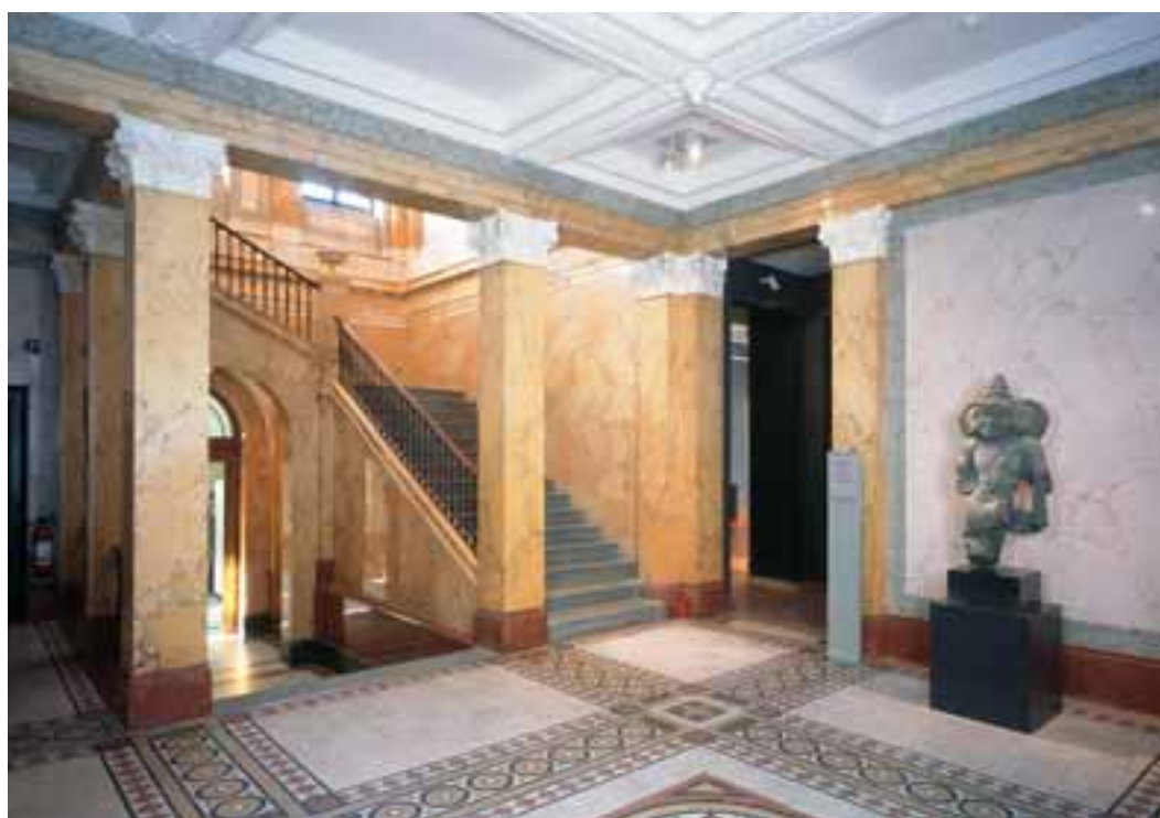
Erdgeschoss, Halle mit Treppenaufgang ins 1. Obergeschoss. Wände und Pfeiler mit ockerfarbener Marmorinkrustationsmalerei. Zustand nach der Renovation, Dezember 2006. KDP Fotoarchiv.
