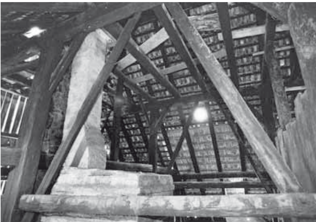
Dachraum mit rauchgeschwärzter Dachkonstruktion und Räucher-kammer über dem Wohn- teil. Zu- stand Juli 2000. KDP Fotoarchiv.
