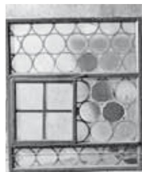
Altes bleigefasstes Fenster mit Schiebeteil im Dachraum. Zustand September 2006. KDP Fotoarchiv.
