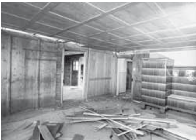
Links: Stube 0.2.2. Zustand während der Ausräumarbeiten, September 2006. Rechts: Kammer 1.2.2. Zustand nach den Ausräumarbeiten, Oktober 2006. KDP Fotoarchiv.
