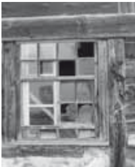
Fenster am westlichen Pultdachanbau in Bohlenständerbauweise (1707d). Zustand Oktober 2001. KDP Fotoarchiv.
