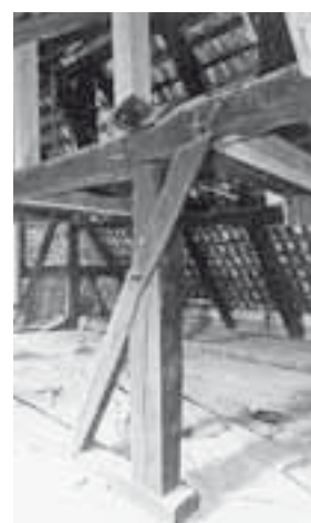
Dachraum 2.1. Stuhlsäule der Dachkonstruktion, 1463d. Zustand vor der Restaurierung, August 2004. KDP Fotoarchiv.
