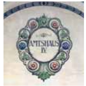
Amtshaus IV. 1. Obergeschoss, Korridor beim südlichen Eingang, Lünettenmalerei mit Gebäudebezeichnung aus der Bauzeit. Zustand vor der Restaurierung, August 2000. KDP Fotoarchiv.
