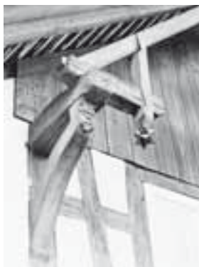
Flugsparrendreieck an der Südostfassade. Zustand März 2001. KDP Fotoarchiv.
