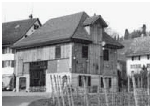
Links: Stäfa, Wohnhaus, ehem. Gerbereiegebäude Vers. Nr. 40, Uerikon, Gerbi 14. Nach der Wiederherstellung der Bleiverglasung der Veranda, Aufnahme 2010.
