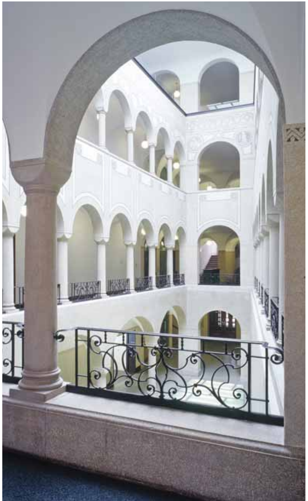
Amtshaus IV. Lichthof mit Umgang. Zustand nach der Restaurierung, April 2004. KDP Fotoarchiv.
