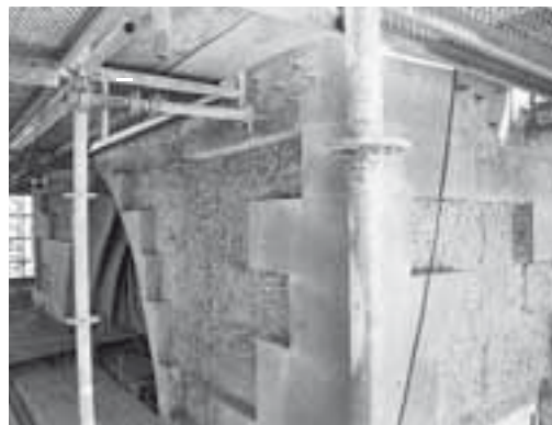
Links: Ostfassade des Nordturms mit Spuren eines aufgemalten Zifferblatts. Zustand März 2004. Rechts: Südwestecke des Nordturms auf der Höhe der Schallöffnungen. Zustand nach der Zurückarbeitung von schadhafte Quadern, März 2004. KDP Fotoarchiv.
