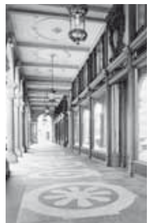
Durchgehende Arkadenhalle entlang der Börsenstrasse. Zustand Mai 1999. KDP Fotoarchiv.
