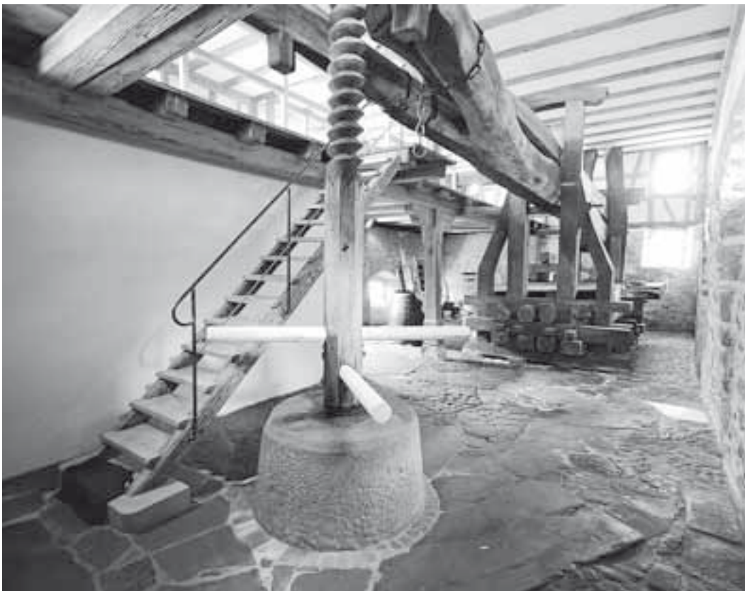
Baumtrotte im Erdgeschoss, neuer Treppenaufgang zur Galerie. Zustand nach der Renovation, November 2010. KDP Fotoarchiv.
