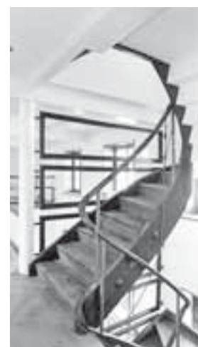
Treppenhaus und Galerie im 1. Obergeschoss mit Glaspaneelen in den bestehenden Nussbaumholzrahmen. Zustand nach der Renovation, Juni 2007. KDP Fotoarchiv.
