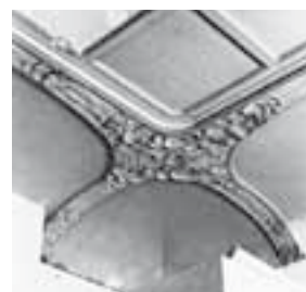
Ehem. Herrenzimmer 0.6. Ausschnitt der originalen Stuckdecke nach dem Entfernen der eingezogenen Decke. Zustand November 2005. KDP Fotoarchiv.
