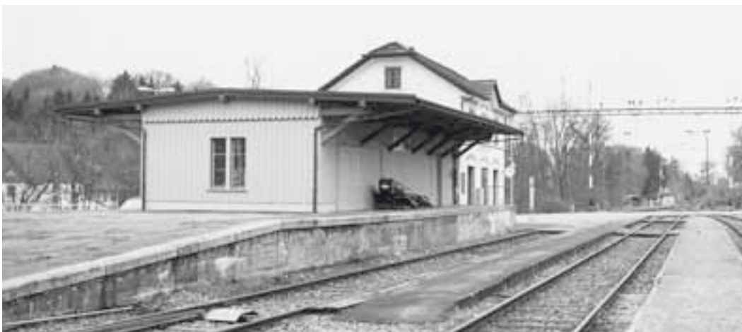
Gesamtansicht von Norden mit Gleisanlage. Zustand nach der Restaurierung, November 2008. KDP Fotoarchiv.
