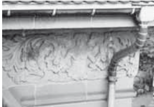
Amtshaus IV. Links: Nordfassade, Türsturz mit Gebäudebezeichnung, skulptiertem Fruchtgehänge und Putti. Rechts: Südfassade. Skulptierter Abschlussfries. Zustand vor der Renovation, August 2000. KDP Fotoarchiv.
