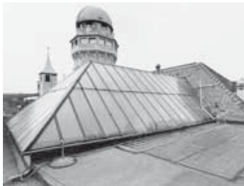
Amtshaus IV. Links: Glasdach über dem Oblicht des Lichthofes; im Hintergrund der Turm der Sternwarte. Rechts: Glasdachkonstruktion und Oblicht über dem Lichthof. Zustand vor der Entfernung, August 2000. KDP Fotoarchiv.
