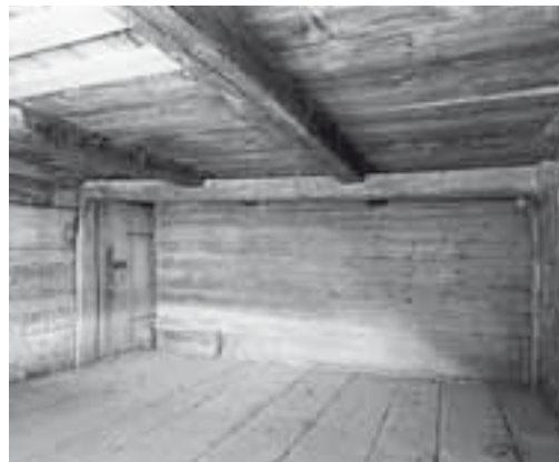
Links: Kammer 0.3.4. Zustand vor dem Umbau, April 2007. Rechts: Kammer 1.3.4. Zustand vor dem Umbau, Oktober 2006. KDP Fotoarchiv.
