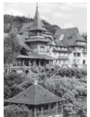
Waldhaus Dolder. Rechts im Bild der 1907 anstelle eines hölzernen Saales errichtete Hotelanbau. Zustand um 1920. Aufnahme von Heinrich Wolf-Bender (1871–1932), Zürich. BAZ.
