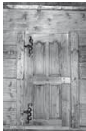
Schlafzimmer im 2. Obergeschoss. Gestemmte Türe mit barock geschweiften Bändern zum Korridor. Zustand nach der Renovation, Juni 2007. KDP Fotoarchiv.
