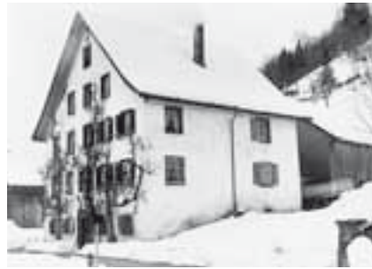
Links: Ansicht von Osten. Zustand während der Restaurierung, Mai 2007. Rechts: Das 1822 erbaute Sigristenhaus Vers. Nrn. 599/610 in Fischenthal, Zustand 1983. KDP Fotoarchiv.
