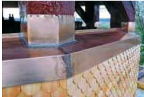
Links: Schindelmacher an der Arbeit am Turmschaft während der Renovation, November 2008. Rechts: Kupferblechabdeckung am Turm mit neuen Schindeln. Unten: Neue Ziegeleindeckung auf der nördlichen Dachfläche sowie Turm von Nordwesten. Zustand nach der Renovation, Dezember 2008. KDP Fotoarchiv.
