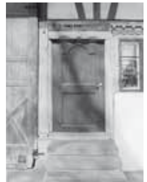
Eingangspartie an der südöstlichen Traufseite. Zustand Mai 1976. KDP Fotoarchiv.
