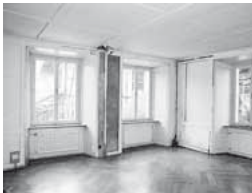
Östlicher Eckraum im Erdgeschoss, Bibliothek, ehem. Praxis und Wartezimmer. Links: Zustand vor der Renovation 2006–2007. Rechts: Stuckierungsarbeiten an der Decke 2007. Dok. 9.
