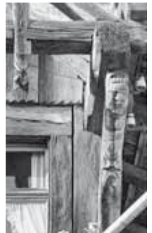
Flugsparrendreieck an der Südostfassade. Zustand 1966. KDP Fotoarchiv.
