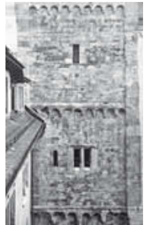
Ausschnitt aus der Südfassade des Südturms. Zustand 1987. KDP Fotoarchiv.
