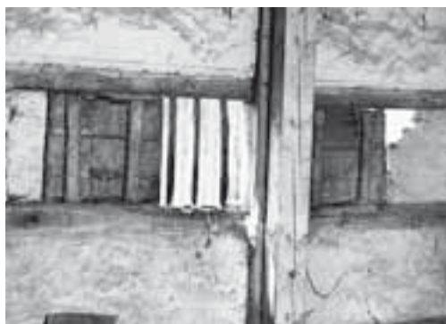
Links: Detail einer Fachwerkausfachung mit Begleitlinie. Rechts: Originale Öffnungen mit Holzstaketten und Brettladen an der Südwand. Zustand Mai 1986. KDP Fotoarchiv.
