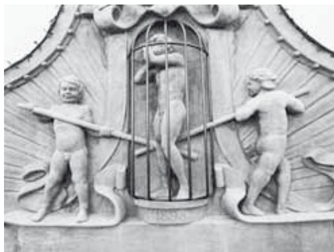
Gebäudeteil Nr. 69. Süd- fassade. Links: Rekonstru- iertes Giebelrelief «Trülle» mit Delinquent und den beiden Folterknechten. Zustand nach der Montage, November 2007. Rechts: Westfassade. Blendgiebel. Zustand nach der Rekonstruktion in Sandstein, November 2011. KDP Fotoarchiv.
