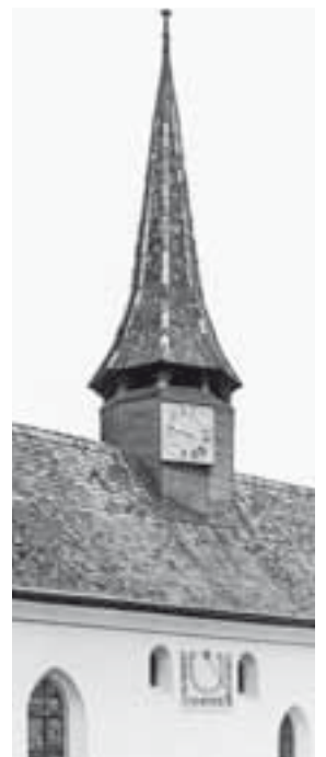
Turmansicht von Südwesten. Zustand vor Entfernung der defekten Eterniteindeckung am Turmhelm, September 2008. KDP Fotoarchiv.
