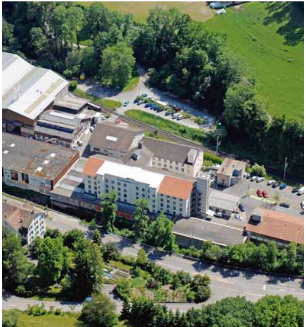
Luftaufnahme des Gebäudekomplexes von Norden. Zustand nach den Renovationsarbeiten, Juni 2009. KAZ Fotoarchiv.
