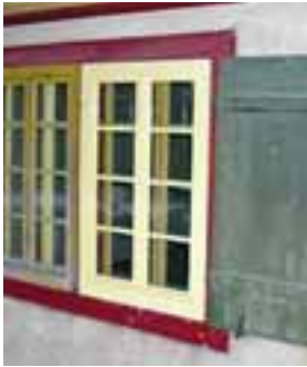
Restauriertes Vorfenster (Muster) am Obergeschoss der Nordostfassade. Zustand September 2006. KDP Fotoarchiv.
