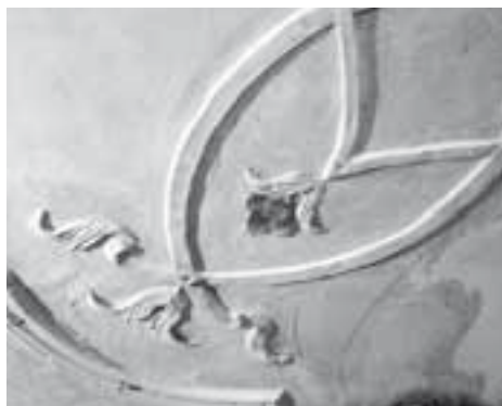
Links: Gang 1.1. Teilansicht der Südwestwand nach Entfernung des spätbarocken Wandverputzes. In der linken Bildhälfte die Tür zur Küche 1.6, unmittelbar links davon die Nahtstelle zwischen Kernbau und Altbau. Zustand April 2006. Rechts: Detail der Stuckdecke im Raum 1.5. Zustand während der Restaurierung, Dezember 2006. KDP Fotoarchiv.
