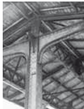
Ausschnitt des genieteten Eisenprofiltragwerks mit Gitterlängsträger bei einem der Mittelperrondächer. Zustand vor dem Abbruch, Februar 2008. KDP Fotoarchiv.
