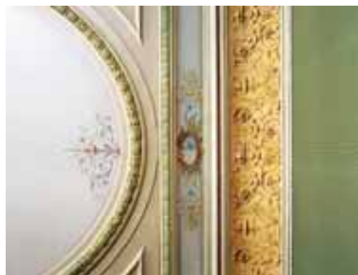
Gebäudeflügel Börsenstrasse, 2. Obergeschoss. Links: Ausschnitt der farbig gefassten Kassetten- decke im Raum 123. Rechts: Ausschnitt der farbig gefassten Stuckdecke im Raum 117. Zustand nach der Restaurierung, Juli 2007. KDP Fotoarchiv.
