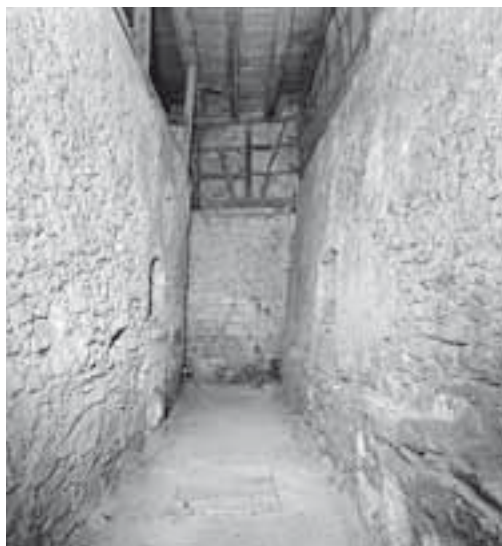
Radhaus 0.02. Links: Zustand vor der Renovation, November 2002. Rechts: Zustand nach dem Einbau der Treppe, Januar 2011. KDP Fotoarchiv.
