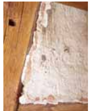
Ausschnitt aus der Südwestfassade im Bereich des später angebauten Aborts: Spuren der ursprünglichen Rotfassung des Fachwerks. Zustand während der Restaurierung, März 2007. KDP Fotoarchiv.
