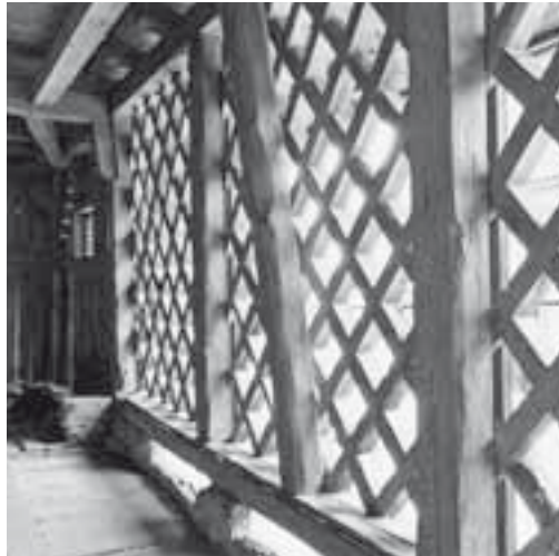
Links: Erdgeschoss des 1843 an die Scheune angebauten Trotthauses mit Transmissionen. Zustand vor der Restaurierung, Juni 2005. Rechts: Kantholzgitter an der südöstlichen Aussenwand der Scheune Vers. Nr. 836. Zustand vor der Restaurierung, Juni 2005. KDP Fotoarchiv.
