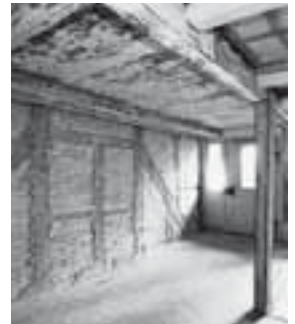
Gang 0.1.1a. Zustand September 2006, während des Umbaus. Der Raumteil links vom Pfosten gehört zur Bausubstanz von 1728–1729, derjenige rechts zur Erweiterung von 1740d. Die Wand gegen die Küche (links) wurde 1897 eingefügt. KDP Fotoarchiv.
