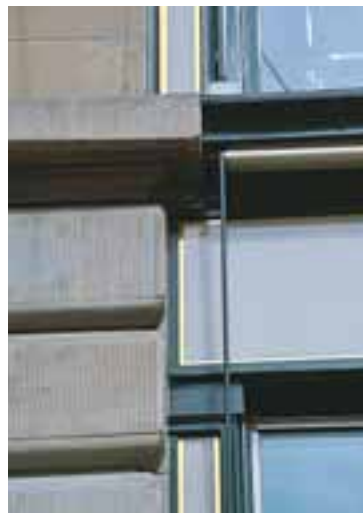
Links: Ostfassade. Durch- gang zur Seidengasse. Ausschnitt mit Erkerfuss und skulptiertem Schluss- stein mit Götterbote Merkur. Zustand nach der Restaurierung, Rechts: Südfassade. Ausschnitt mit goldfilettierten Ver- glasungen und Stören- vorrichtung. Zustand nach der Restaurierung, April 2009. KDP Fotoarchiv.
