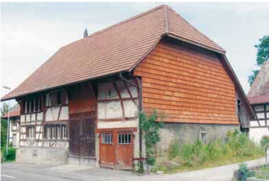
Gesamtansicht von Südwesten mit dem giebelseitigen Ziegelschild. Zustand vor der Umnutzung des Ökonomieteils, August 2004. KDP Fotoarchiv.
