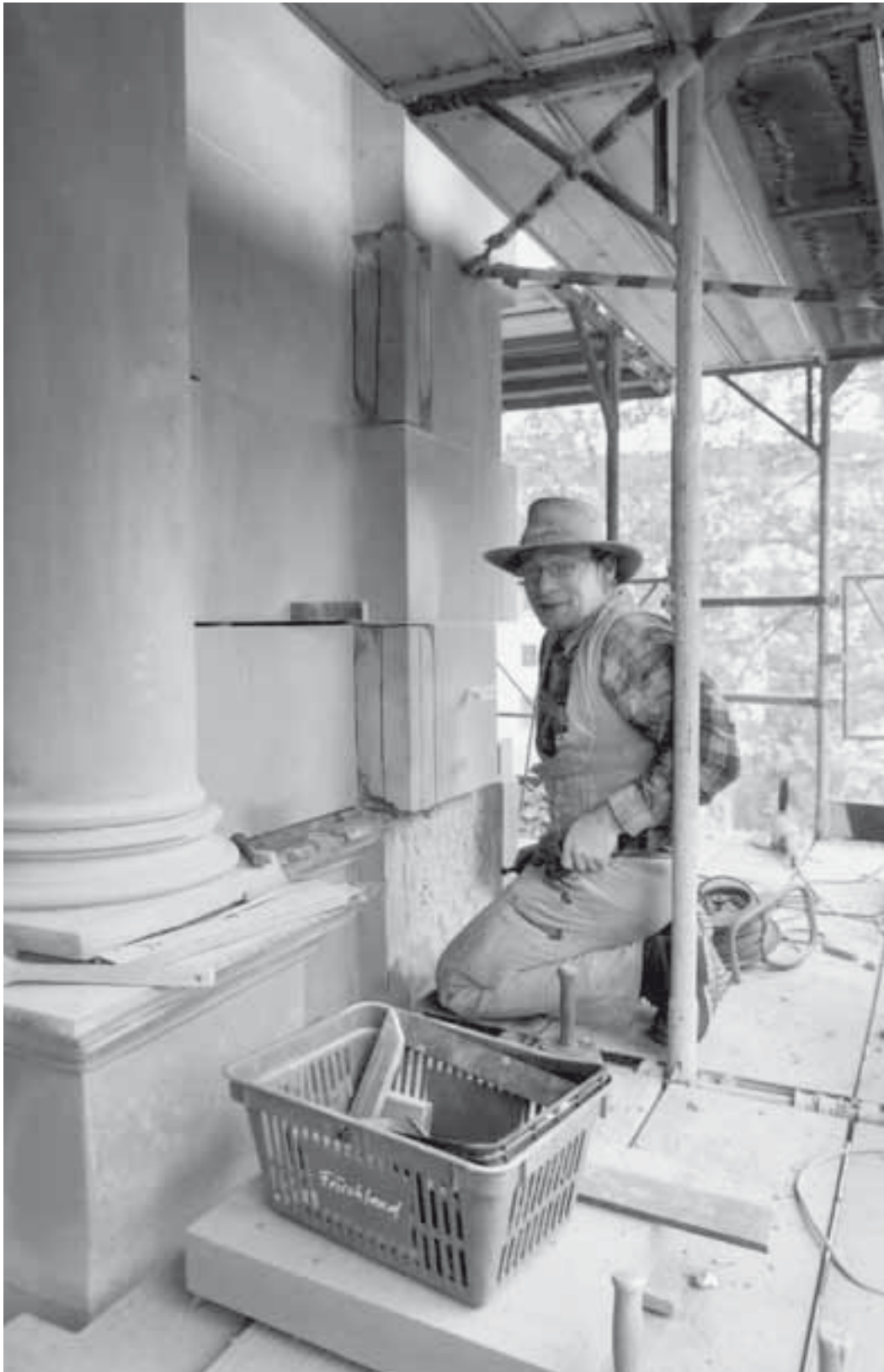
Winterthur, Stadthaus Vers. Nr. 602, Stadthaus- strasse 4 a. Ein Steinmetz aus Sachsen an der Arbeit. Aufnahme von Karl Fülscher, November 2004. KDP Fotoarchiv.
