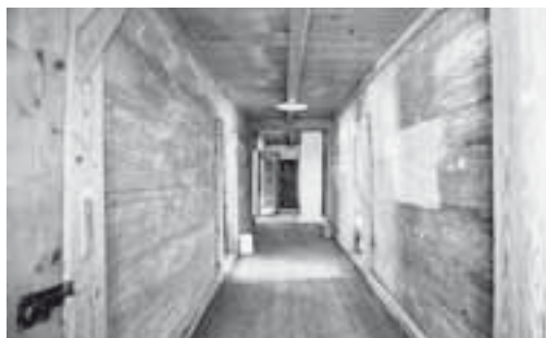
Links: Grosser Dachraum mit Cheminée. Rechts: Korridor mit Bohlenwänden im 2. Obergeschoss. Zustand nach der Renovation, Juni 2007. KDP Fotoarchiv.
