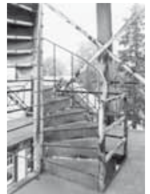
Wendeltreppe des Üetlibergturms. Zustand September 1983. KDP Fotoarchiv.
