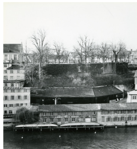
Ursprungsort der Stadtbesiedelung: der Lindenhof (Bild: BAZ_031455)
