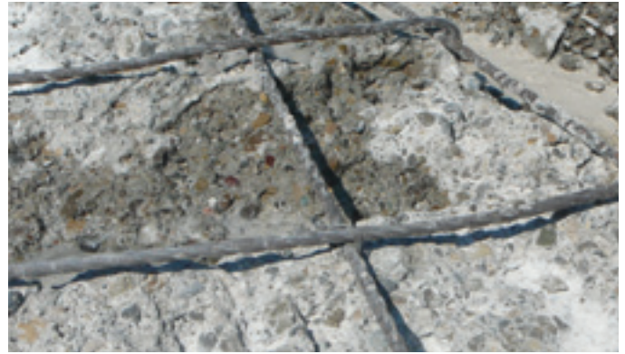
Mit Wasserhöchstdruck wird der marode Beton bis auf den gesunden Kern entfernt, ohne dass die Eisenbewehrung beschädigt wird
