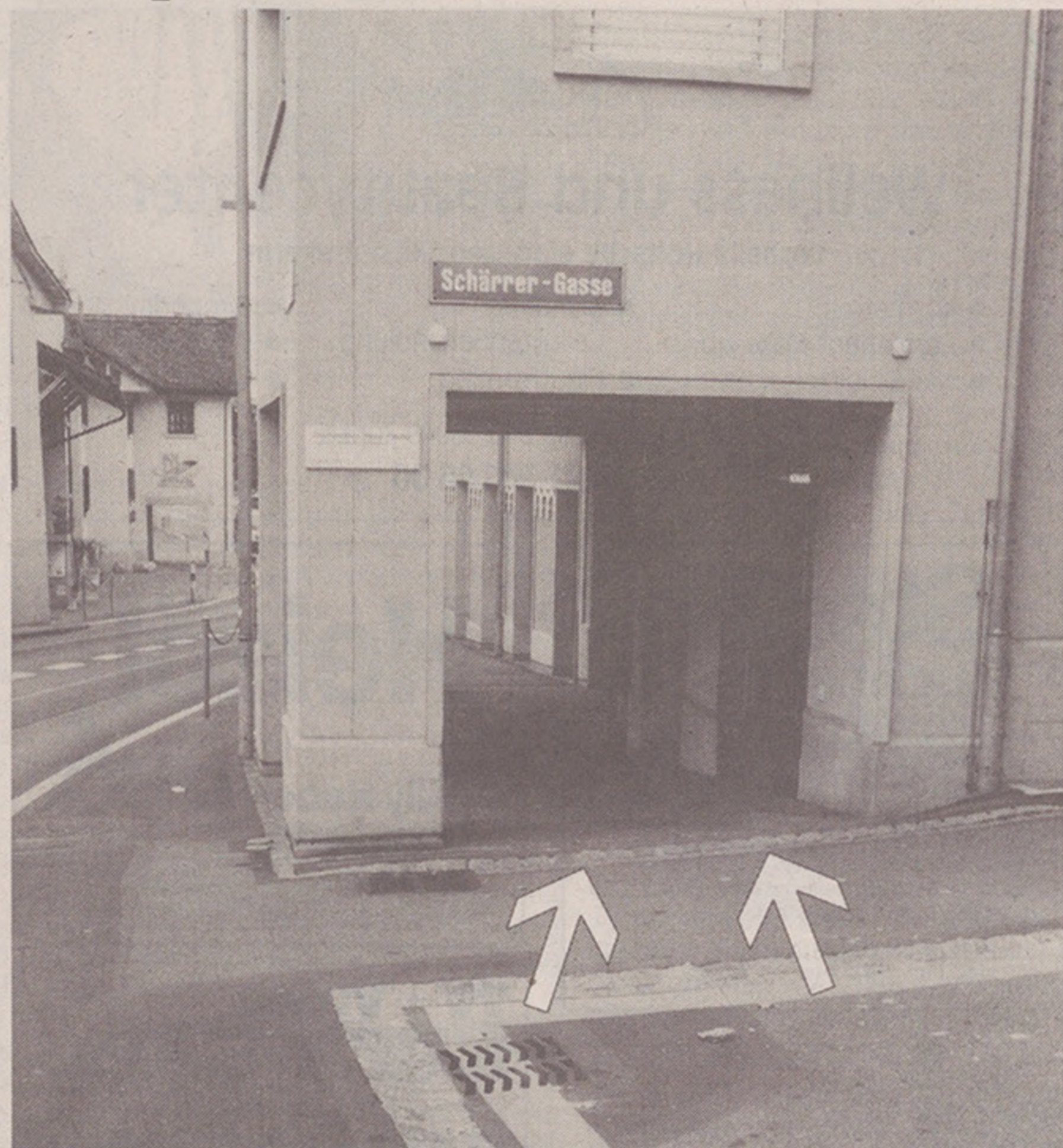
Das Bild zeigt die Wasserrinne bei der Einmündung der Scharrer-Gasse in die Limmattalstrasse – auf dem Foto mit Pfeilen markiert.
