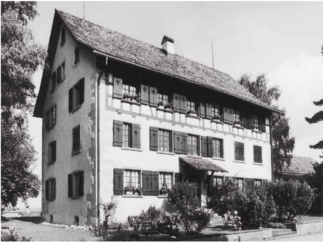
Im Zeichen der Schriftlichkeit: Die Land-schreiberei Kyburg wurde 1672 neu errichtet und Ende des 18. Jahrhunderts zur heutigen Form umgebaut. Hier lebte und wirkte jener Amtschreiber, der auch für die Belange von Illnau zuständig war. (Kantonale Denkmalpflege Zürich)
