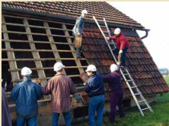
Mit vereinten Kräften werden auf der Rückseite der Ottiker «Hütteschüür» die alten Ziegel entfernt.
