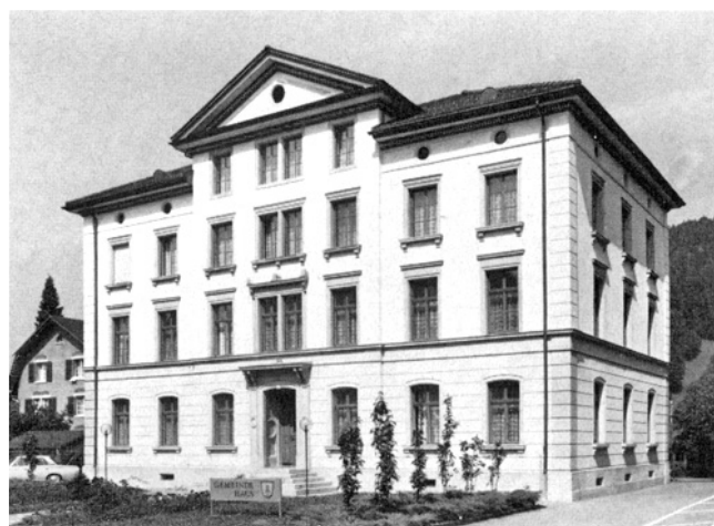
Bauma. Tössstalstrasse. Gemeindehaus (ehem. Primarschulhaus), Vers. Nr. 851. Nach der Restaurierung 1975.
