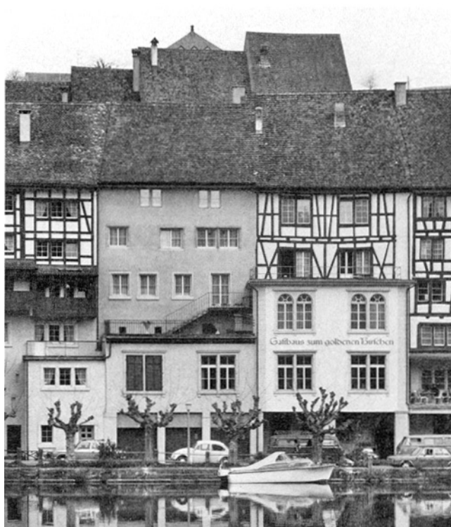
Eglisau, Untergass 26. Haus «Alter Hirschen» (Vers. Nr. 704). Oben: vor der Aussenrenovation; unten: nach der Aussenrenovation 1974–1976 (zu S. 52).
