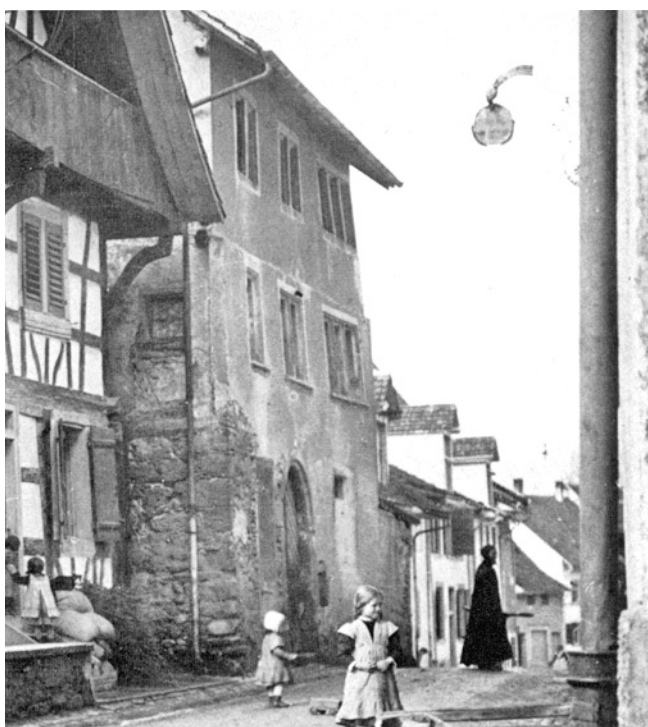
Eglisau. Obergass 46. Ehem. Weinbauernhaus Vers. Nr. 559. Zustand 1929.
