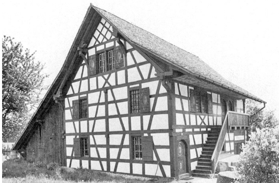
Oberweningen. Museumsspeicher (Vers. Nr. 112). Nach der Restaurierung 1974–77.
