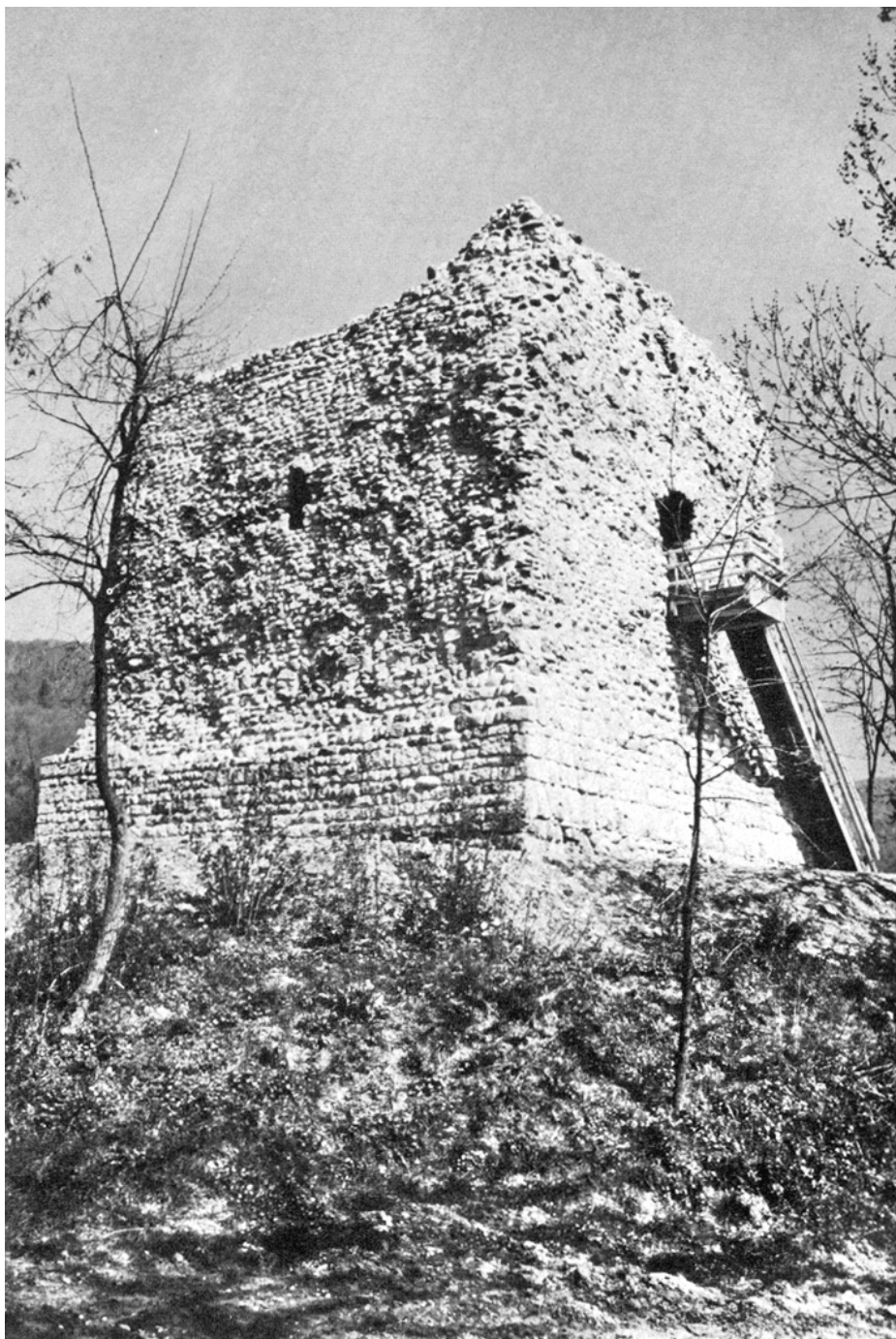
Freienstein-Teufen. Burgruine Freienstein. Nach der Konservierung 1975–1977.
