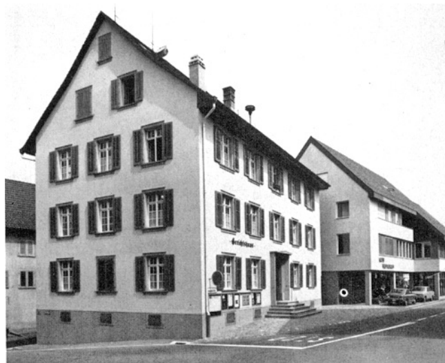
Andelfingen. Gerichtshaus. Nach der Aussenrenovation 1972/73.
