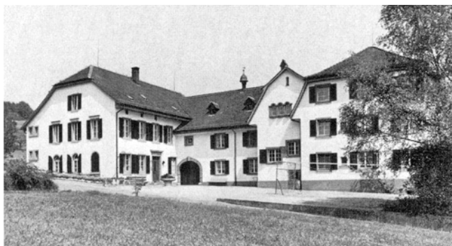
Stäfa. Mühlehlzli. Altersheim Vers. Nr. 1403/1404. Nach der Restaurierung 1976.
