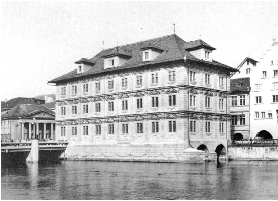
Zürich. Rathaus. Nach der Restaurierung 1974–1977.
