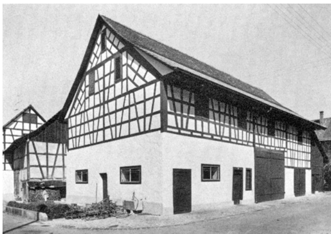
Trüllikon, Schlossgasse. Scheune Vers. Nr. 95. Nach der Aussenrenovation 1975/76.
