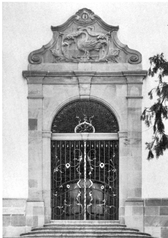
Horgen. Reformierte Kirche. Turmportal. Nach der Restaurierung 1975/76.
