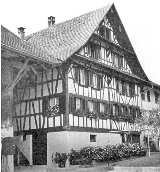
Mettmensstetten. Egi. Bauernwohnhaus Vers. Nr. 714. Nach der Restaurierung 1975.
