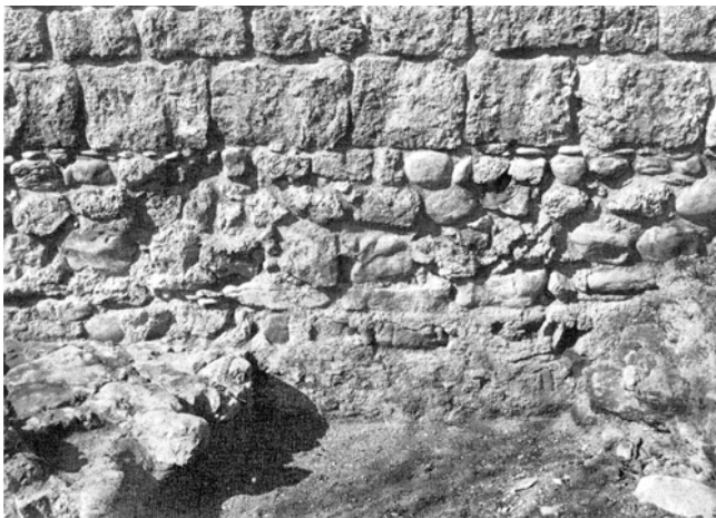
Freienstein-Teufen. Burgruine Freienstein. Südmauer. Nach der Konservierung 1975–1977. Von unten nach oben: Fundamentzone, feine Rollkiesel-schicht, ergänzte Tuffsteinpartie.
