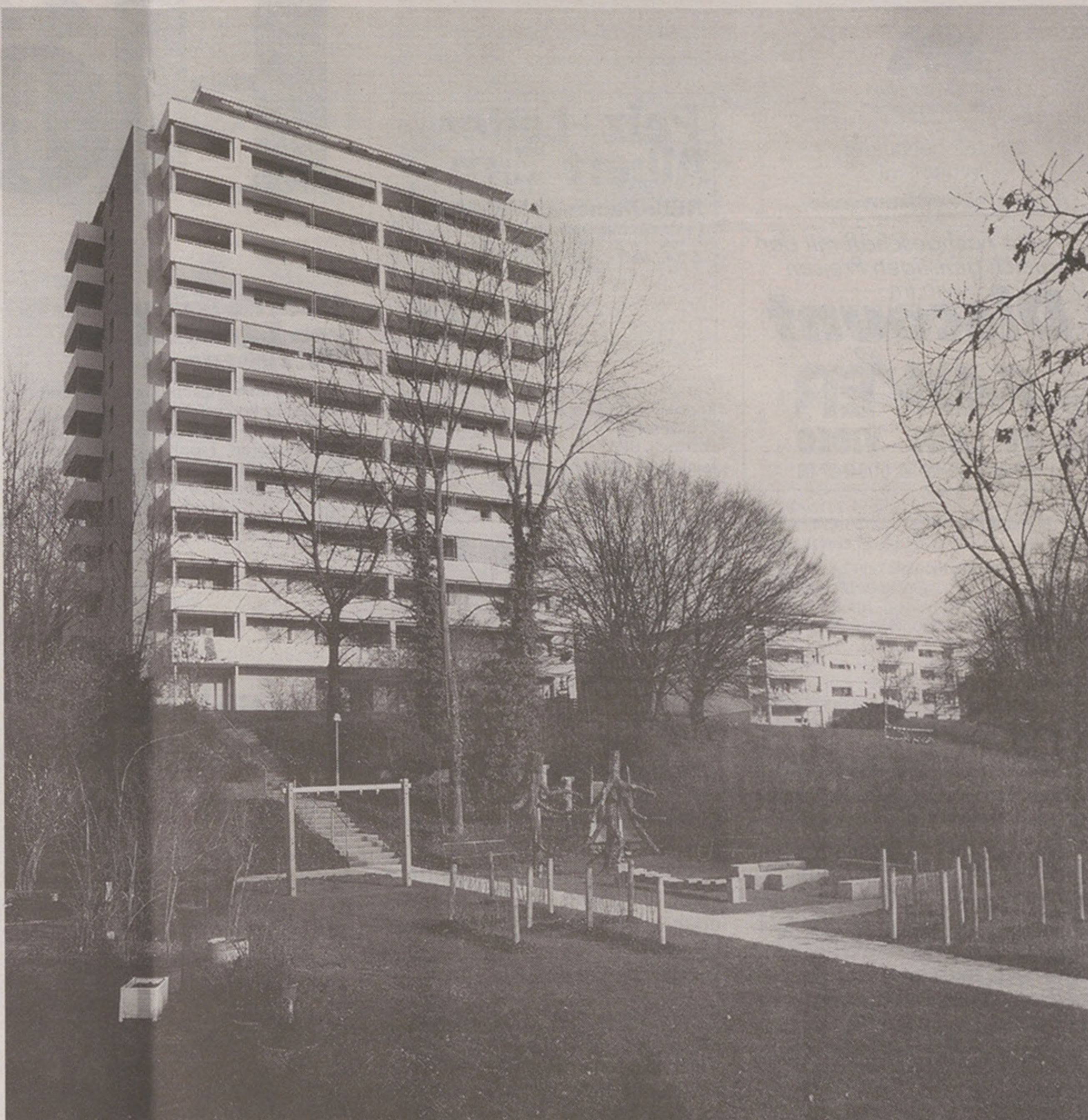
Mit einer sanften Erneuerung wurden die 252 Wohnungen der 50 Jahre alten Wohnsiedlung «Riedhofpark» dem heutigen Wohnstandard angepasst.
