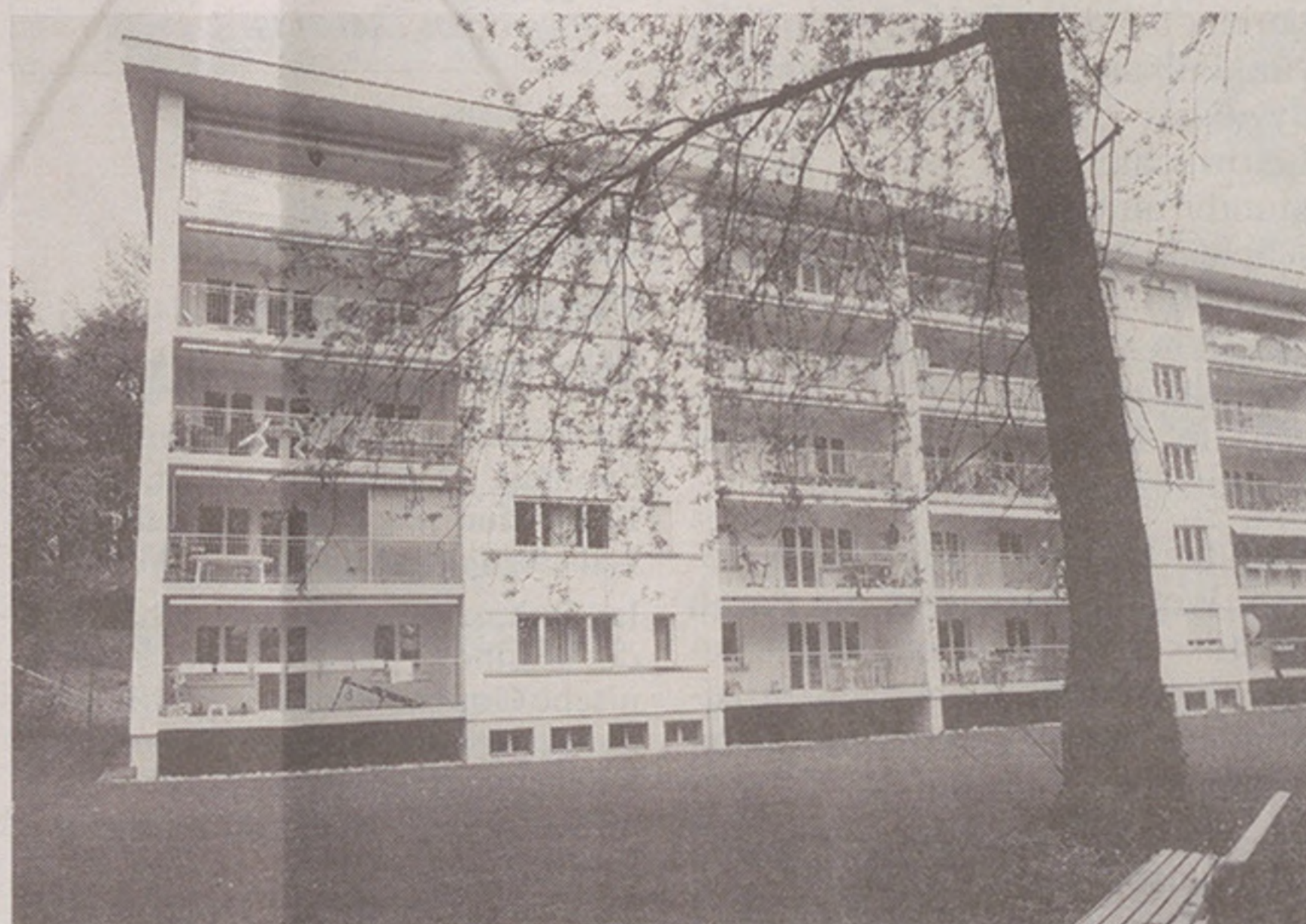
In den Mehrfamilienhäusern der Wohnsiedlung Riedhofpark wurde ein Teil der Balkone vergrössert und mit Metallgeländern versehen. Die Wohnqualität konnte damit massiv aufgewertet werden.
