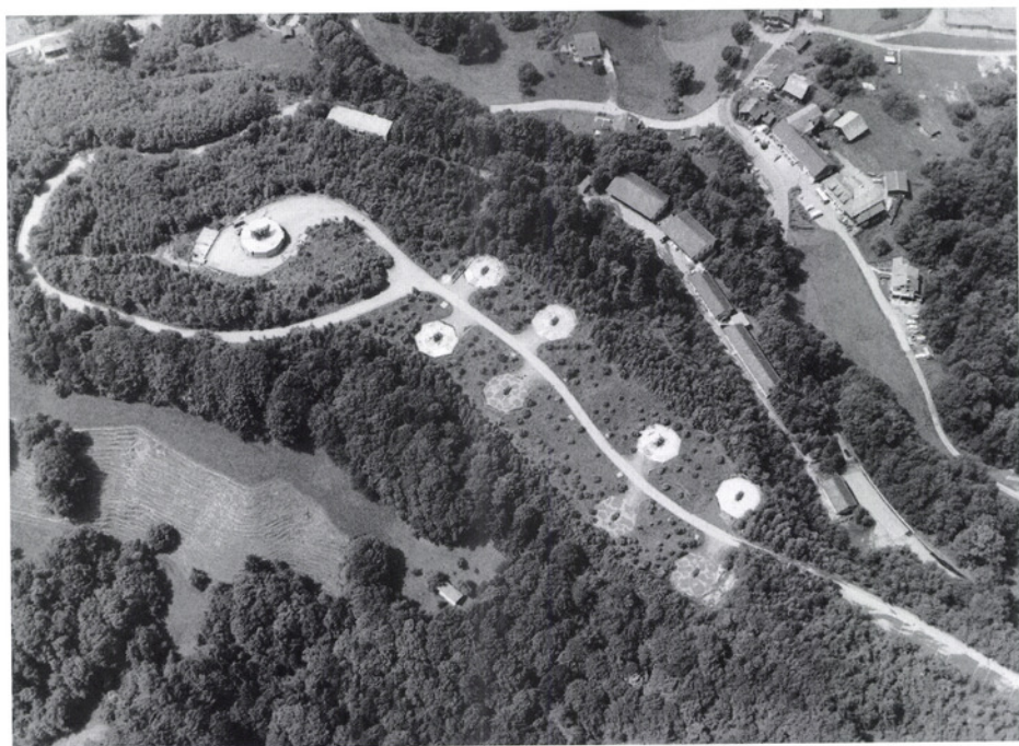
Luftaufnahme der Bloodhoundstellung Schmidrüti im Zürcher Oberland, die durch die AMF-Betriebsgruppe Dübendorf betreut und unterhalten wurde.
