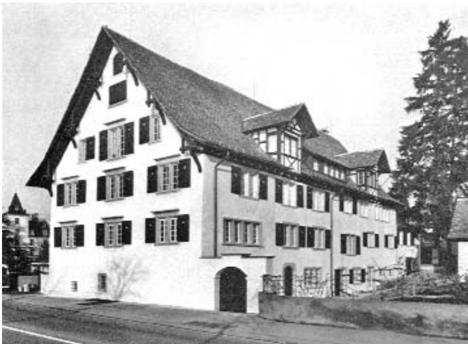
Zollikon. Seestrasse 83. Haus Zum «Trautenberg», nach der Restaurierung. Ansicht aus Süden.
