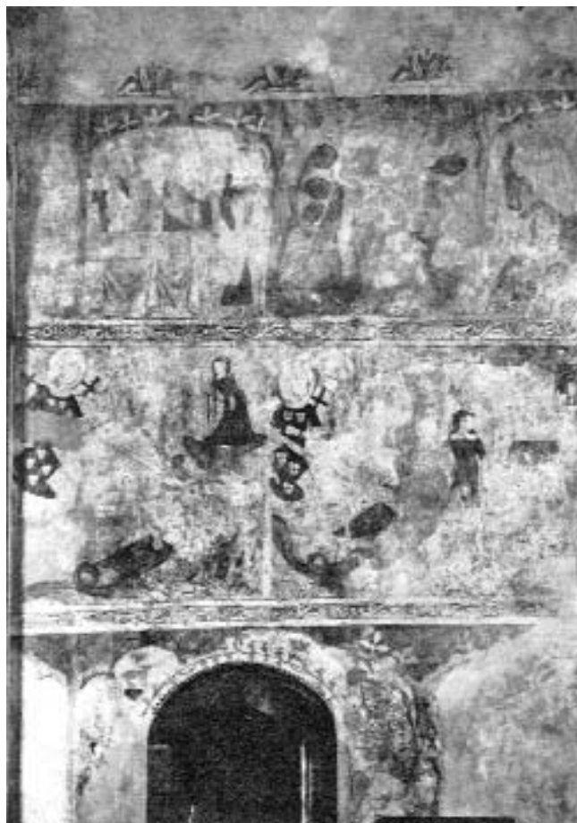
Elgg. Reformierte Kirche. Chornordwand: hochgotische Male- reien, nach der Restaurierung (vgl. das untenstehende Schema).
