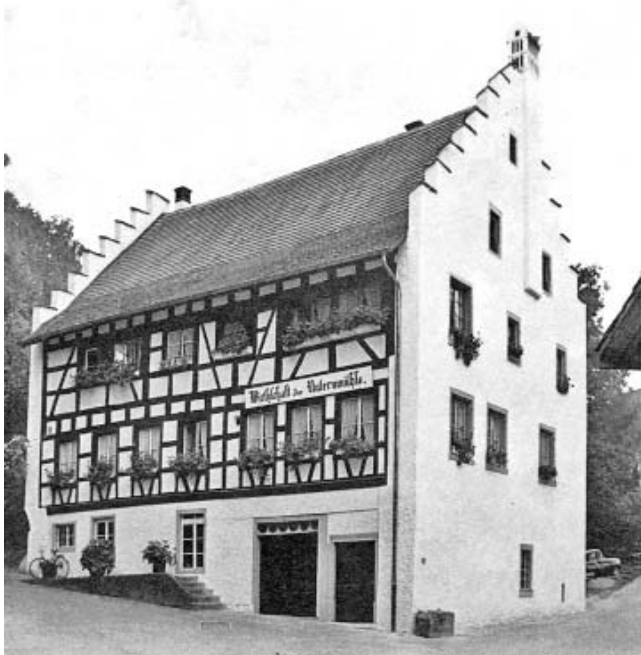
Flaach. Restaurant zur «Untermühle». Nach der Renovation.
