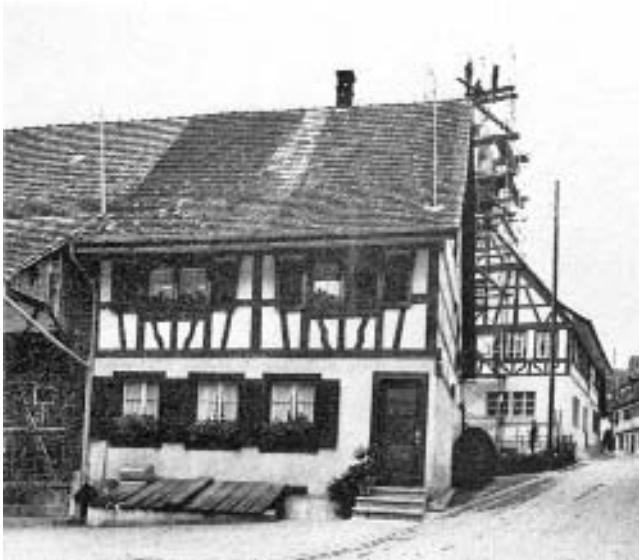
Hüntwangen. Bauernhaus Arnold Meier. Vor der Aufstockung.
