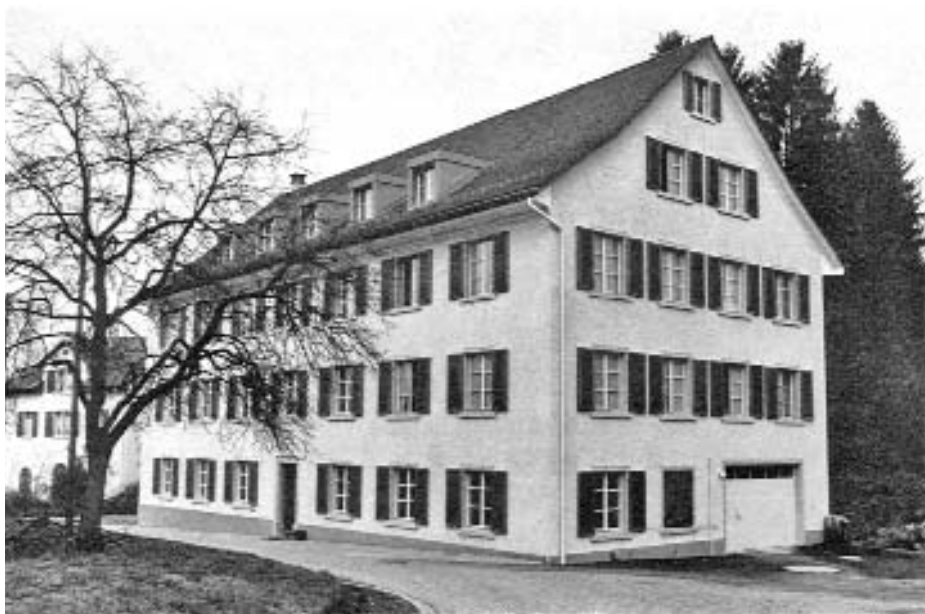
Urdorf. Ehemalige Mühle von 1860. Nach der Renovation.
