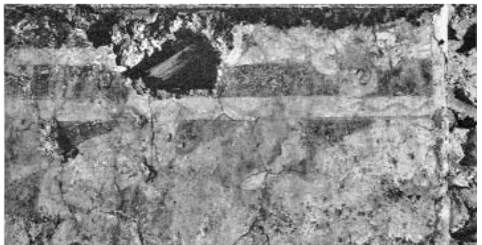
Bassersdorf. Reformierte Kirche. Süd- mauer des Kirchenschiffes mit Resten gotischer Sockelmalerei in Weiss und Grau; Wellenbandrest rechts oben orange. Darüber Ostfenster, rechts ehemaliges Südportal. 1:20.
