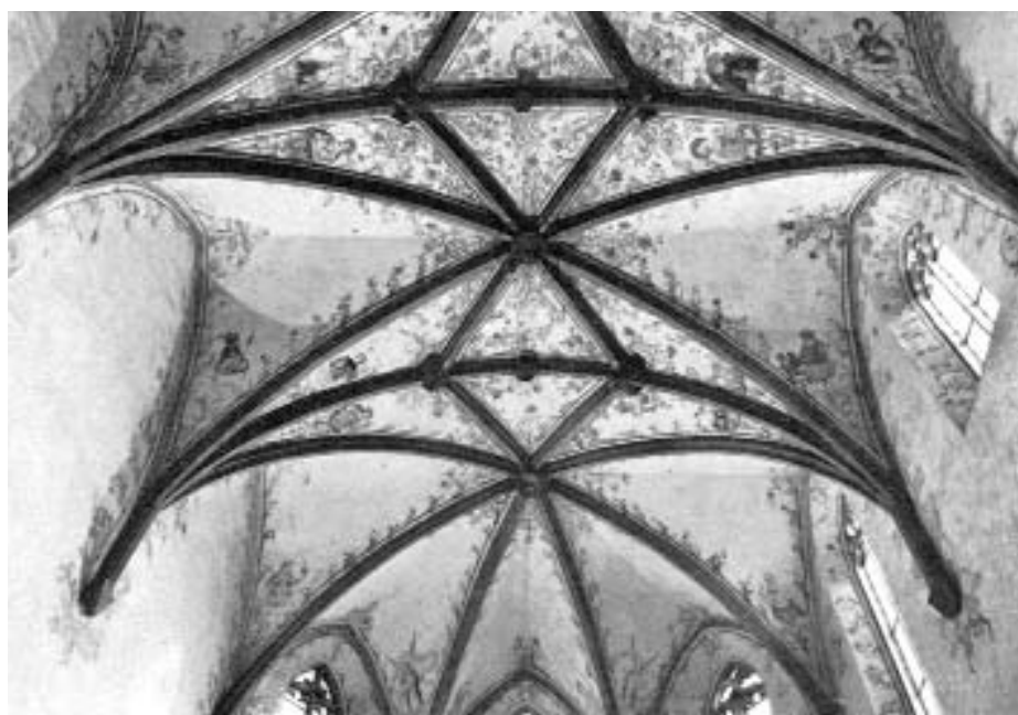
Elgg, Reformierte Kirche. Das Chorgewölbe nach der Restaurierung.
