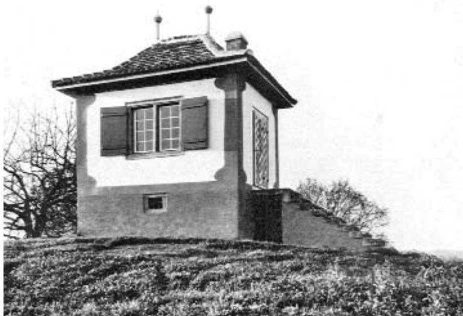
Marthalen. Sogenanntes Guggenbühlhüsli, nach der Restaurierung.
