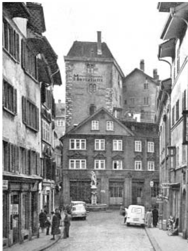
Spiegelgasse 29, Grimmenturm. Zustand vor der Restauration.
