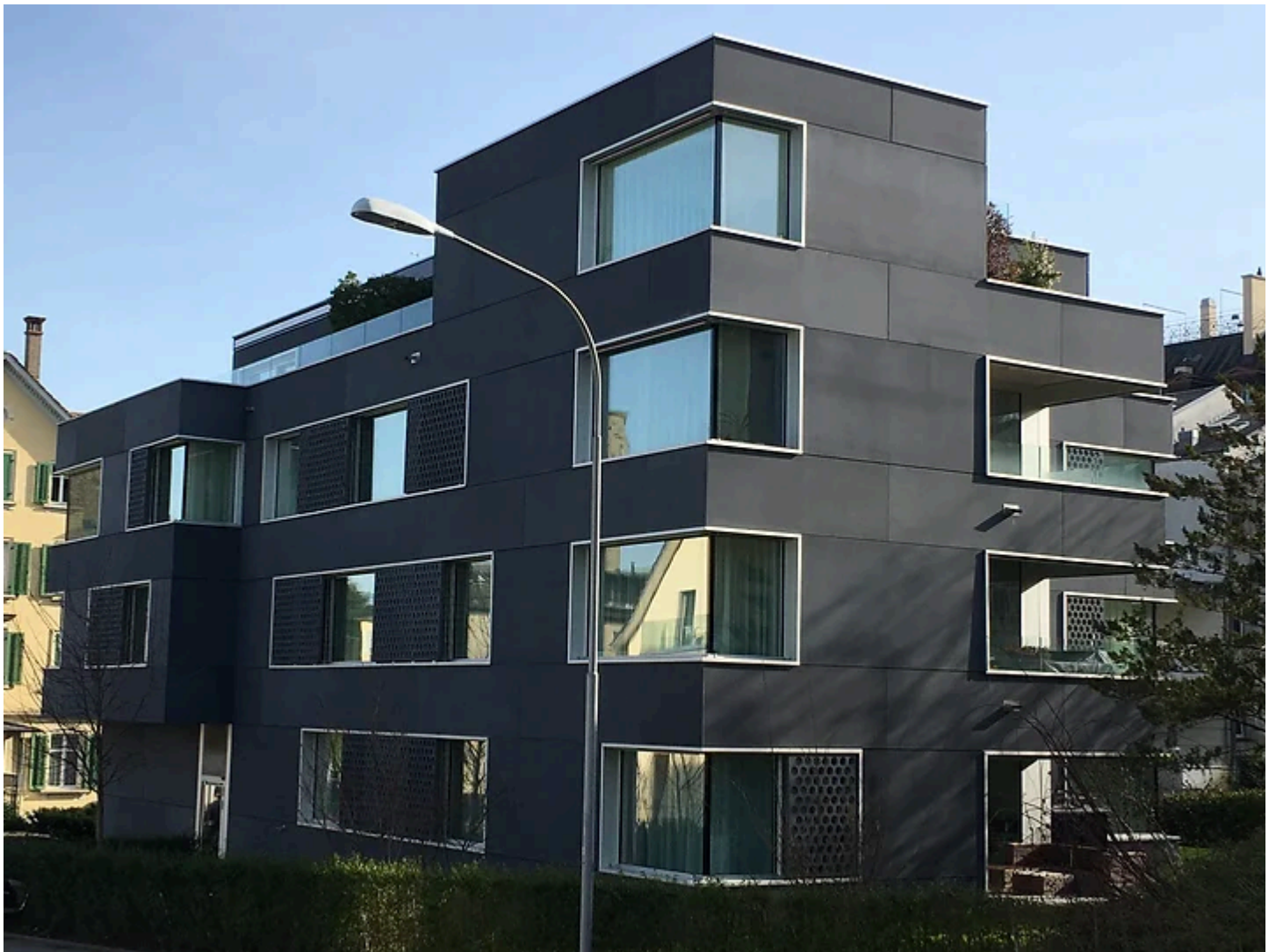
Butzenstrasse 3. Foto: SB (19.2.2021).
