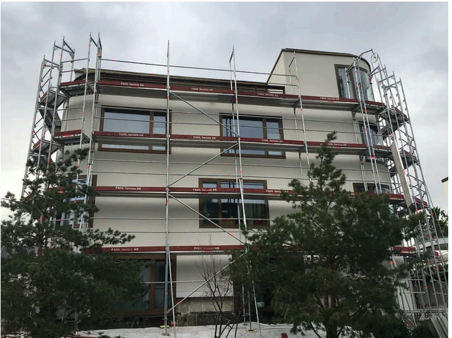
Frohalpstrasse 52. Foto SB. 4.3.2021.
