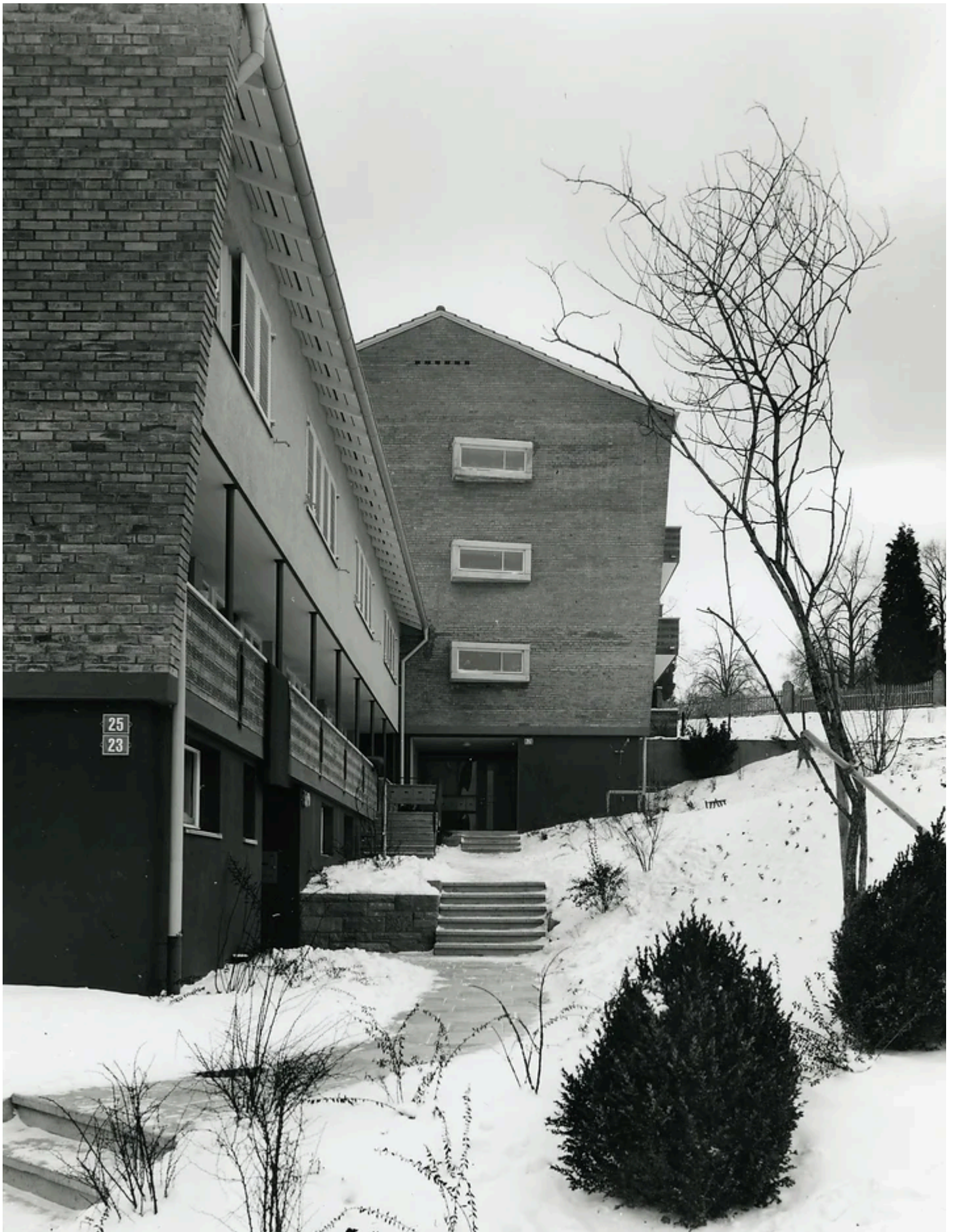
Salomon-Vögelin-Strasse 23/25. Baujahr 1956. Architekten Bruno Giacometti, Robert Winkler. Bauherrschaft Stadt Zürich. Foto: Michael Wolgensinger. Baugeschichtliches Archiv.
