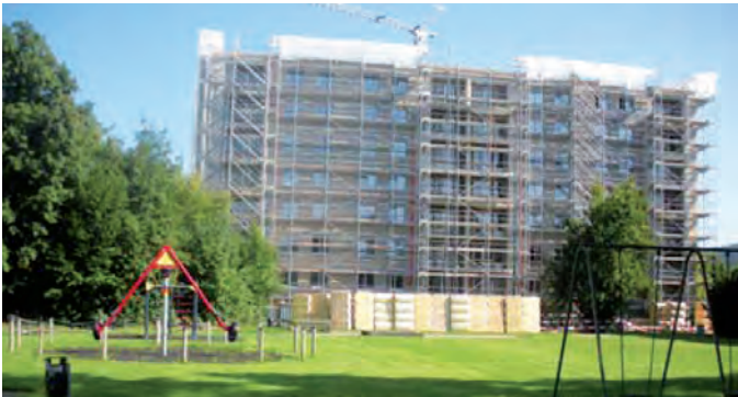
Im Erdgeschoss entsteht die Kita Etzberg
