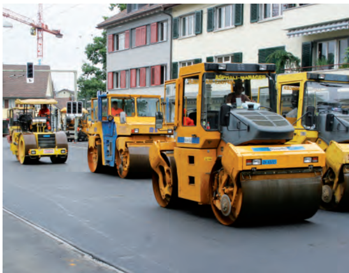
Die Walzen verdichten den Belag als entscheidenden letzten Arbeitsgang
