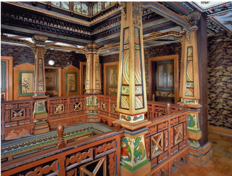
Oben: Halle 3.2 im 1. Obergeschoss und Galerie 4.2 im 2. Obergeschoss. Ausschnitte der Grundrisspläne. KDP A. Links: Ansicht der Galerie gegen Norden. Zustand vor der Restaurierung, Oktober 2007. KDP Fotoarchiv.
