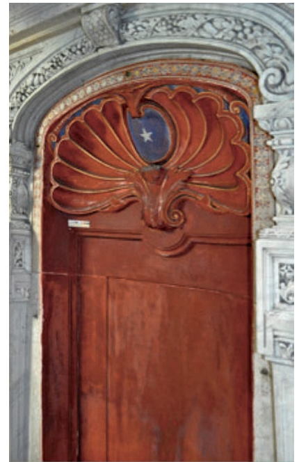
Rot gefasste Marmornische an der Ostfassade. Zustand nach der Restaurierung, November 2013. ARGE Konservierung/Restaurierung Fassaden Villa Patumbah 2013 (wie Anm. 28), S. 130.
