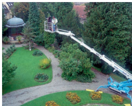
Links und rechts: Fotografische Dokumentation des Vorzustands der Fassaden mit einem Geländebühnenlift. Aufnahmen September 2009. KDP Fotoarchiv.
