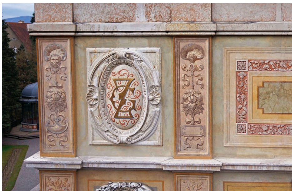
Plastisch gestaltetes Medaillon an der Nordostfassade mit den rekonstruierten goldenen Buchstaben «GZ». Aufnahme März 2014. KDP Fotoarchiv.
