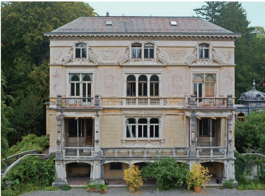
Bei der Errichtung der Westfassade wurden verschiedene Kalksteine in unterschiedlichen Farbtönen sowie Marmor aus Carrara verwendet. Aufnahme September 2009. KDP Fotoarchiv.
