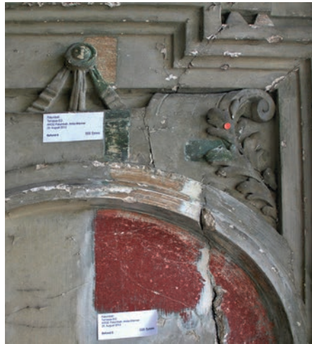
Links: Leibung der nördlichen Loggia an der Westfassade. Zustand vor der Restaurierung, September 2012. Rechts: Leibung der südlichen Loggia an der Westfassade mit freigelegter originaler Fassung. Aufnahme August 2012. ARGE Konservierung/Restaurierung Fassaden Villa Patumbah 2013 (wie Anm. 28), S. 133 und 136.
