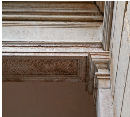
Links: Gereinigte Marmor- und Kalksteinoberflächen. Rechts: Gereinigte Oberflächen von Kalkstein. Gewisse Partien wurden mit Mörtel ergänzt. Aufnahmen Gregor Frehner, April 2013.
