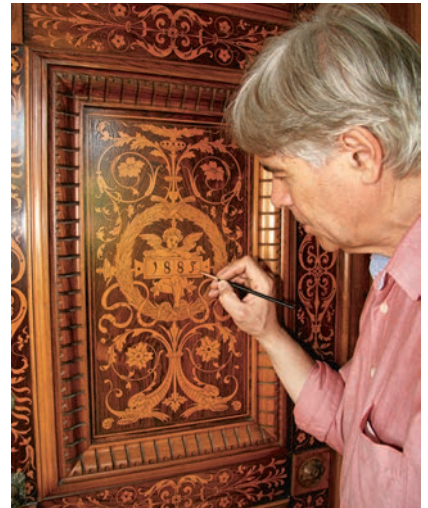
Die Jahreszahl 1885 an der Schiebetüre vom Zimmer des Herrn zum Salon wird mit getöntem Schellack retuschiert. Mai 2013. Aufnahme Jörg Magener.
