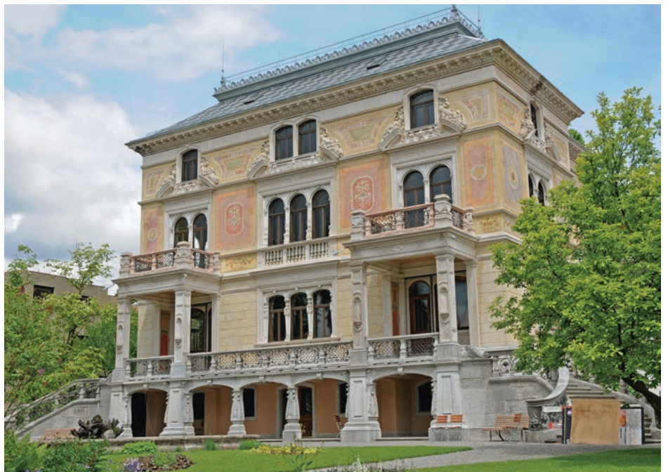
West- und Südfassade. Zustand nach der Restaurierung, Mai 2013. Aufnahme Doris Warger.
