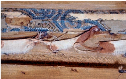
Oben: Detail einer gemalten Säule an der Südostwand im Vestibül. Zustand während der Freilegung, April 2002. Unten: Freilegungsfenster an der Nordwestwand im Zimmer des Herrn (Raum 2.6). Die Aufnahme zeigt im oberen Teil ein Fragment der originalen Tapete. Aufnahme April 2002. IGA Archäologie Konservierung.
