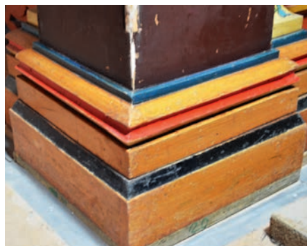
Basis einer Stütze auf der Galerie. Links: Die Ecken sind abgestossen, die Malschicht stark zerkratzt. Zustand vor der Restaurierung, Dezember 2011. Rechts: Zustand nach der Reinigung, dem Kitten und Retuschieren der Fehlstellen, Februar 2012. ArGe Harsch, Müller und Waldispühl.
