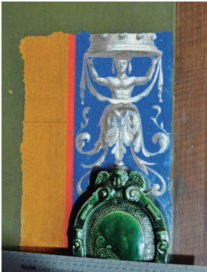
Oben: Freilegemuster an der Ofenwand. Zustand während der Restaurierung, Juni 2012. Aufnahme Deborah Gos. Unten: Querschnitt durch die Malschicht der Decke. Mikroskopieaufnahmen mit Anfärbetest zum Nachweis der verwendeten Bindemittel von Deborah Gos und Kathrin Harsch, März 2013.
