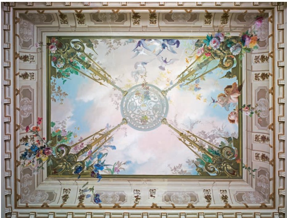
Die Decke des Wintergartens nach der Restaurierung. Aufnahme Februar 2013. KDP Fotoarchiv.
