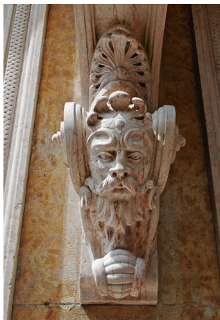
Oben: Der Restaurator Gregor Frehner während der Reinigung von Marmoroberflächen. Aufnahme Juli 2011. Frehner 2013 (wie Anm. 1), S. 26. Links: Reinigung einer Konsole aus istrischem Kalkstein an der Ostfassade. Aufnahme René Lechleiter, November 2012. Rechts: Gereinigte Konsole aus istrischem Kalkstein an der Ostfassade. Aufnahme Gregor Frehner, Juni 2013.
