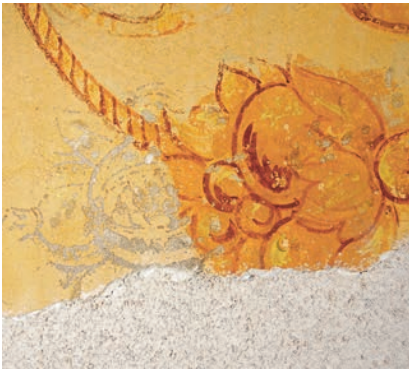
Malschicht der dritten Überarbeitungsphase an der Nordfassade. Aufnahme Juli 2011. ARGE Konservierung/Restaurierung Fassaden Villa Patumbah 2013 (wie Anm. 28), S. 81.
