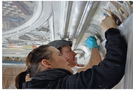
Links: Freilegungsarbeiten in der östlichen Ecke. Rechts: Freilegungsarbeiten an der Hohlkehle. Aufnahmen Januar 2013. Fischer Restaurierung GmbH.
