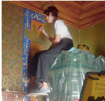
Links: Die Restauratorin verrichtet ihre Feinstarbeit in heikler Umgebung: Rollgerüst, Laboratoriumsutensilien, Schutz- und Abdeckmassnahmen. Aufnahme Februar 2013. Rechts: Die anspruchsvolle Arbeit verlangte Fachwissen, grosse Sensibilität, sichere Hände und manchmal auch akrobatisches Geschick. Aufnahme Juni 2012. René Lechleiter.
