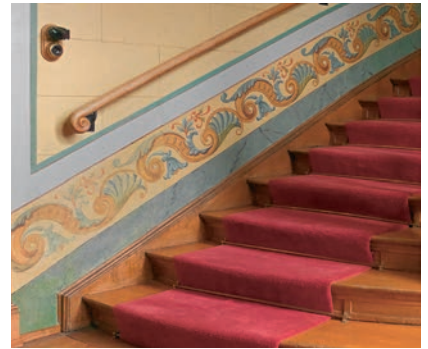
Die Aufnahme zeigt den Übergang vom originalen zum rekonstruierten, dekorativen Ornamentband an der Treppenhauswand im 1. Obergeschoss. Aufnahme August 2013. KDP Fotoarchiv.
