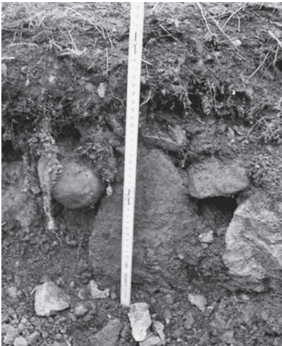
Oben: Profilfoto des Querweges (B). Über den hochkant, dicht aneinander-gesetzten Bruchsteinen der Packlage sind noch die Ausgleichsschicht und Reste der ehemaligen Deckschicht unter der Grasnarbe erkennbar. Aufnahme Anita Drexel, 2005. Unten: Grabungsprofil Hauptweg in Steigungskurve (C). Links: Schnitt und Grundriss. Rechts: Profilfoto. Der breite, befahrene Wegabschnitt mit bis zu 10 Prozent Gefälle erhielt durch Mittelüberhöhung und starke seitliche Einspannungen mit grossen Streck- und Einfassungssteinen eine solide Konstruktion. Profilzeichnung und Aufnahme Anita Drexel, 2005.
