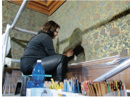
Links: Ausschnitt der Tapete im Salon. Die durch einen Wasserschaden beeinträchtigte Stelle ist auch nach der Restaurierung noch sichtbar. Zustand August 2012. KDP Fotoarchiv. Rechts: Die Restauratorin an der Arbeit. Aufnahme Cristina Tropeano, Oktober 2012.
