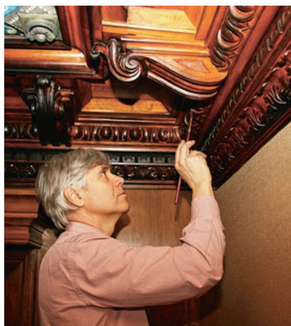
Oben: Der Restaurator poliert den Stabfries der Kassettendecke im Zimmer des Herrn mit Schellack. April 2013. Unten: Ein Teil des Parkettbodens aus dem Zimmer des Herrn wird im Atelier restauriert. Januar 2011. Aufnahmen Jörg Magener.
