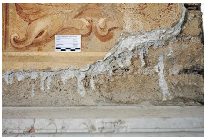
Oben: Nordfassade. Im oberen Drittel befindet sich eine neue Putzergänzung, die dem umliegenden Verputz in Struktur und Tonalität entspricht. Im Streiflicht sind die erhabenen Malschichtreste zu sehen. Aufnahme Mai 2012. Unten links und rechts: Die beiden Aufnahmen zeigen Hinterspritzungen von Randzonen. Ablösungen zwischen Grundputz und Malgrund wurden hier hinterfüllt. Aufnahme Juli 2011. ARGE Konservierung/Restaurierung Fassaden Villa Patumbah 2013 (wie Anm. 28), S. 108 und 109.
