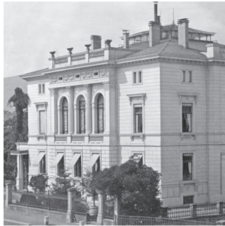
Zu den prächtigsten Villen des 19. Jahrhunderts in Zürich gehörten die Villa Wegmann (links) an der Hohenbühlstrasse 15, erbaut 1887–1889 von Alfred Friedrich Bluntschli, und der inzwischen leider abgebrochene Neue Sihlgarten (rechts), der 1856–1859 von Ferdinand Stadler erstellt wurde. Links Aufnahme um 1890, rechts Foto von Jean Gut, 1880. BAZ.
