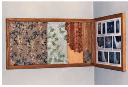
Links: Fragment einer grünen Tapete im Raum 4.9. Das florale Muster mit goldenen Punkten ist kaum noch erkennbar. Aufnahme Januar 2012. Rechts: Die vier Tapeten im Raum 4.7 wurden in situ konserviert und stufenförmig voneinander abgelöst. Zum Schutz der Tapeten wurde ein verglaseter Rahmen angebracht. In der benachbarten Schautafel werden die einzelnen Arbeitsschritte erklärt. Aufnahme Juli 2014. Ars Artis AG.
