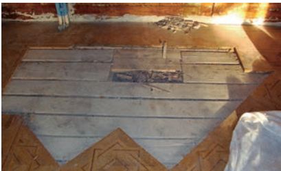
Oben: Ostecke im Raum 3.4 im 1. Obergeschoss. Zustand während der Restaurierung, November 2010. Unten: Ein Teil des Parkettbodens im Zimmer des Herrn wurde entfernt und im Atelier restauriert. Zustand während der Restaurierung, November 2010. Aufnahmen Jörg Magener.
