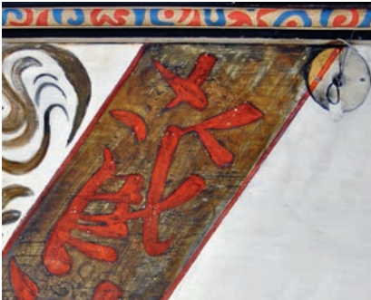
Oben: Unter einer ehemaligen runden Abdeckung in der oberen rechten Ecke hat sich die ursprüngliche Farbigkeit des Schriftbands erhalten. Unten: Die gelblich-braunen Flecken an der Oberfläche der Malerei gehen auf lösliche Anteile zurück, die bei einem Wassereinbruch aus der Holzlatten-Unterkonstruktion in den Gipsputz gespült wurden. Aufnahmen März 2014. ArGe Harsch, Müller und Waldispühl.
