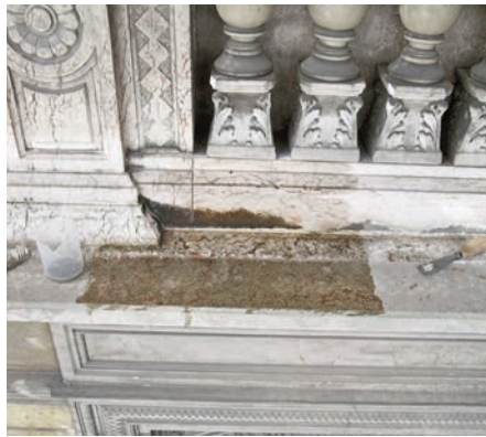
Links und rechts: Reinigungsmuster. Aufnahmen Gregor Frehner, April 2011.
