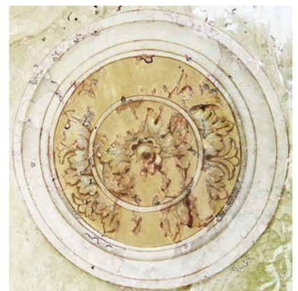
Musterachse an der Südfassade. Oben: Durchzeichnung 1995/1996. Vor der Musterrestaurierung, im ungefestigten Zustand, schritt der Verlust an Originalsubstanz innert eines Jahres sehr schnell voran. Unten: Vorzustand 2011, Durchzeichnung. Die schwarzen Punkte und Striche zeigen die neuen Flankenabriss und winzige Fehlstellen nach vierzehn Jahren auf. ARGE Konservierung/Restaurierung Fassaden Villa Patumbah 2013 (wie Anm. 28), S. 51.
