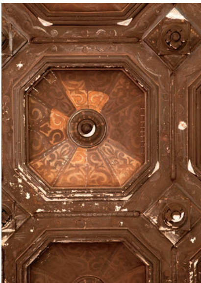
Freilegungsproben mit unterschiedlichen Techniken und Materialien an einer Kassette der Decke im Zimmer des Herrn. Aufnahme Mai 2012. KDP Fotoarchiv.
