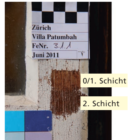
Oben: Schichtenfreilegung zur Bestimmung der Holzarten und Oberflächen. Unten: Neben aufliegenden Basquilleverschlüssen schmücken aufwändig gestaltete Beschlagteile die Fenster. Hier ein Klemmverschluss für den Seilzug der Oberlichtöffner. Aufnahmen Hermann Klos, Juni 2011.
