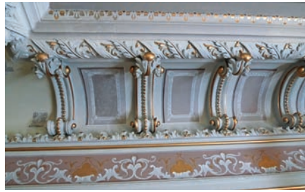
Links: Freilegungsprobe der originalen Fassung am Stuckrahmen. Aufnahme April 2012. Rechts: Die restaurierte Musterachse diente als Vorlage für die Rekonstruktion der Stuckfassung. Die violetten Füllungen mit dem feinen Stuckrahmen zwischen den Konsolen sind ebenfalls plastische Dekorationsmalereien. Aufnahme August 2012. Stöckli AG Stans.
