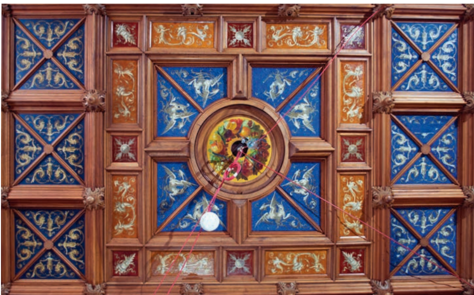
Ausschnitt der Decke. Nach der Abnahme des alten Firnisses zeichnen sich die Deckenfelder durch eine intensive Farbigkeit aus. Zustand nach der Restaurierung, Februar 2013. Aufnahme Kathrin Harsch.
