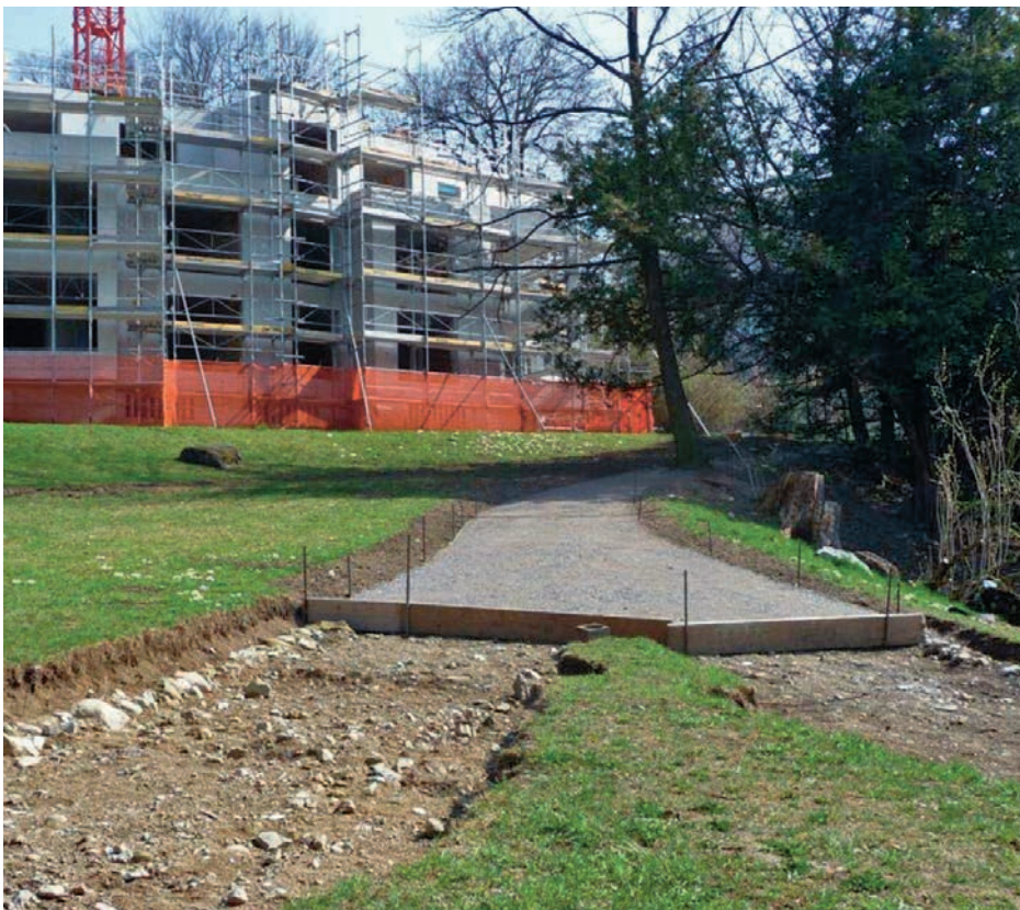
Der Brezelweg wird sukzessive auf seiner originalen Kofferung erneuert. Aufnahme Judith Rohrer, Frühling 2012.
