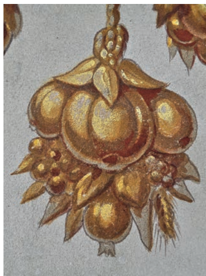
Oben: Übermaltes Granatapfelmotiv an der Südfassade. Die hellgelben Lichter wurden vermutlich mit einem Bronzepigment akzentuiert, welches jedoch abwitterte und einen kleinen Lochschaden hinterliess. Aufnahme März 2013. ARGE Konservierung/Restaurierung Fassaden Villa Patumbah 2013 (wie Anm. 28), S. 87. Unten: Maskenmotiv an der Ostfassade. Aufnahme April 2013. KDP Fotoarchiv. Folgende Seite: Feld mit Tabakblättern an der Ostfassade. Zustand nach der Restaurierung, April 2013. KDP Fotoarchiv.
