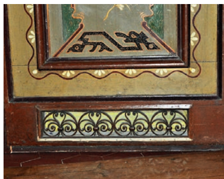
Links: Die zwei Metallgitter auf der als Türen ausgebildeten Täferfüllung rechts dienen der Warmluft-Einführung, auf derjenigen links wird das Dreiecksmotiv als Malerei weitergeführt. Das Türchen befindet sich in der Westecke der Halle. Aufnahme September 2013. Rechts: Gitteröffnung für den Warmluftdurchgang im unteren Rahmen der Türe zum Toilettenraum der Halle. Aufnahme März 2014. ArGe Harsch, Müller und Waldispühl.
