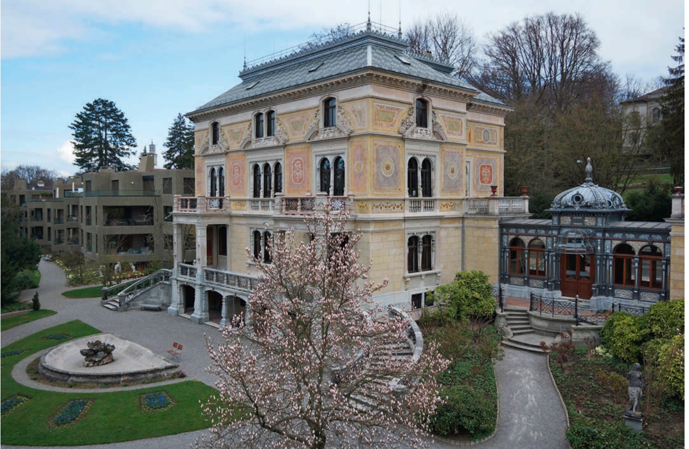
Die Villa Patumbah von Süden. Im Hintergrund links, entlang der Zollikerstrasse, die Neubauten von Miller & Maranta, Basel. Aufnahme März 2014. KDP Fotoarchiv.
