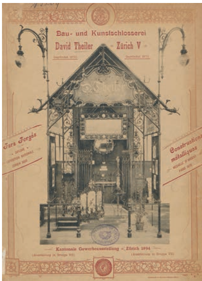
Oben: Einband des Katalogs für die Kantonale Gewerbeausstellung 1894 in Zürich. Unten: Balkonbrüstung, Fenstergitter und Treppenabgang in den Park mit reichen Schmiedeeisenarbeiten von David Theiler. Bau- und Kunstschlosserei Theiler 1894 (wie Anm. 1).
