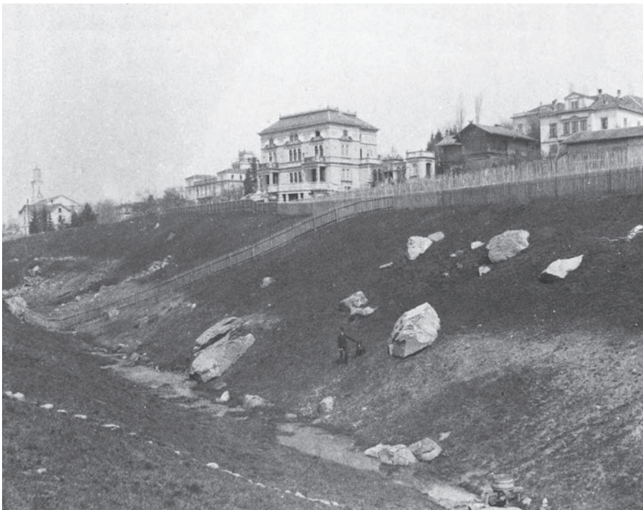
Weit öffnet sich der Krokodilgraben unterhalb der Villa Patumbah. Hinter der Villa sind die Engel-, die Martins- und die Steffenburg zu sehen. Aufnahme vom 15. April 1888. Privatarchiv Pit Wyss, Dielsdorf.
