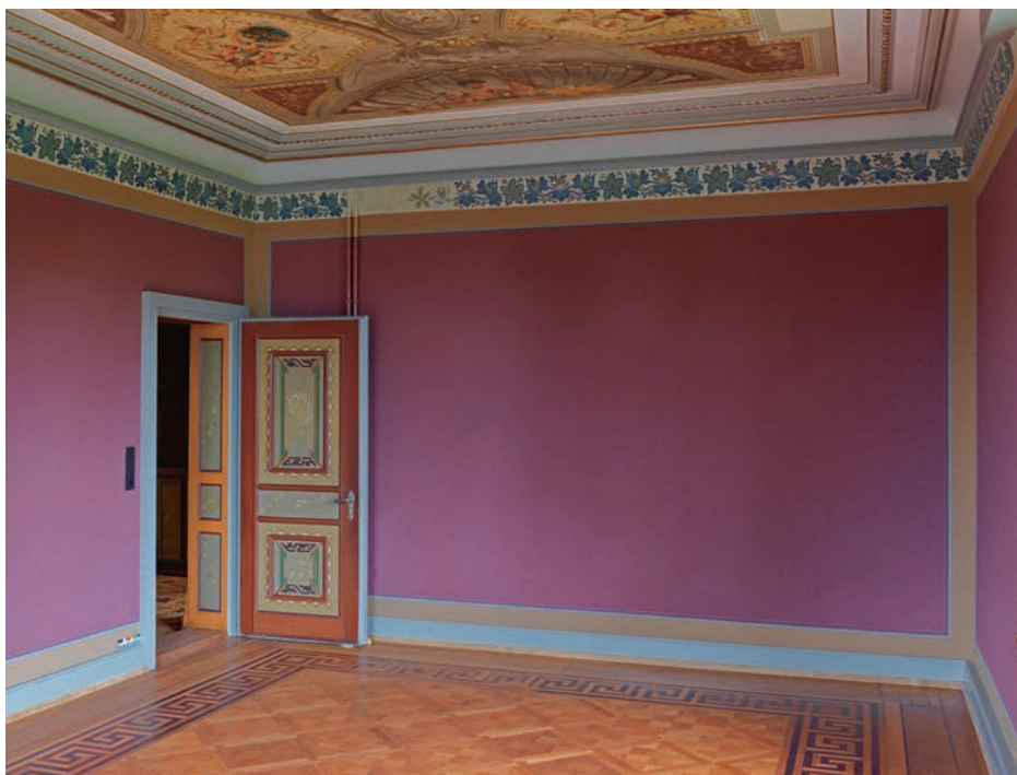
Ansicht des sogenannten Vesuvzimmers gegen Norden. Über der Türe ist im ornamentalen Band eine grössere Fehlstelle sichtbar, in welcher die verschiedenen Schritte des Aufbaus der Malerei von der Punktierung bis zum fertigen Ornament dokumentiert sind. Zustand nach der Restaurierung, Mai 2013. KDP Fotoarchiv.
