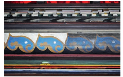
Links: Gesims der Glaskuppel gegen Norden. Der Abschnitt in der linken Bildhälfte ist gereinigt; derjenige in der rechten Bildhälfte ist mit Russ verschmutzt. Oben: Ausschnitt des Gesimses der Glaskuppel. In der linken Bildhälfte ist der erzielte Reinigungserfolg besonders augenfällig. Aufnahmen März 2014. ArGe Harsch, Müller und Waldispühl.
