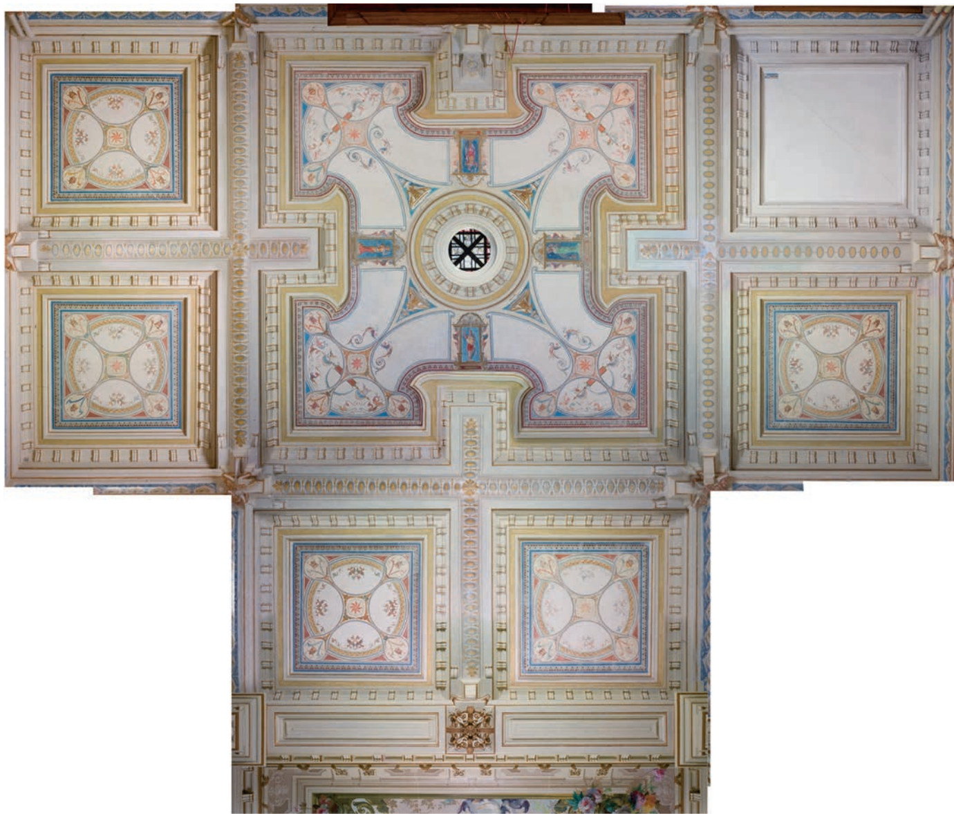
Die Decke des Vestibüls (Raum 2.5) nach der Restaurierung. Das Deckenfeld in der westlichen Ecke wurde nicht freigelegt. Aufnahme Februar 2013. KDP Fotoarchiv.
