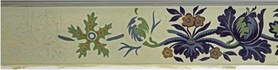
Der gemalte, an den Wänden direkt unterhalb der Decke umlaufende Fries wurde freigelegt und restauriert. Die Restauratoren rekonstruierten die Malerei an einer grossen Fehlstelle im Nordosten nur im Aufbau: Die Foto zeigt die mit einer Lochpause übertragene Vorzeichnung (links) und anschliessend den schrittweisen Aufbau der Malerei. Zustand nach der Restaurierung. Aufnahme 2012. Stöckli AG Stans.
