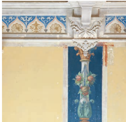
Zwei verschiedene Säulenschäfte im Vestibül. Links: Zustand unmittelbar nach der Freilegung, Juni 2012. Rechts: Zustand nach dem Schliessen der Fehlstellen im Bereich des Hintergrunds, Juni 2012. KDP Fotoarchiv.
