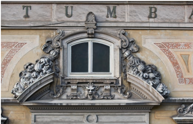
Links: Gesprengte Segmentbogen- giebel-Verdachung aus Carrara-Marmor an der Ostfassade. Aufnahme Septem- ber 2009. Rechts: Der Sockelbereich der Westfassade besteht aus weissem Solithurner Kalkstein. Aufnahme April 2010. KDP Fotoarchiv.
