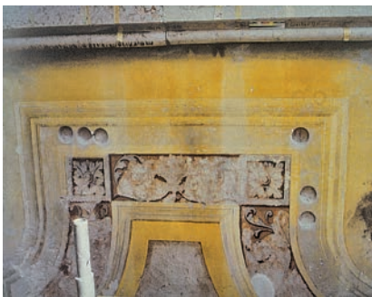
Wenig sensibel gesetzte material-technische Sondierbohrungen an der Nordwestfassade in der Vorbereitungsphase der Restaurierung. Aufnahme 1995. Albert Romer, mattec+, Lenzburg. Wohleben/Sigel 1998 (wie Anm. 5), S. 183.
