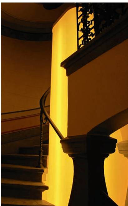
Leuchtojekt im Treppenauge im Treppenlauf vom Untergeschoss ins Erdgeschoss. Aufnahme Januar 2014. Pfister Schiess Tropeano Architekten.
