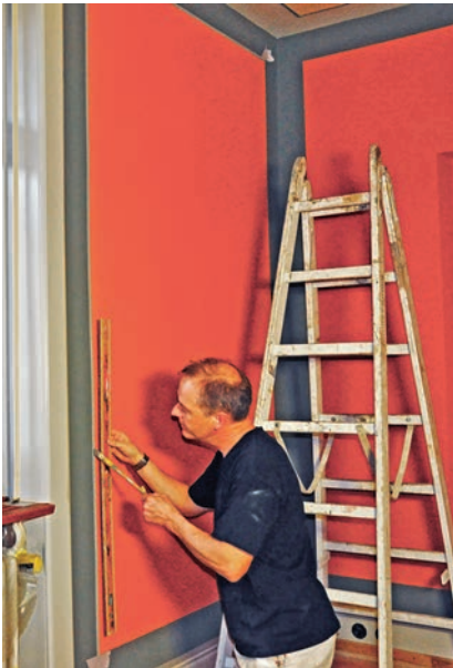
Oben: Der Restaurator bringt Bänder und Linien in alter Manier mit dem Strichzieher an. Aufnahme März 2013. Unten links: Ansicht des Raums 3.3 mit restaurierter Decke und neuer Farbigkeit der Wände. Unten rechts: Zusammenspiel der neugestalteten Wände mit der reichen historischen Bausubstanz im Raum 3.8. Aufnahmen Mai 2013. Fontana & Fontana AG.
