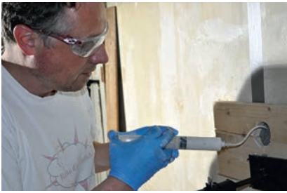
Oben: Bei geschlossenen Flächen mussten die von aussen intakten Putzoberflächen angebohrt werden. Die Putzstruktur konnte so durch gezielte, punktuell angesetzte Injektionen gesichert werden. Aufnahme April 2012. ARGE F3M. Unten: Die Südwestwand des Vestibüls. Zustand nach der Restaurierung, April 2013. KDP Fotoarchiv.
