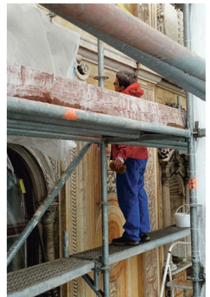
Ein ungewöhnliches Bild auf Schweizer Baustellen: An den Arbeiten zur Rettung und Wiederherstellung des Fassadenverputzes und der Keim'schen Mineralfarbmalerien waren einige Frauen federführend beteiligt; eine fachspezifische Tätigkeit unter nicht sehr einfachen Bedingungen. Aufnahme Juni 2011. René Lechleiter.
