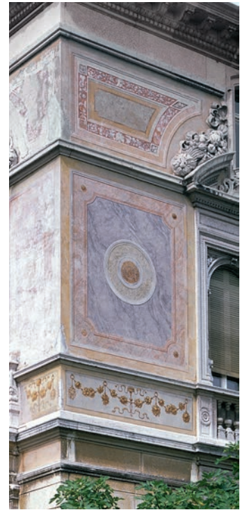
Südwestliche Gebäudeecke im Bereich der oberen Geschosse. Aufnahme September 2006. KDP Fotoarchiv.
