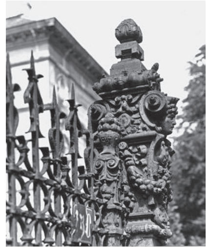
Detail eines ornamentierten Gusseisenpfostens. Zustand um 1970. BAZ.
