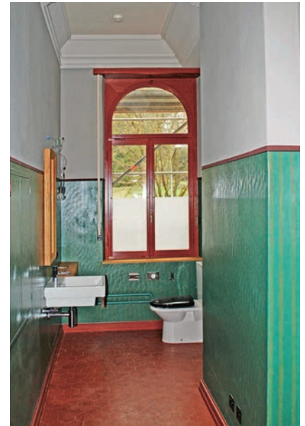
Oben: WC-Raum im 1. Obergeschoss. Im Sockelbereich wurde eine modern interpretierte, historische Technik (Kammzug) angewendet. Aufnahme April 2013. Unten links und rechts: Auszüge aus dem Raumbuch mit dem Farbkonzept. Links: Farbvorschlag für den Raum 3.4 (Musterzimmer). Rechts: Farbvorschlag für das Zimmer 3.3 mit freigelegter und restaurierter Decke. Fontana & Fontana AG.
