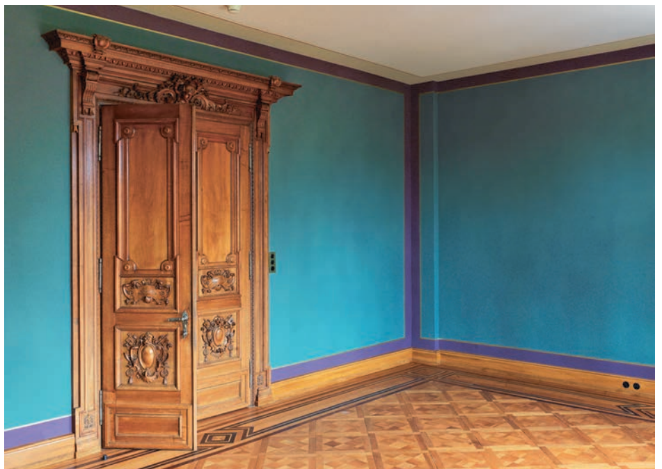
Der Raum 3.4 diente während der Bauphase als Musterzimmer, weil er mit Ausnahme der reich gestalteten Türe weder an den Wänden noch an der Decke Befunde einer originalen Fassung aufwies. Zustand nach der Restaurierung, Mai 2013. KDP Fotoarchiv.
