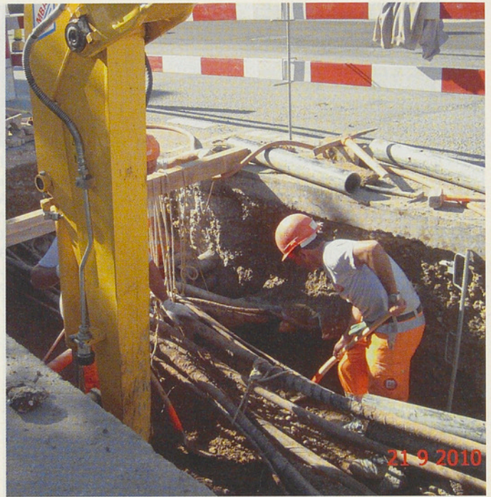
Erneuerung der elektrischen Leitungen Höhe ZKB
