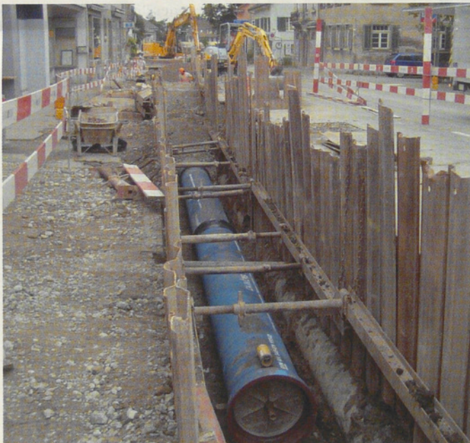
Erneuerung der Hauptwasserleitung Abschnitt Bollstrasse-Kanzleistrasse
