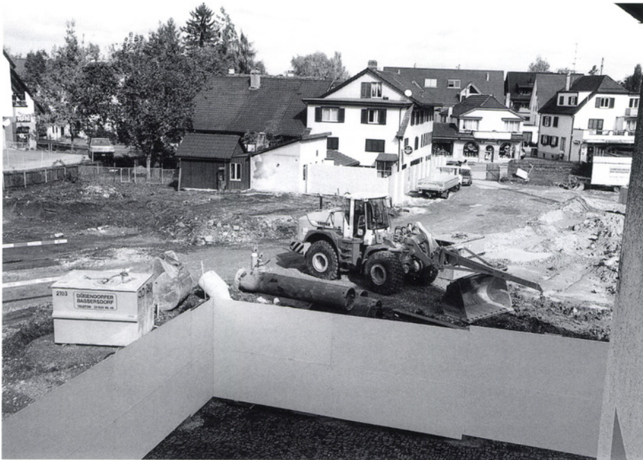
Auf dem 5000 Quadratmeter grossen Hüsler-Areal zwischen Bahnhofstrasse und Marktgasse realisiert die Helvetia-Patria eine grosse Überbauung mit Verkaufs- und Dienstleistungsflächen und 18 luxuriösen Wohnungen. Blick auf die Baustelle Richtung Wallisellenstrasse von Mitte Oktober 2002.
