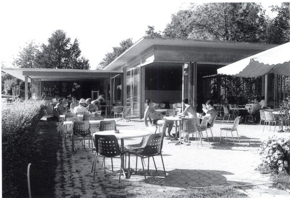
Das Restaurant des Schwimmbades wurde vollständig und umfassend erneuert. Architekt Rolf Schaffner schuf einen luftigen und eleganten Bau, der rundum befriedigt und rechtzeitig zur Saisoneröffnung fertig war.
