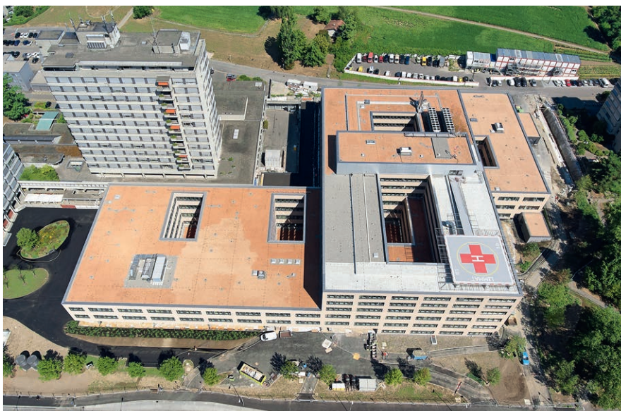
Neuer Spitalbau von oben. Sichtbar sind die vielen Innenhöfe
