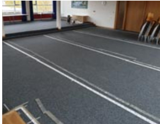
Induktionsschleife im Bucksaal
