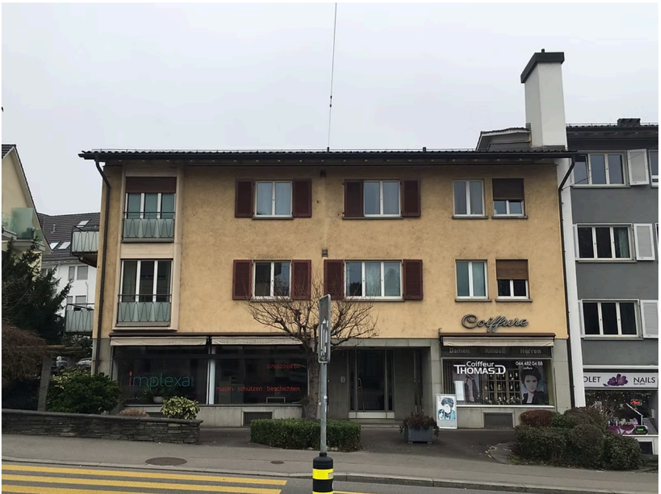
Albisstrasse 76. Baujahr 1951. Foto Dezember 2025 (SB).
