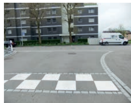
Trottoirüberfahrt ohne Signalisation: Einmündung Poststrasse in die Huebwiesenstrasse
