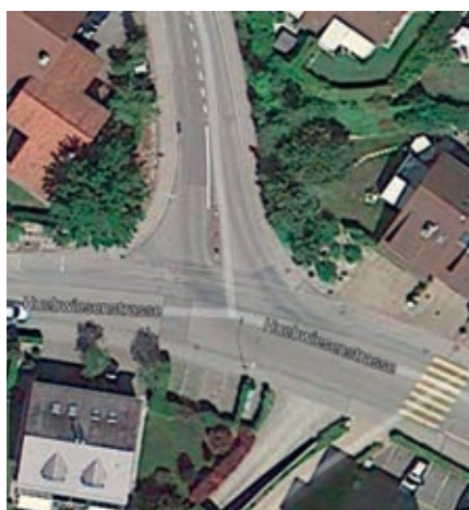
Achtung! Kein Vortritt bei einer Trottoirüberfahrt
