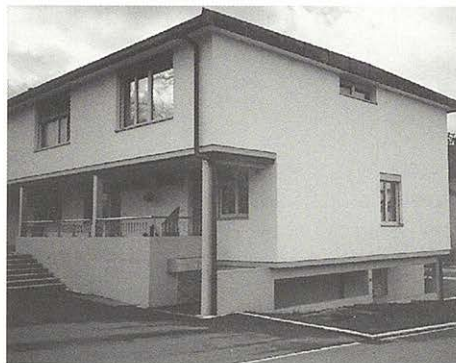
Ansicht des Hauses Stationsstrasse 10 (Gemeindehaus) mit dem Polizeiposten (1959–1982) und darüberliegender Dienstwohnung.
