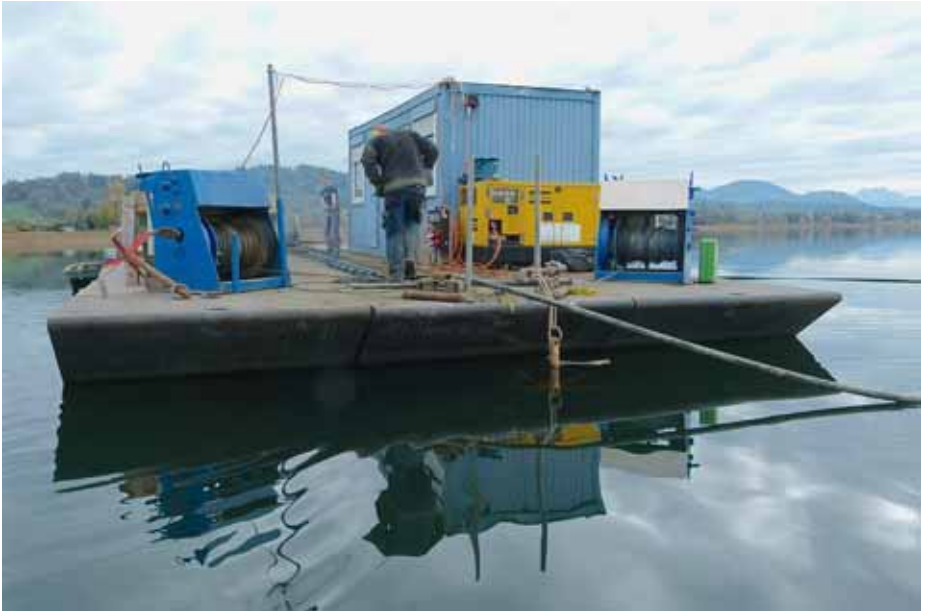
Abb. 20: Nach deren Hebung wurden die Rohre auf dem Floss freigelegt, und die Materialien stoffgerecht entsorgt. (Foto E. Ott)
