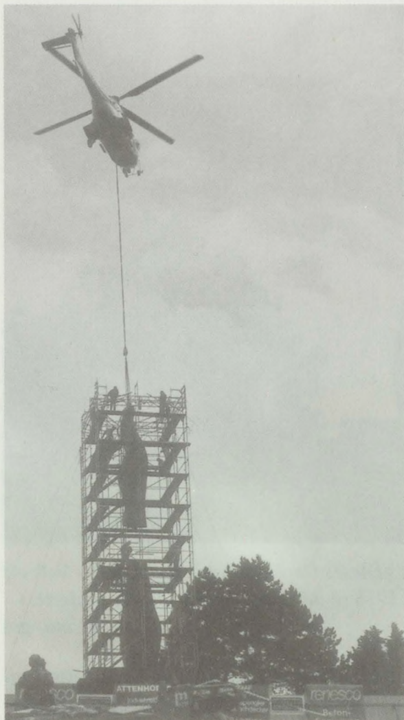
1990: Während der Renovation wurden die einzelnen Teile der Flamme durch die Luft – per Helikopter – hin und her transportiert. Eine Sensation für viele Schaulustige.
