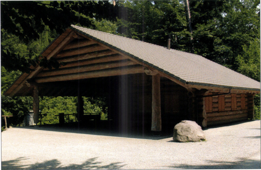
Waldhütte Maur unterhalb des Weilers Stuhlen.
