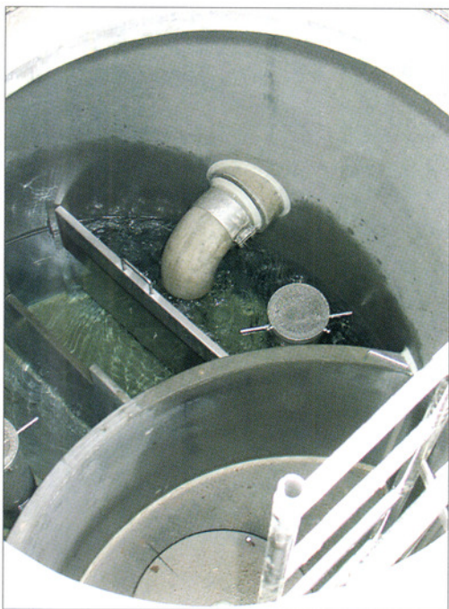
Eine Quelfassung oberhalb der Hellstrasse bei Maur: Nachdem das Oberflächenwasser durch den Waldboden zum Grundwasser gesickert ist und aus Quellen wieder zu Tage tritt, hat es einwandfreie Trinkwasserqualität.
