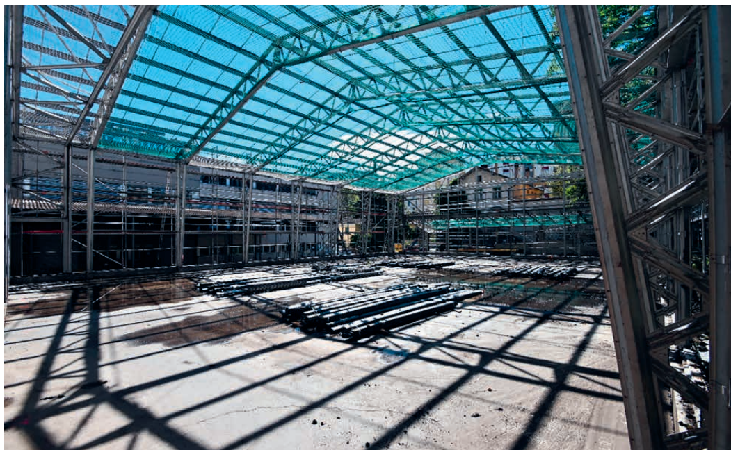
Rohgerüst der Polynormhalle beim Abbau in Freiburg.
