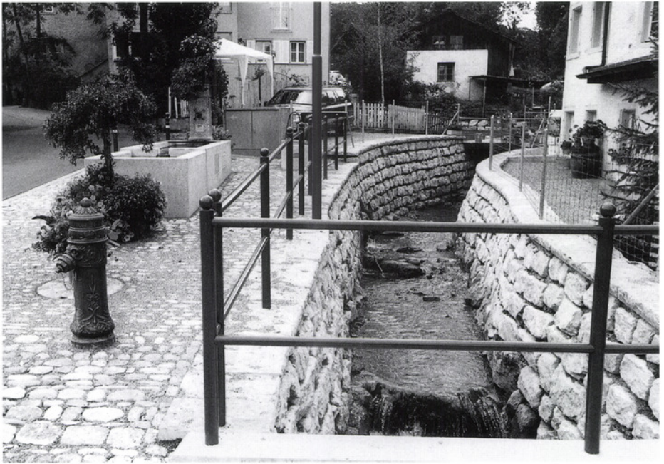
Das neue Dorfbild in Stettbachs Zentrum. Geköpfte Bollensteine umrahmen den neu gestalteten Brunnen. Die Bachmauern erhielten roh behauene Steine aus graugelbem Lägerkalk.
