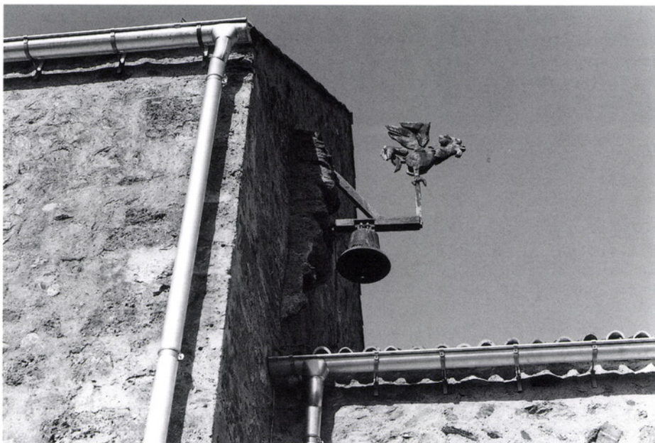
Umfassende Sanierung der Lazariterkirche Gfenn: Die neu angebrachte Dachrinne verhindert ein erneutes Feuchtwerden des Mauerwerks.
