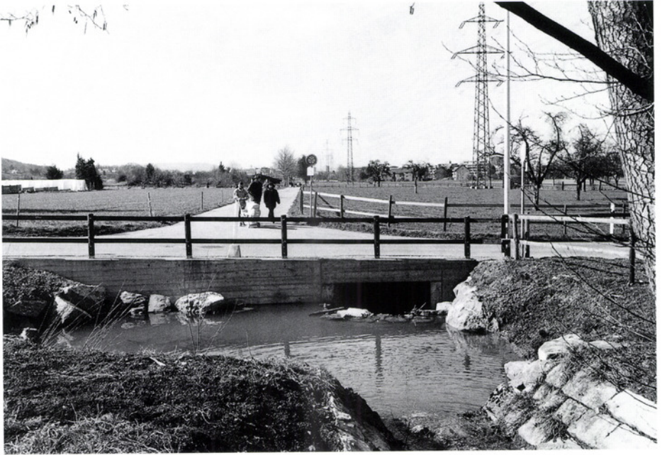
Viele Bächläufe mussten Veränderungen hinnehmen, der Kirchbach wurde gar gänzlich eingedeckt. Hier der Beginn der Dole des 1952 bei der Neuführung des ehemaligen Wilerbaches geschaffenen, heutigen Breitibachs mit der Einmündung des Schlossbaches Untere Geerenstrasse/Schützenhausstrasse.
