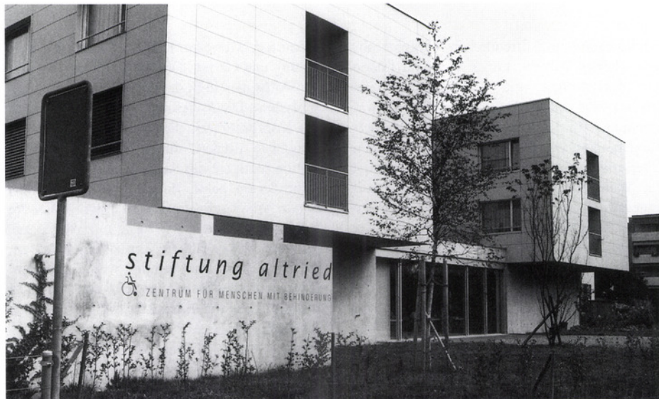
Die Stiftung Altried realisierte an der Kreuzung Überlandstrasse/Zwinggartenstrasse das von Architekt Bob Gysin entworfene neue Wohn- und Arbeitsheim «Memphis».
