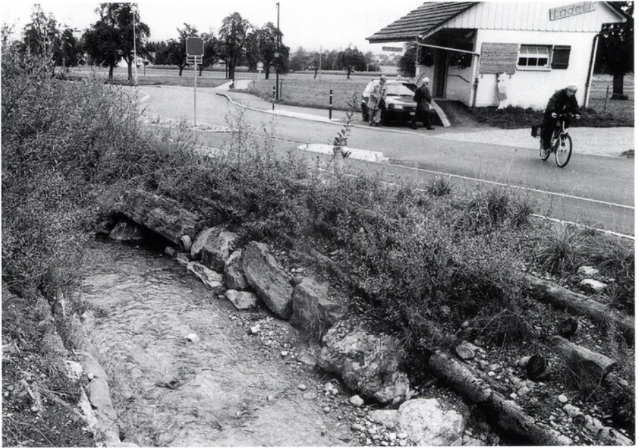
Der Sagentobelbach bei der Milchhütte Stettbach, seine Aussenkurven sind mit Grünholzwällen verbaut, biegsame und tief wurzelnde Weiden sorgen für die Stabilität der Böschungen.
