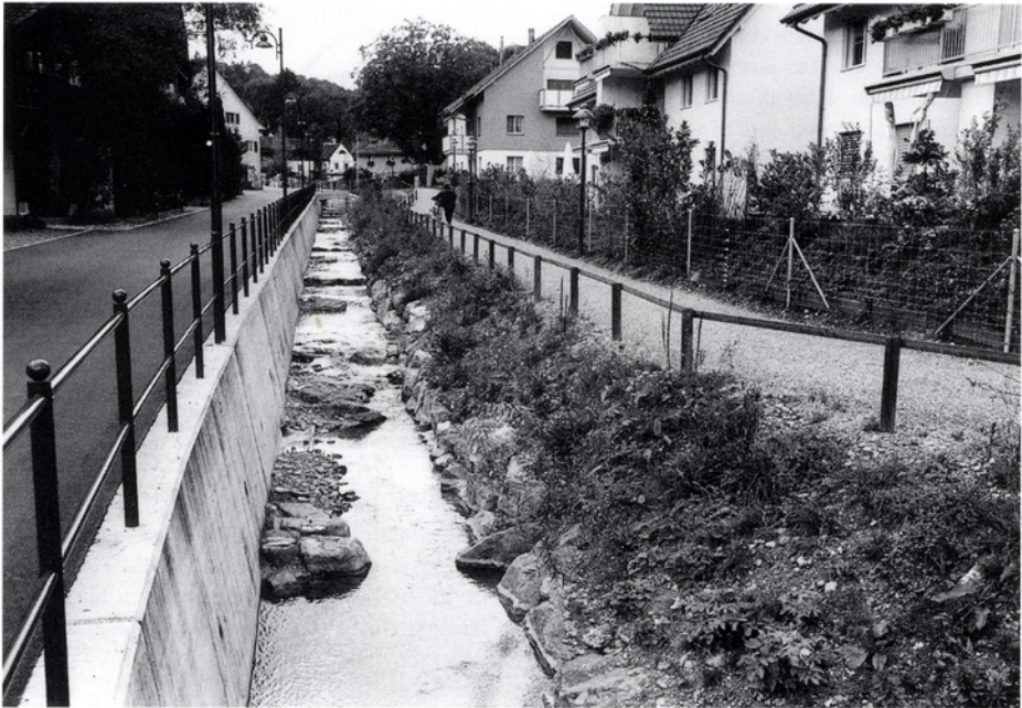
Das breite, naturnah gestaltete Bett des Sagentobelbaches entlang der Stettbachstrasse. Am linken Ufer der neu geschaffene Fussgängerweg und die Wohnsiedlung «Am Sagentobelbach».
