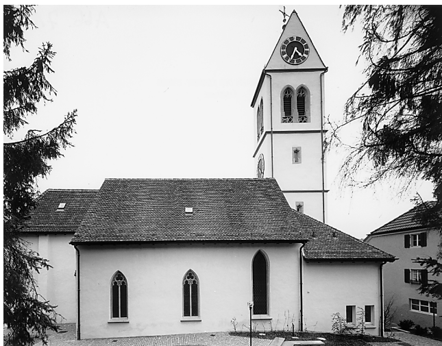
Abb. 71. Winterthur-Veltheim. Die Nordseite der renovierten Kirche mit der 1893 erneuerten Saalordmauer und dem Westvorbau von 1931.
