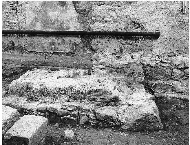
Abb. 43. Winterthur-Veltheim. Das Ostende von Chorsüdmauer 6A mit dem profilierten Sandsteinsockel. Der nachträglich an der Ecke errichtete Strebepfeiler 6C (Bauphase VI) ist im Aufgehenden mit Errichtung des spätgotischen Chors, dessen Nordmauer rechts im Bild zu sehen ist, wieder abgetragen worden.
