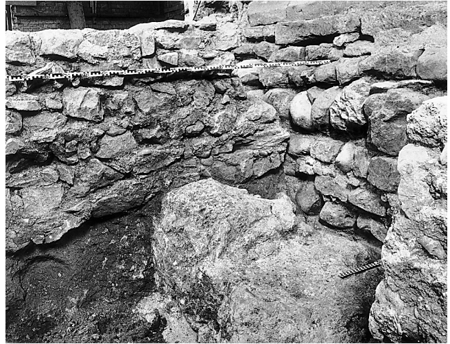
Abb. 48. Winterthur-Veltheim. Aussenseite von Annexostmauer 9 (links), die im Norden gegen Chormauer 6A stösst (vgl. auch Abb. 29).
