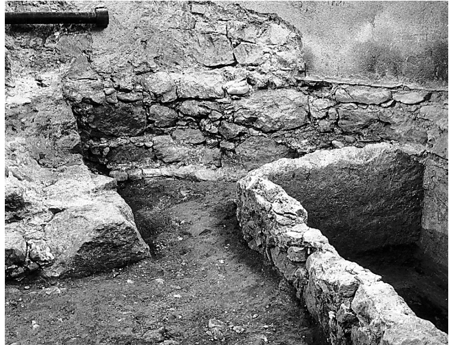
Abb. 61. Winterthur-Velheim. Vom Putz befreite obere Fundamentpartie der Chormauern 6B, 10 und 7, links davon der ältere Strebepfeiler 6C, rechts im Bild die 1774 gebaute Gruft 1 von Pfarrer Johann Conrad Füssli.
