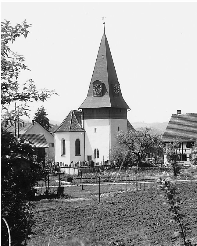
Abb. 98. Der Chorturm der Pfarrkirche von Zell, Blick von Nordosten.
