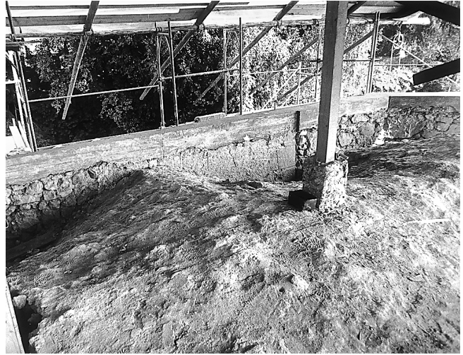
Abb. 55. Winterthur-Veltheim. Blick von Südwesten über das spätgotische Chorgewölbe auf die obere Partie der Chorturmsüdmauer, deren Ecken aus sorgfältig bearbeiteten Grossquadern bestehen. Rechts schliessen die heutigen Chormauern 6B und 10 (Bauphase VIIa) an.
