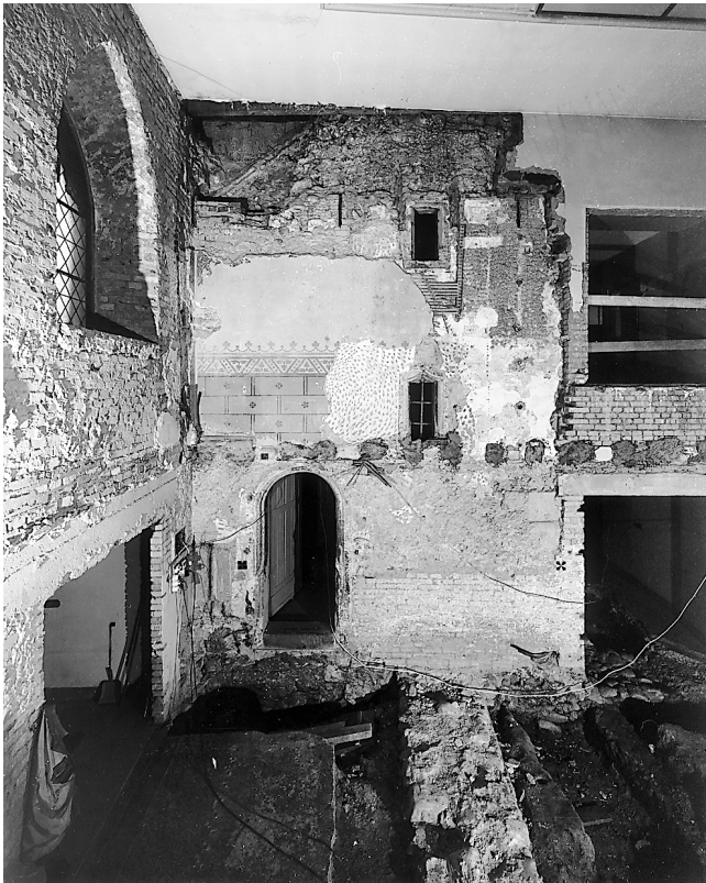
Abb. 67. Winterthur-Velheim. Fotogrammetrische Aufnahme der Turmostmauer 33 mit der von einem Viereckstab gefassten Rundbogentür und der reich profilierten Lichtöffnung zu der dahinter liegenden Wendeltreppe. Eine grossflächige neuzeitliche Backsteinflickung befindet sich zwischen der Rundbogentür und dem von 1931 stammenden Westeingang. Oben links unter der heutigen Decke der schräge Anschlag des spätgotischen Schiffdachs.
