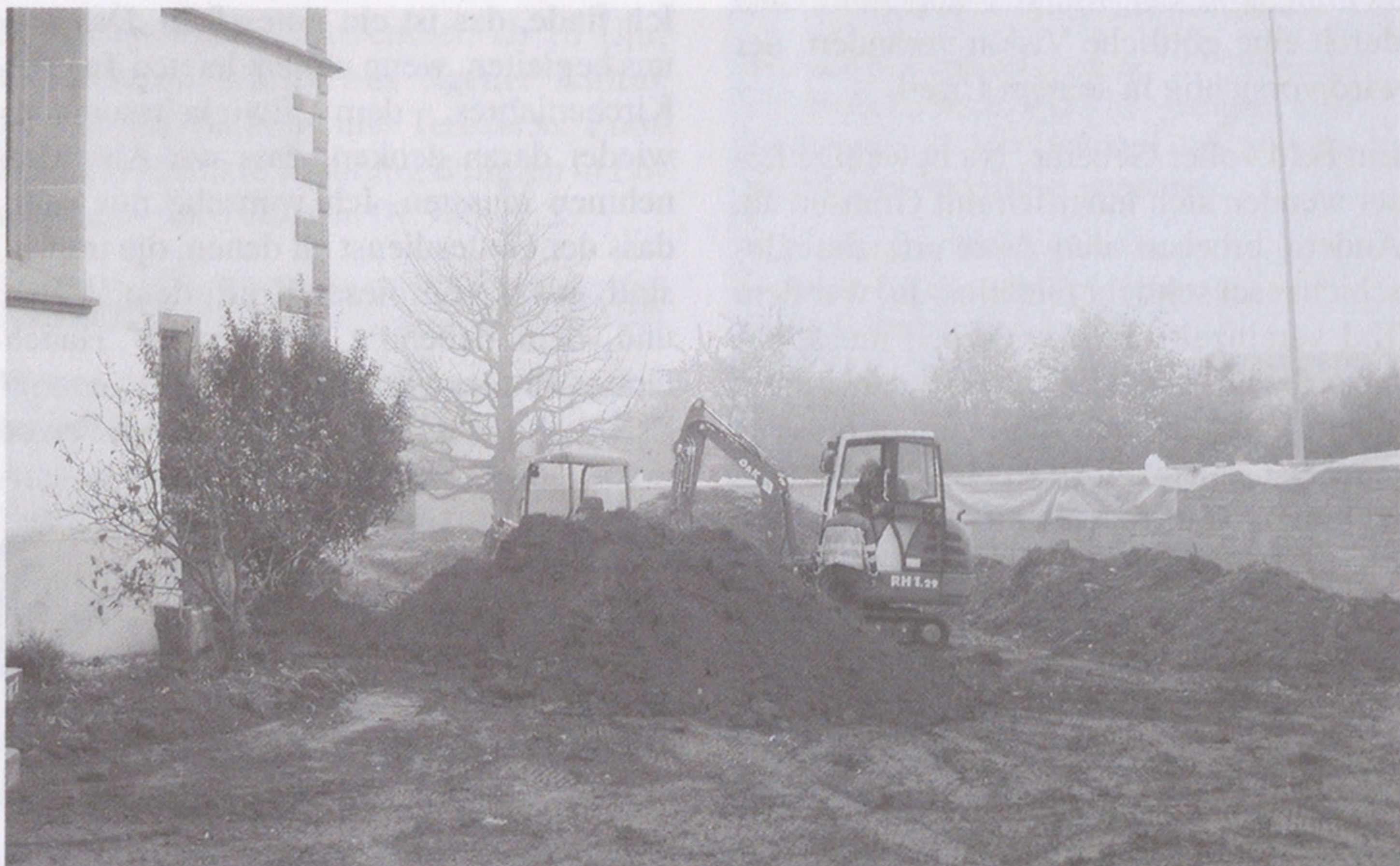
Die neue Friedhofsmauer steht und sieht von «innen» wesentlich besser aus als momentan noch von aussen. Nur einige wenige Knochen fanden sich beim Aushub der neuen Mauer. (Foto: kim)
