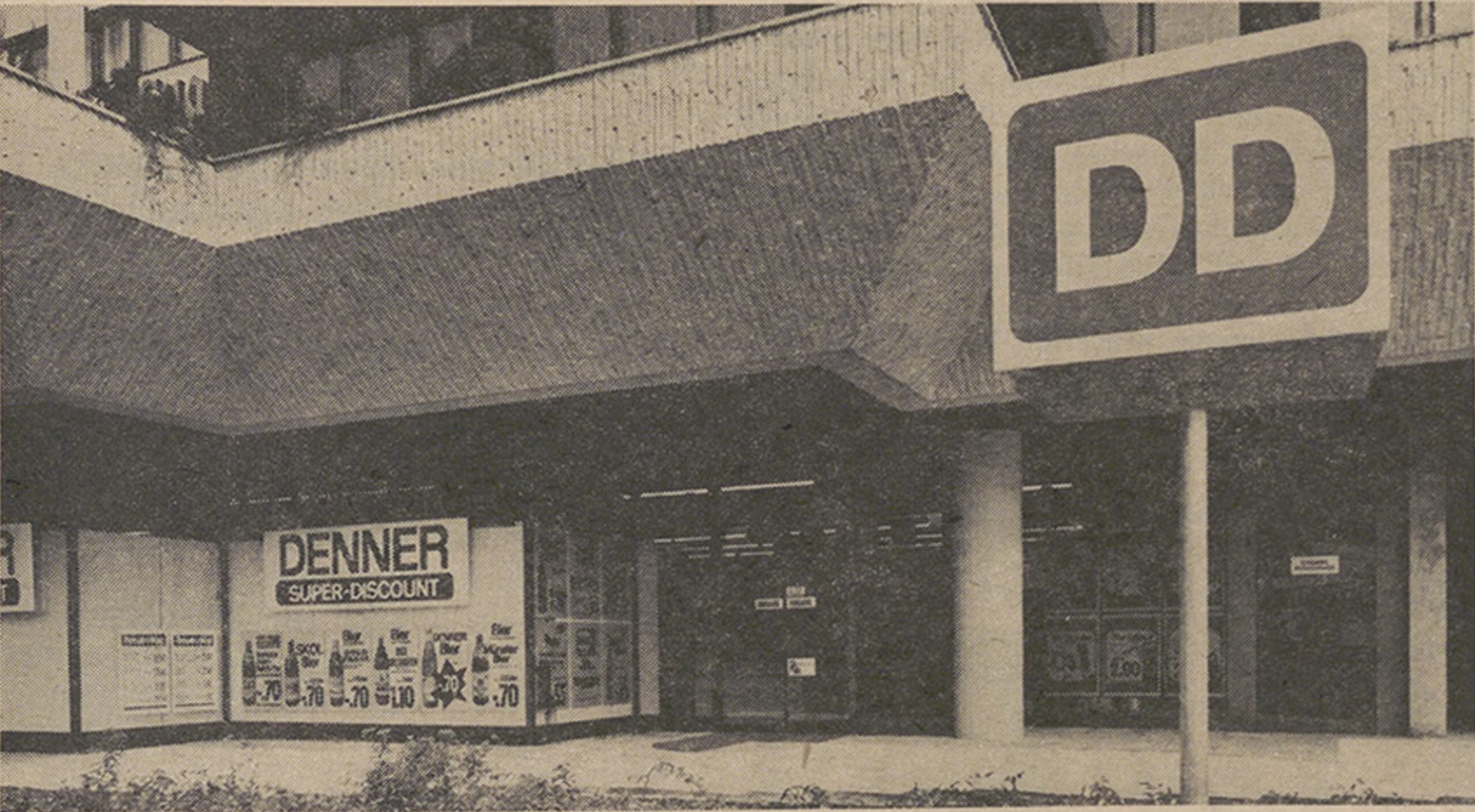
Der Denner Super-Discount Hofwiesenstrasse in Zürich weist eine Totalfläche von 425 m2 auf, wovon 320 m2 reine Verkaufsfläche sind und 105 m2 für Warenumschlag und Büro bestimmt sind. Die Ware ist auf 123 Meter Gestellen und auf 22
