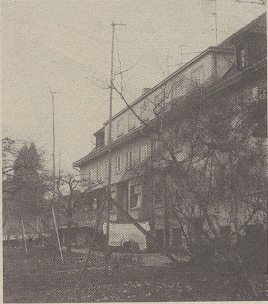
Alter Bau mit Baugespann für den Umbau (März 1986). Die beiden hohen Stangen zeigen den längeren Flügelbau, östlich; hinten ist die Markierung des kürzeren westlichen Flügels zu sehen.
