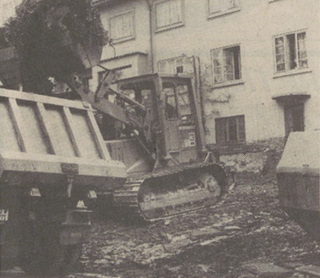
Beginn des Aushubes für die Garage (April 1986). Die früher ebenerdige Kellertüre hängt bereits etwas in der Luft.
