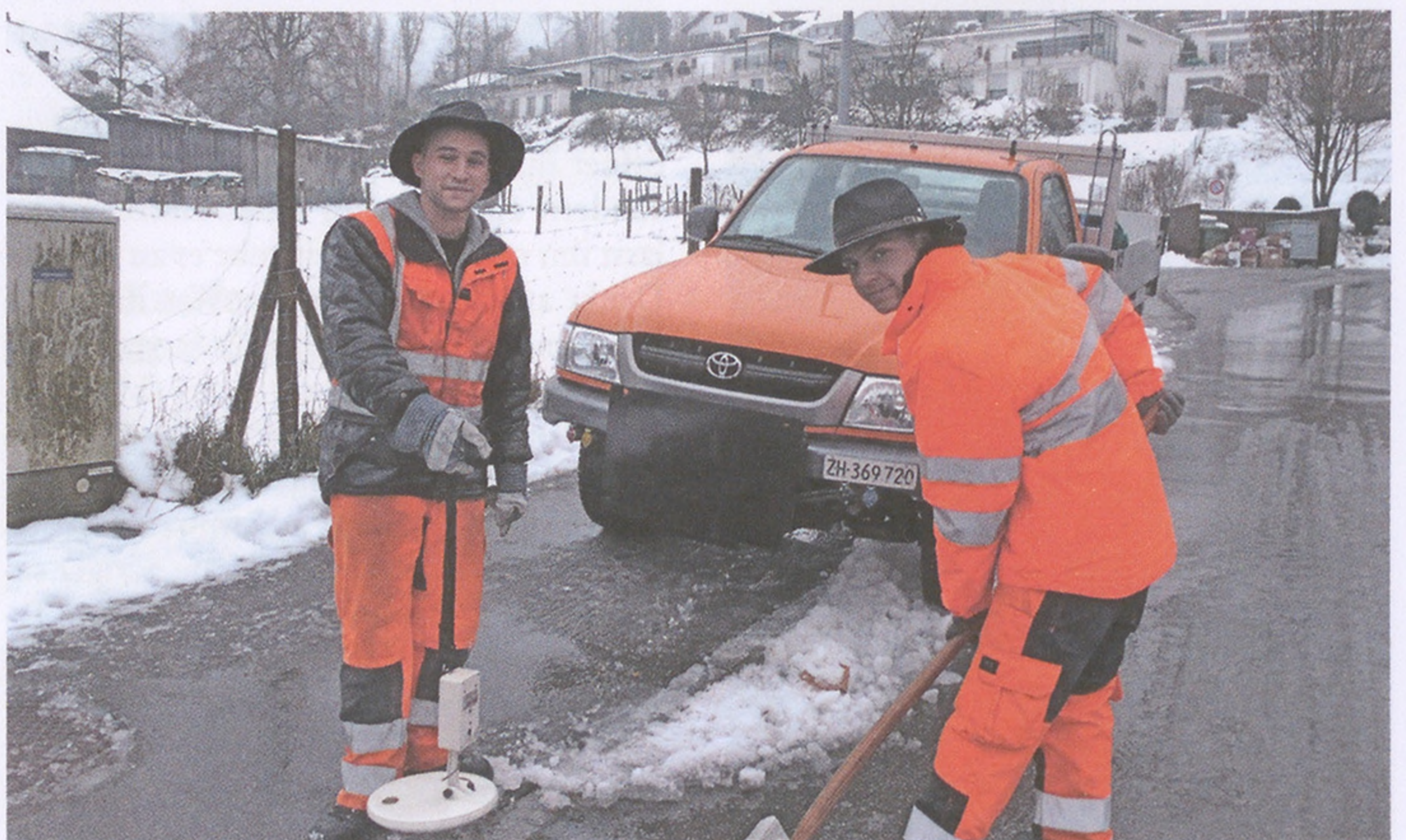
Nach Schnee der Regen: Die beiden Maurmer Gemeindearbeiter Oliver Hürzeler (links) und Egzon Bajrani müssen für das Schmelz- und Regenwasser die schneebedeckten Schächte freimachen, damit das Wasser ungehindert abfliessen kann. (Foto: pi)
