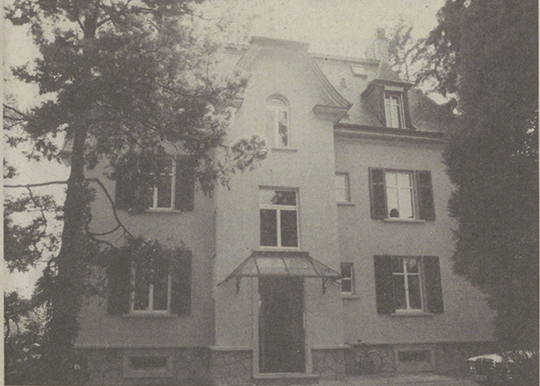
Abb. 9: Eingangs-Fassade gegen die Limmattalstrasse mit gut sichtbarem Bruchsteinsockel.
