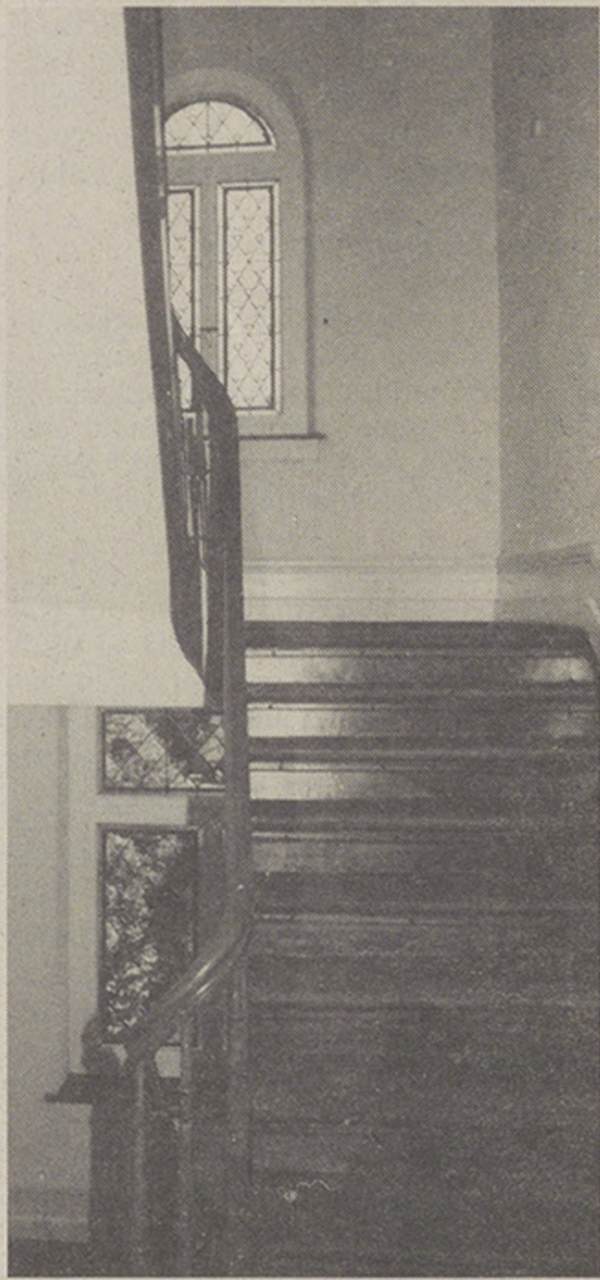
Abb. 10: Treppenhaus mit kunstvoll verglasten Fenstern aus der Bauzeit des Hauses.
