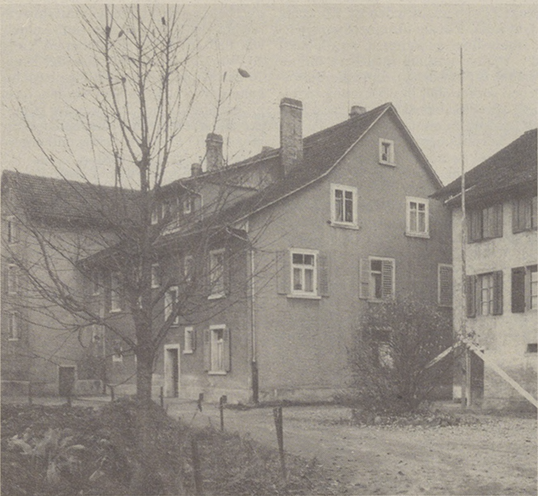
Abb. 3: Elternhaus von Rudolf Nötzli-Gwalter, Hardeggsstrasse 9, abgebrochen 1980.
