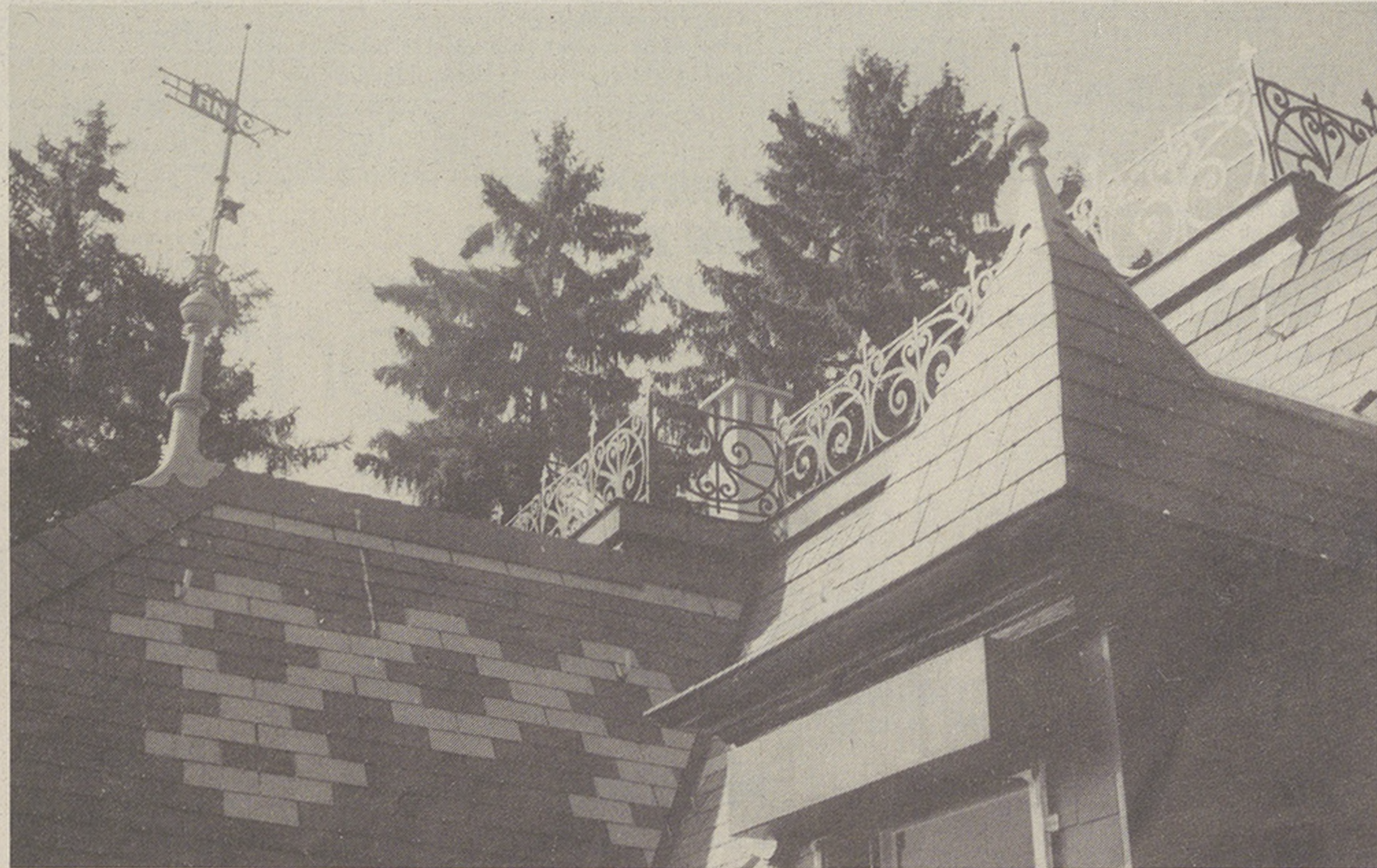
Abb. 12: Windfahne mit Initialen R. N. des Erbauers; das Muster der Dachflächen wurde nach vorgefundenen Spuren rekonstruiert.
