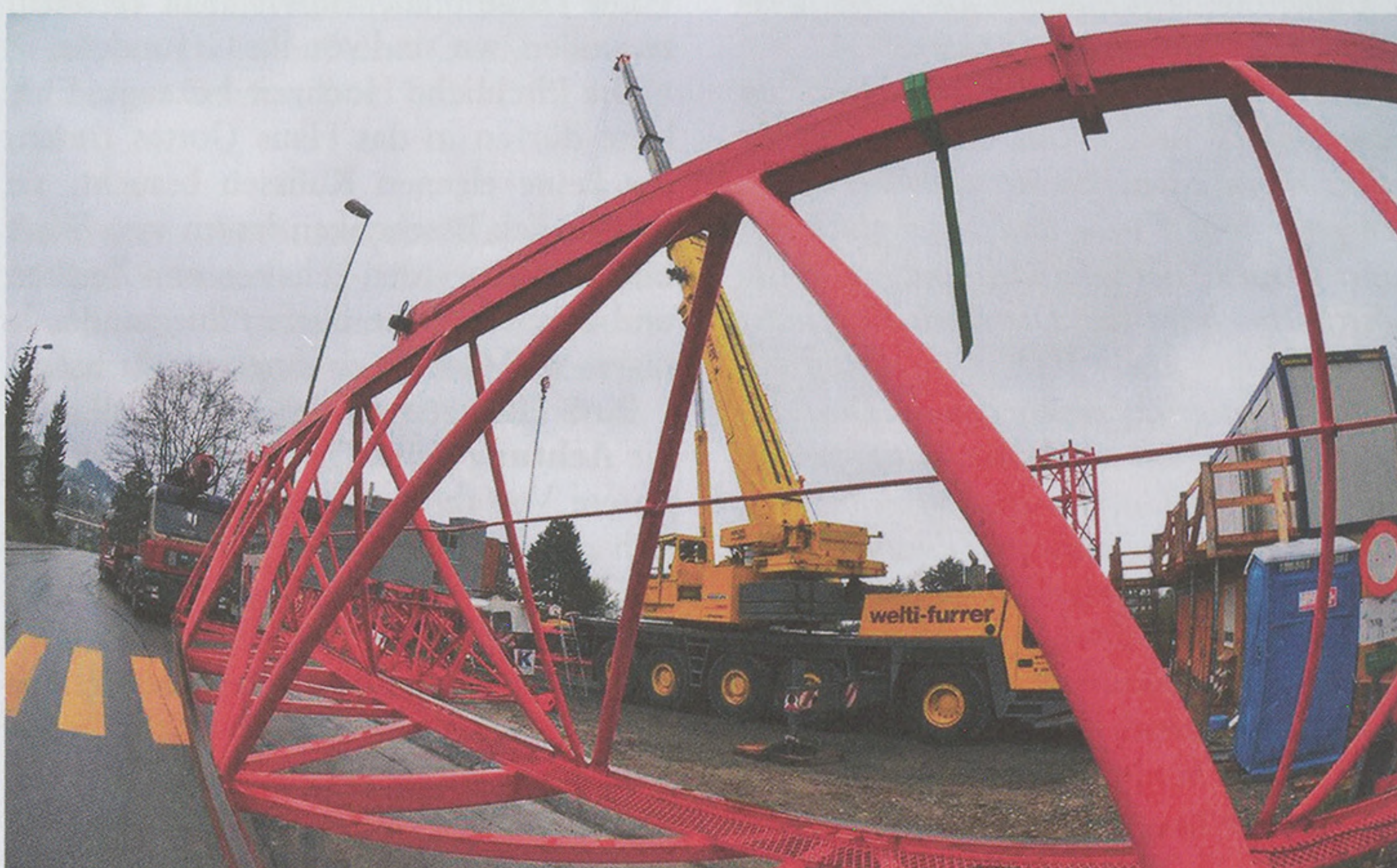
Montag, 13 Uhr, Baustelle Zollingerheim, Aesch/Forch: Ein riesiger Pneukran von Welti-Furrer stellt den Baukran auf. Diese Arbeiten sind in einem Tag erledigt. (Foto: pi)
