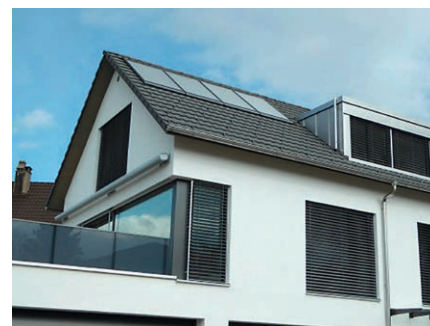
Neubau der Familie Nauer in Oberwil-Lieli AG, mit Solarkollektoren unterhalb des Firsts auf der Ostseite des Daches
