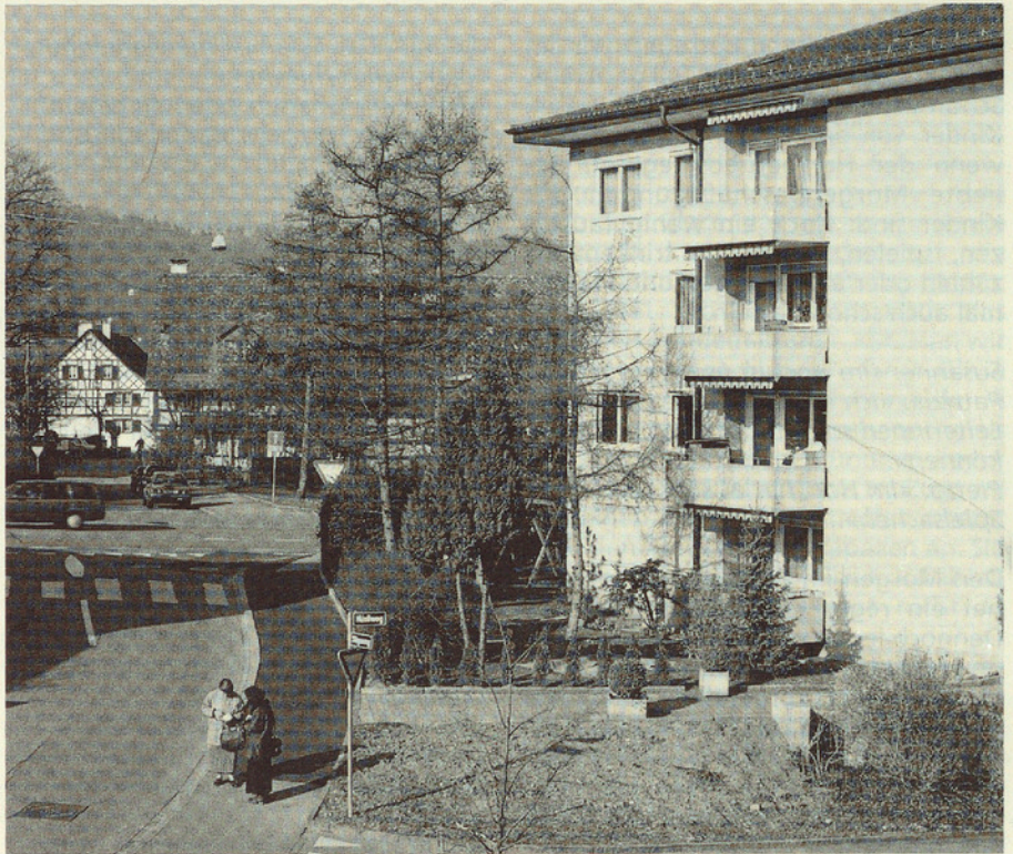
Moderne Technologie unter dem Garten: Trafo- und Gleichrichterstation Hüsliweg.
