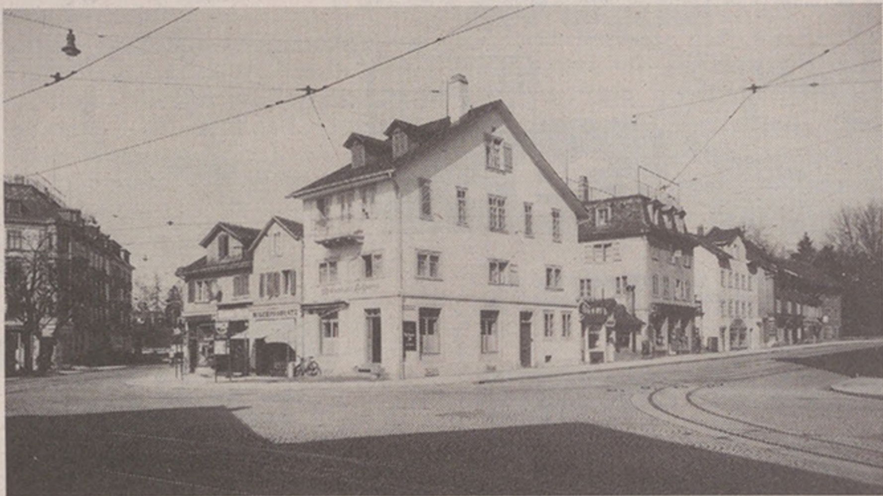
Die vom Abbruch bedrohte Häusergruppe am Kreuzplatz in einer Aufnahme von 1944: Der Stadtzürcher Heimatschutz plädiert für einen Neubeginn der Planung und für eine Chance für das historische Vorstadtensemble. (Einzig die Liegenschaft am äussersten rechten Bildrand wurde zwischenzeitlich abgebrochen.) Bildquelle: Baugeschichtliches Archiv der Stadt Zürich
