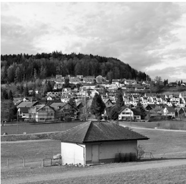
Das Herzstück unserer Wasserversorgung – Dieses Jahr steht die Erneuerung der Pumpwerkanlage Trenschan.
