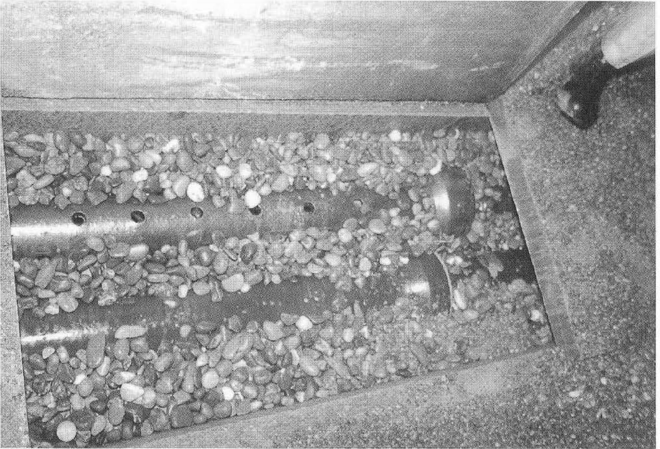
Hier sind deutlich die neuen, gelochten Rohre sichtbar, in die das Quellwasser aus dem Kiesbett sickert.
