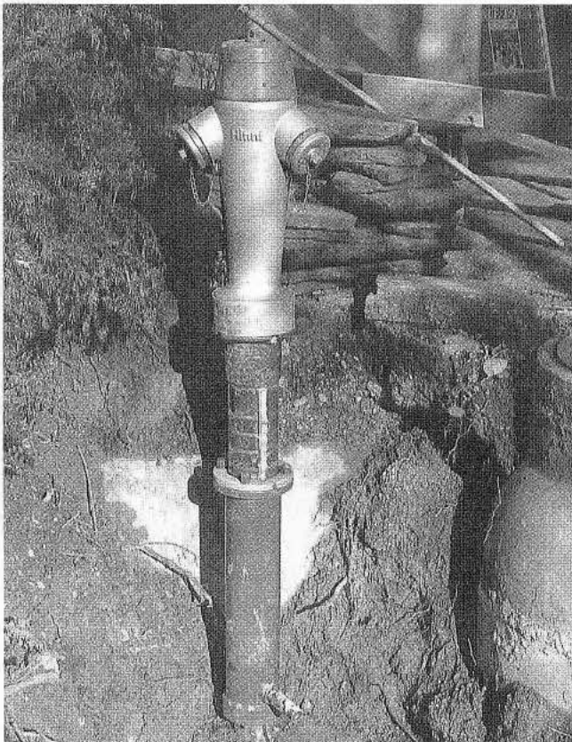
Beim Hydranten ist es wie bei den Kartoffeln: das Wichtigste steckt unter dem Boden. Er steht sozusagen auf seiner eigenen Leitung.
