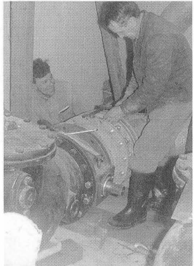
Der Werkangestellte A. Hollenweger und Strassenmeister E. Bräm bei der Montage im Reservoir Lölmoos.
