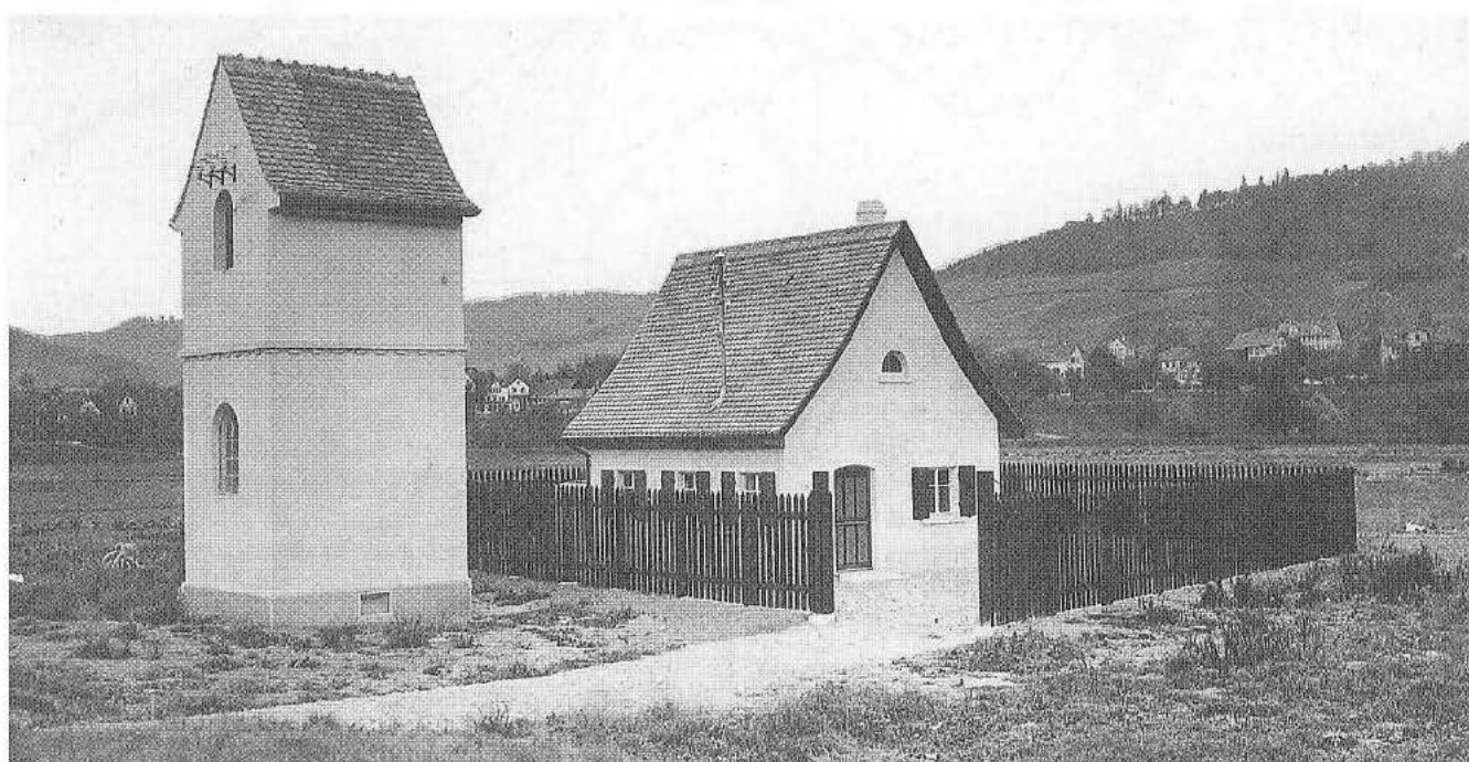
Das erste Grundwasserpumpwerk Schlierens, Betschenrohr I; rechts das Pumpenhaus, links die Transformatorstation.
