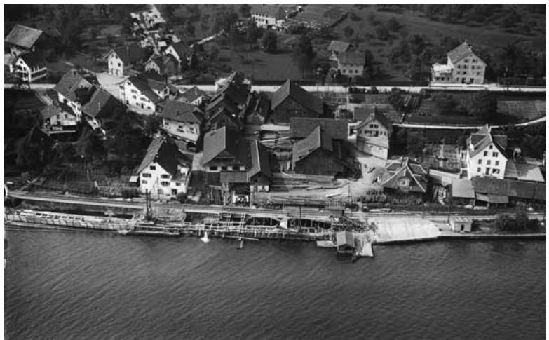
Sägerei Suter in Käpfnach beim Doppelspurausbau SBB, 1924.
