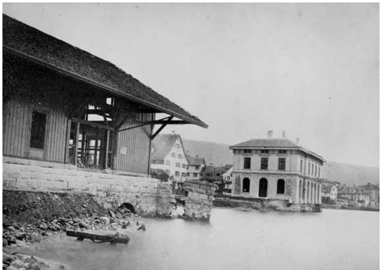
Abgesunkener Bahnhof und Güterschuppen Horgen, 1875.
