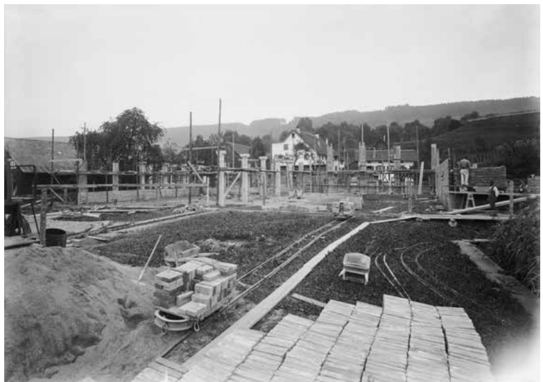
Die Flughalle im Bau. Links die Yachtwerft von Johann Faul, 1920.
