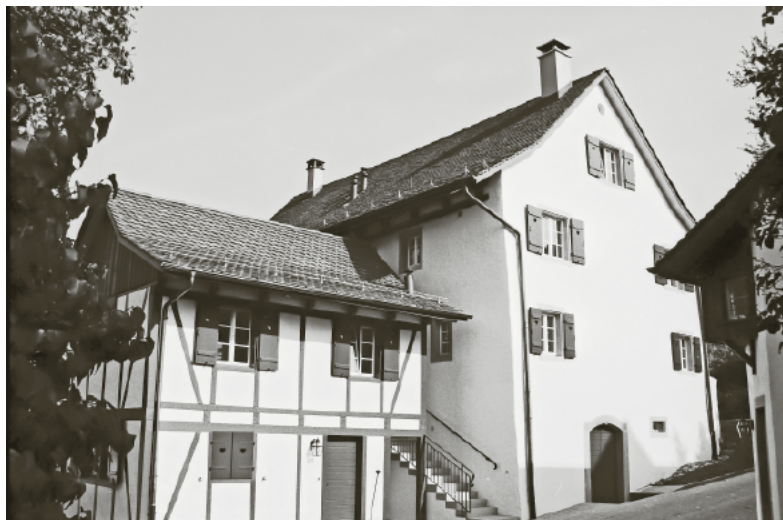
Der Gasthof Löwen mit Badstube und Metzgerei ist bereits 1754 in Herrlibergers Topographie abgebildet, wurde aber 1799 in seine heutige Form umgebaut.
