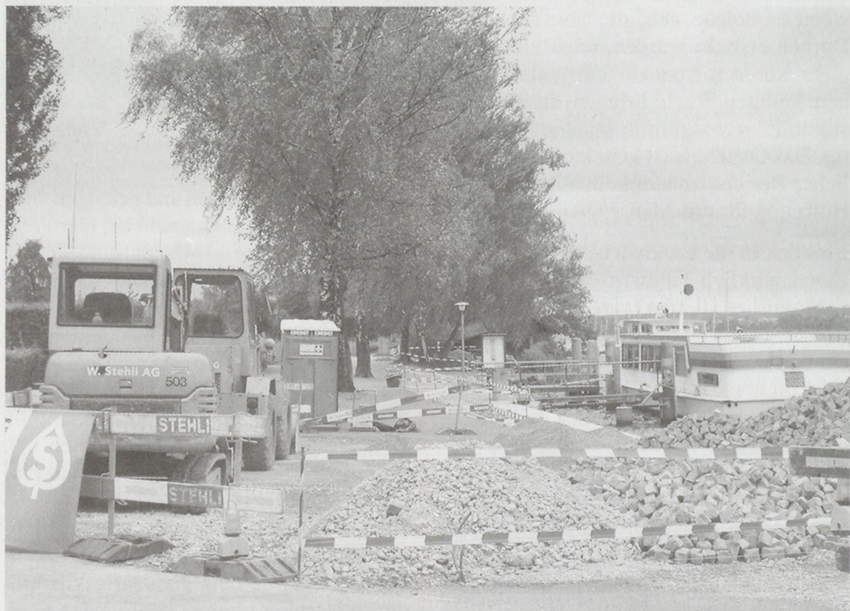
Der Umbau an der Schiffflände macht Fortschritte.
