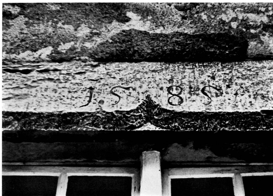
Datierter Fenstersturz der oberen Mühle von 1585
