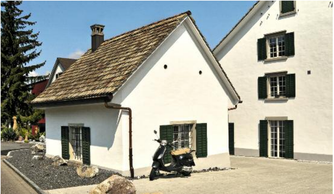
Waschhaus Einsiedlerstrasse 11a nach der Renovation, 2011.
