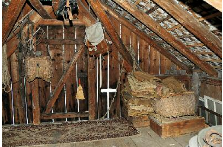
Dachraum des Waschhauses im «Hüsli», 2011.
