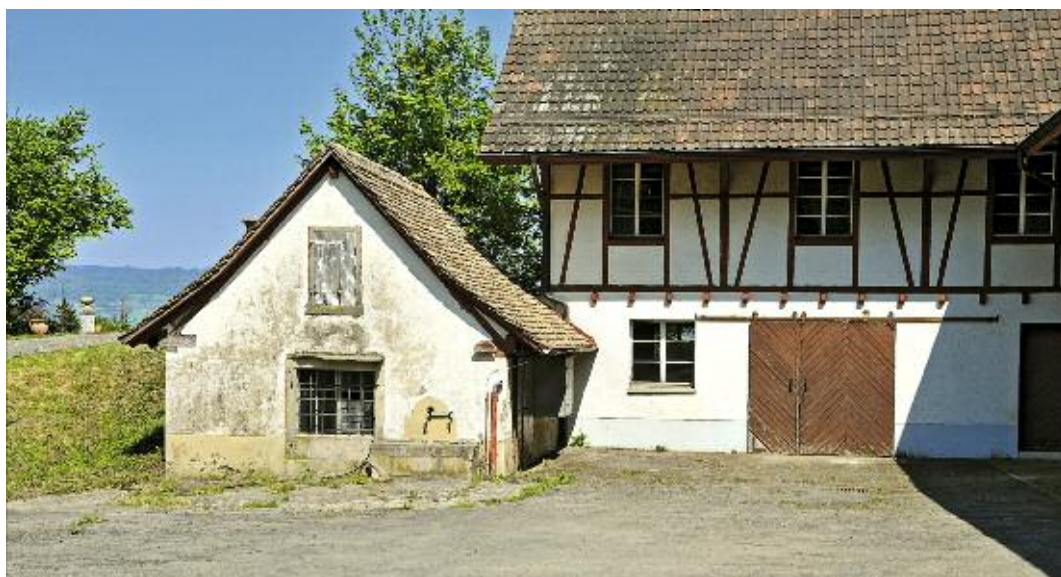
Oben: Zu Wohnzwecken umgebautes Waschhaus im Langacher, 2011.
