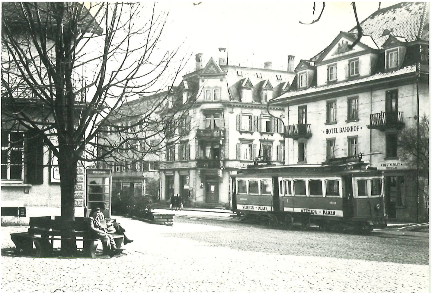
Bahnhofplatz Meilen, 28.2.1948 Foto J. Wetzel
