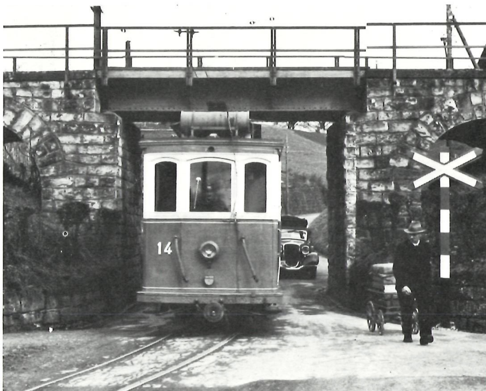
Durchfahrt unter der SBB- Linie Obermeilen Foto Tiefbauamt des Kantons Zürich
