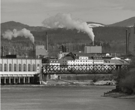
Abb. 3: Eisensteg beim alten Kraftwerk Rheinfelden
