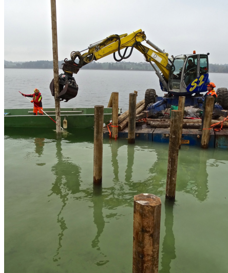
Abb. 27: Bei der Sanierung der Fischerstege wurden die neuen langen Eichenpfähle von einem auf einem Floss schwimmenden Bagger – präzis positioniert – in den Grund gerammt. (Foto E. Ott)
